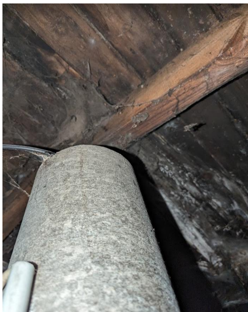
Foto 34. Kanaliseaduse tuulutustoru.
