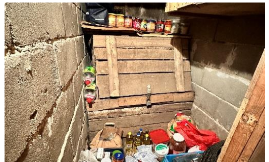
Foto 27. Siseseinad keldrikorruse abiruumis.
