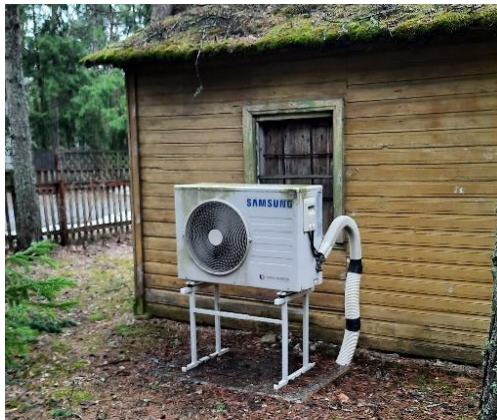
Foto 79. Soojuspump Samsung EHS väliseade.
