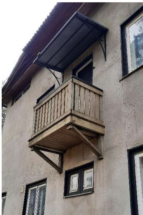
Foto 57. Rõdu hoone põhjaküljel.
