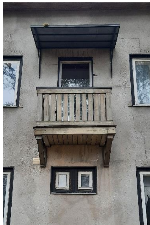
Foto 58. Rõdu hoone põhjaküljel.
