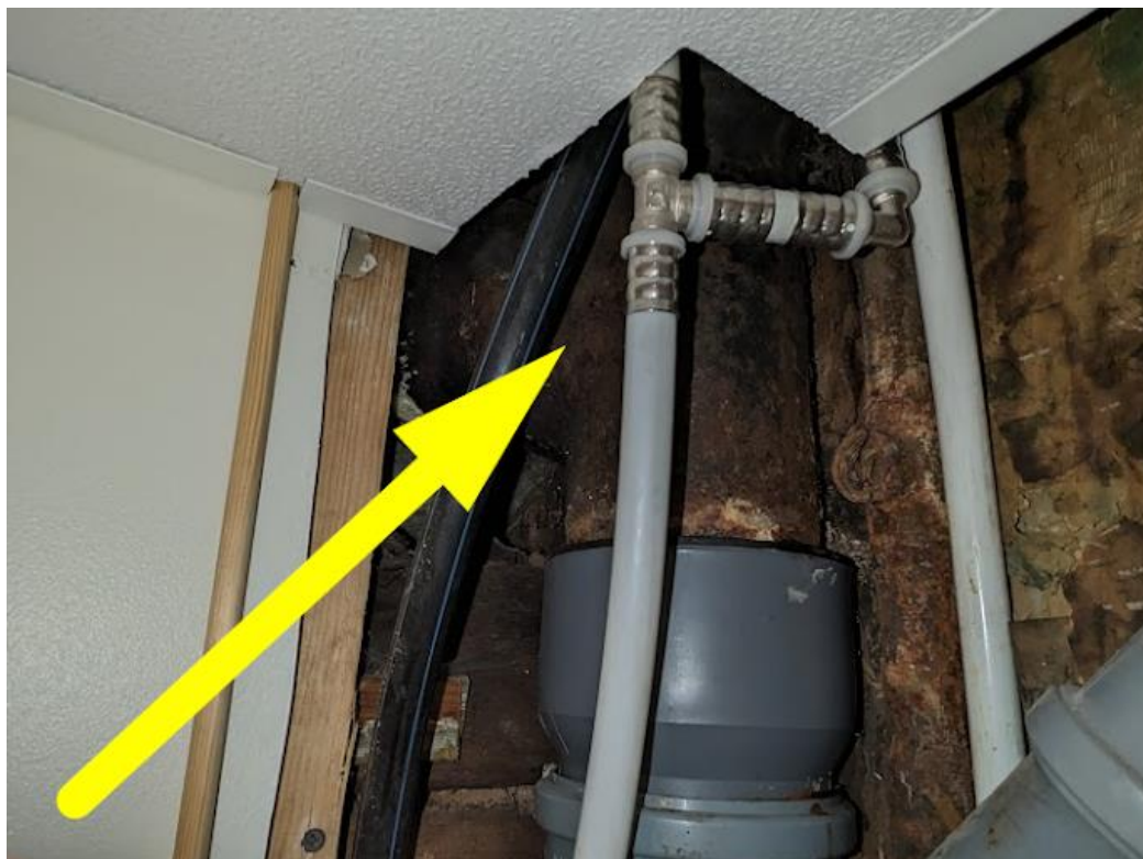
Foto 81. Vanad kanalisatsioonipüstakud.
