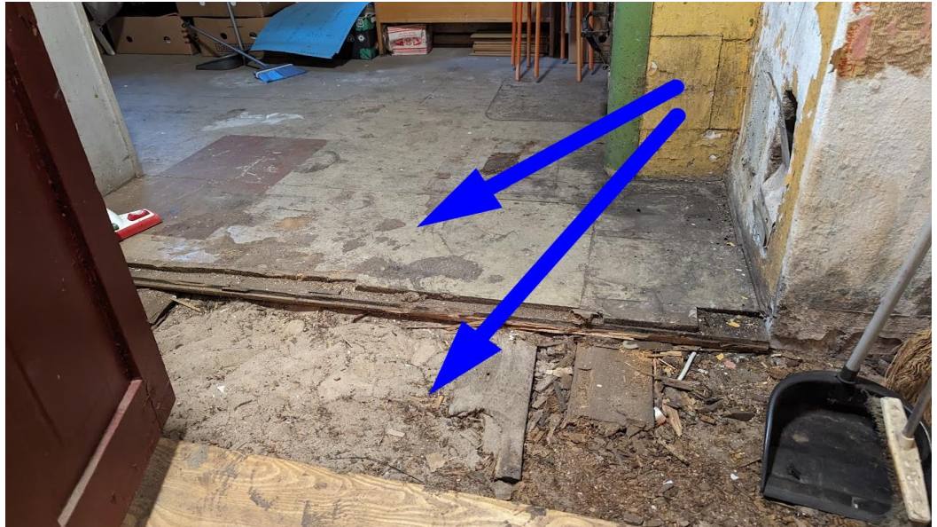
Foto 15. Põrand pinnasel keldrikorrusel.
