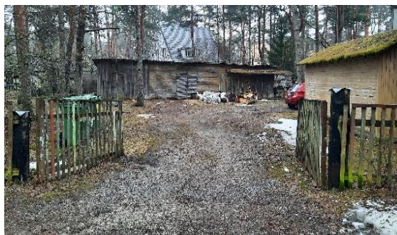
Foto 11. Autovärav kinnistu loodepiiril.
