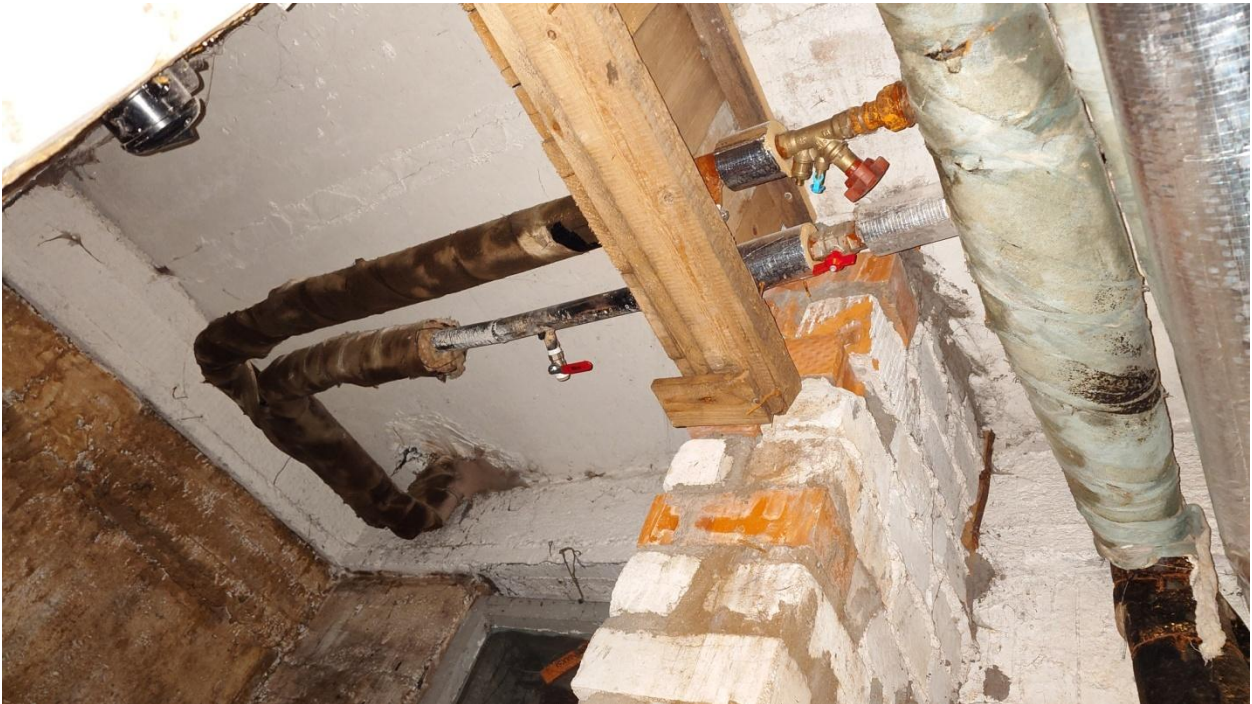
Pilt 8 Küttesüsteemi püstikutele paigaldatud tasakaalustus ventiidid.
