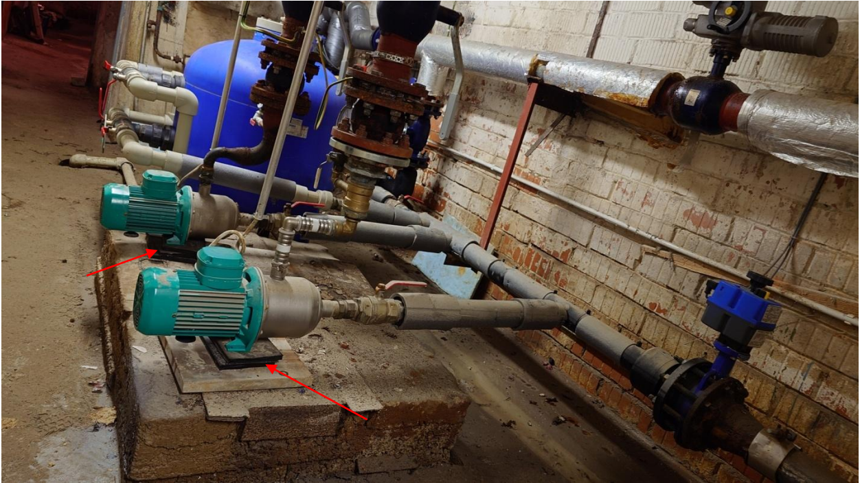
Pilt 12 Tarbevee rõhutõstepumbad kinnitamata.
