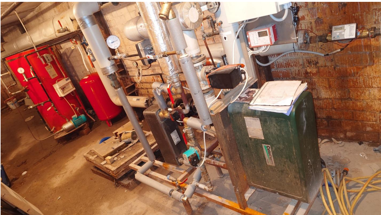
Pilt 3 Hoone soojussõlm.
