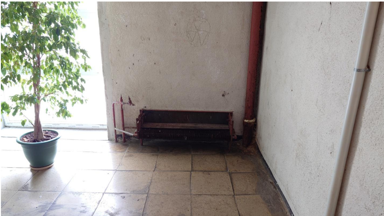
Pilt 7 Küttekehad trepikojas hooneehitusaegsed konvektorid.
