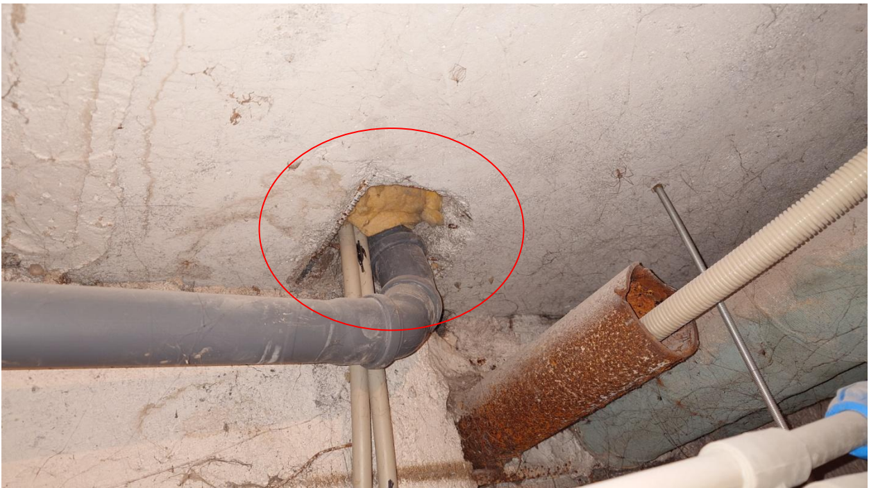
Pilt 17 Torude läbiviik tuletõkke tsoonist ei vasta nõuetele.
