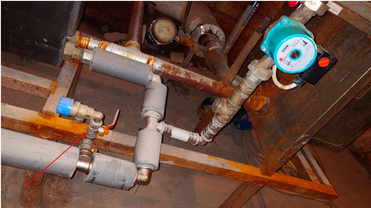
Pilt 4 Kaitseklappi ees suletud kuulkraan. Kaitseklappi ees ei tohi olla sulgarmatuuri.
