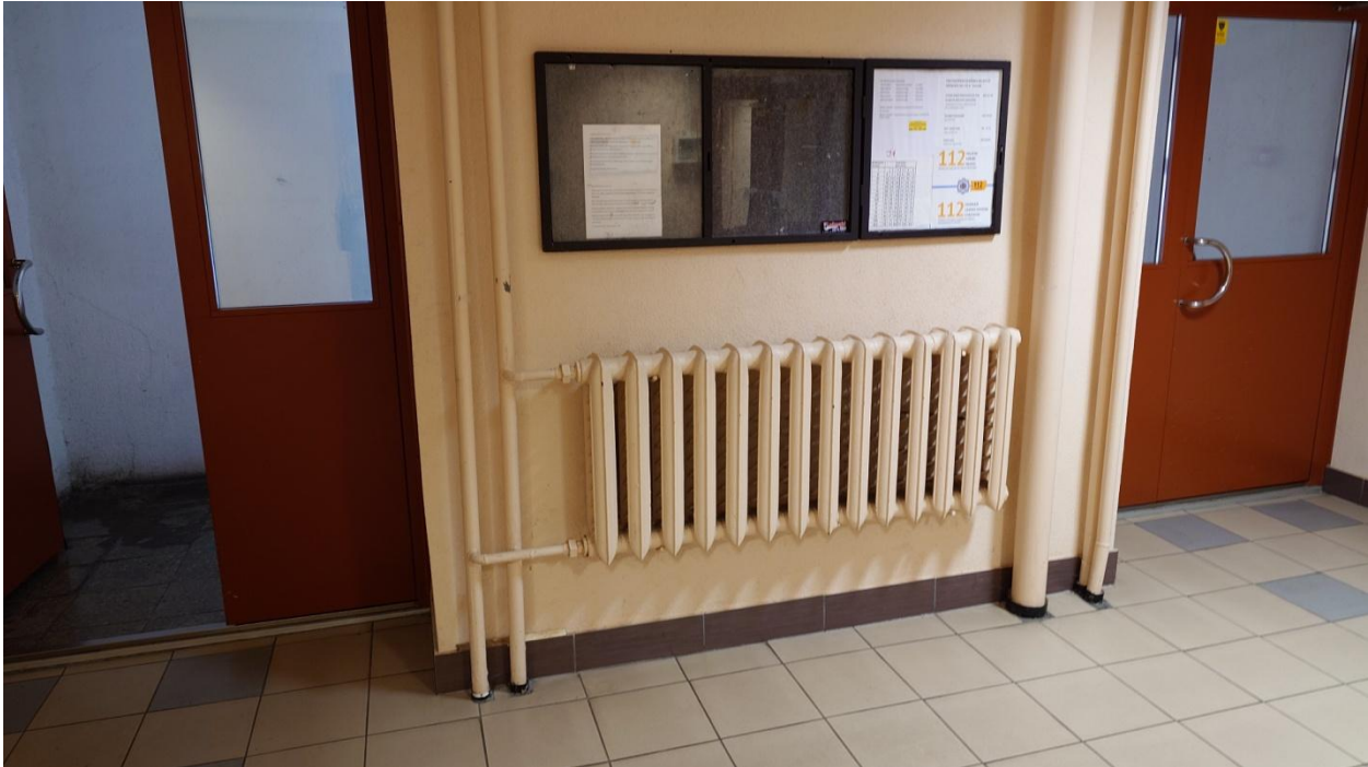
Pilt 6 Küttekehad trepikojas hooneehitusaegsed malmradiaatorid.
