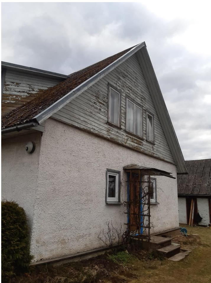
Foto 2: Vaade lammutatavale elamule põhjast.
