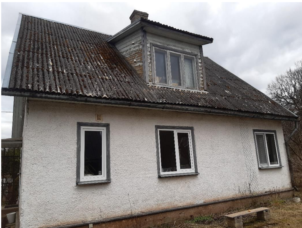
Foto 3: Vaade lammutatavale elamule läänest.
