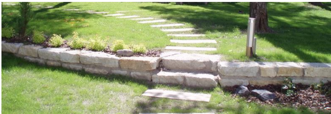
Foto 4 Paekivist serva näide. Kõrgem, 200 mm serv 2-rida müürikive ja madalam 100 mm serv 1-rida müürikive. Foto ja teostus Õismäe Haljastus AS
