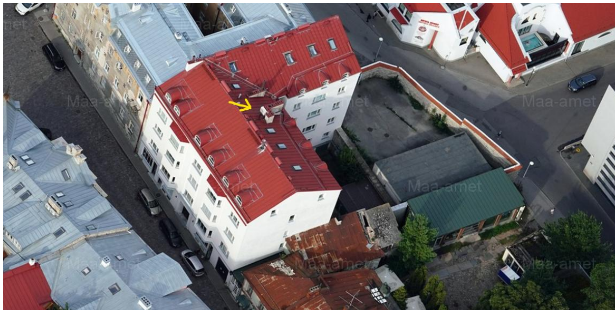
Foto 1, Olemasolev hoone ja projekteeritud seadme asukoht katusel
