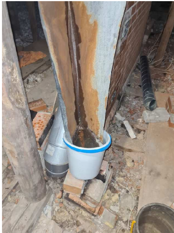
Foto 9. Veeleke korstna kõrval koos hädapärase vee kogumise „süsteemiga“
