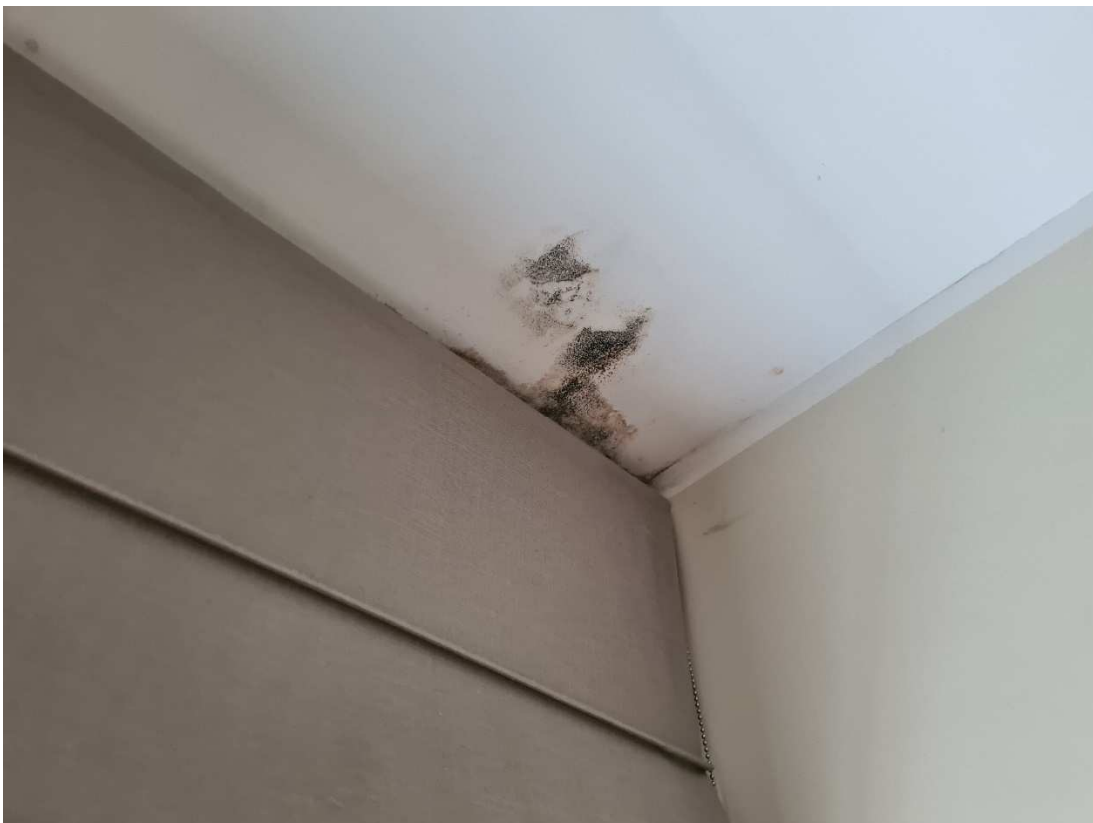
Foto 4. Veekahjustused ja hallitusseente koloonia korteri nr 3 laes
