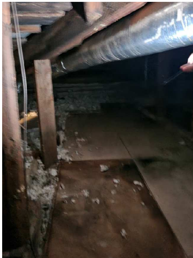
Foto 8. Niiskuse jäljed pööningu käiguteel
