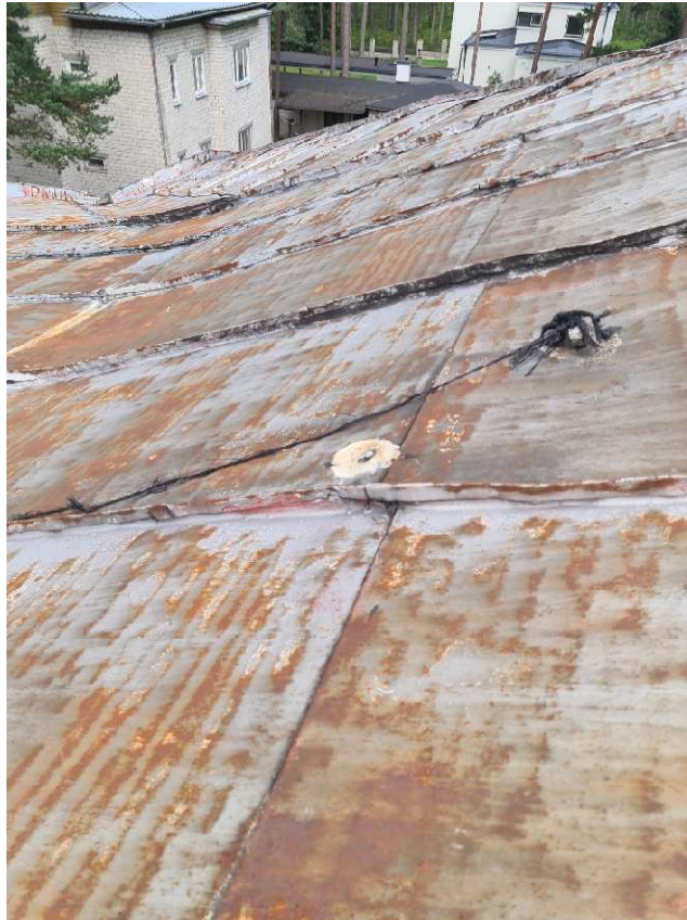
Foto 13. Roostes katuseplekk. Vanad ebatihedad antenni vmt kininnituskohad
