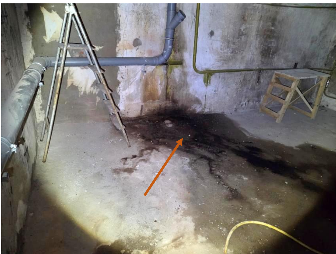
Foto 24. Keldris on niiskuskahjustused, mis vajavad likvideerimist esimesel võimalusel amortiseerumise peatamiseks.
