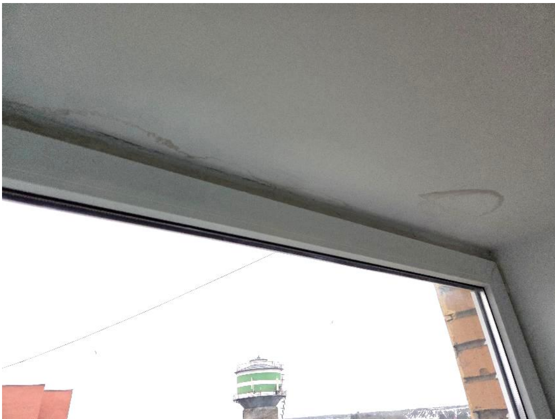
Foto 63. Niiskuskahjustuse jäljed välja vahetatud akna juures.
