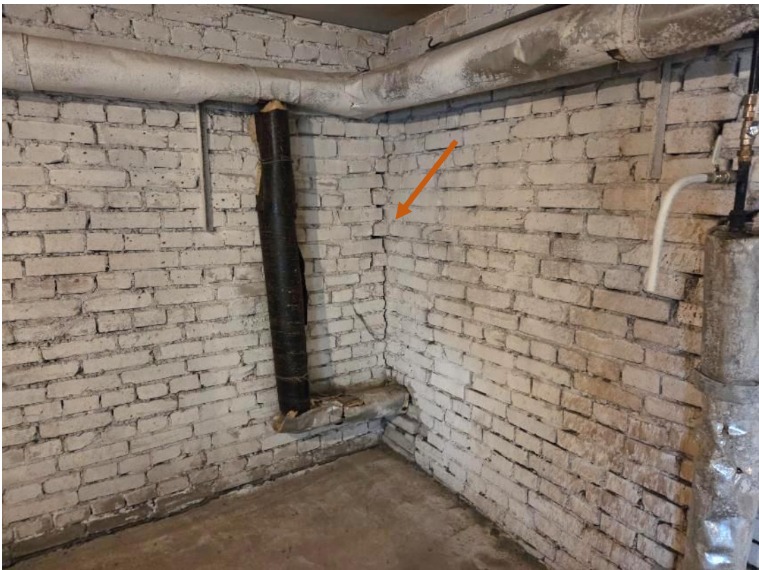
Foto 54. Võtta renoveerimiseni jälgimise alla, vajadusel paigaldada lisarauad, koostada rekonstrueerimisprojekt.
