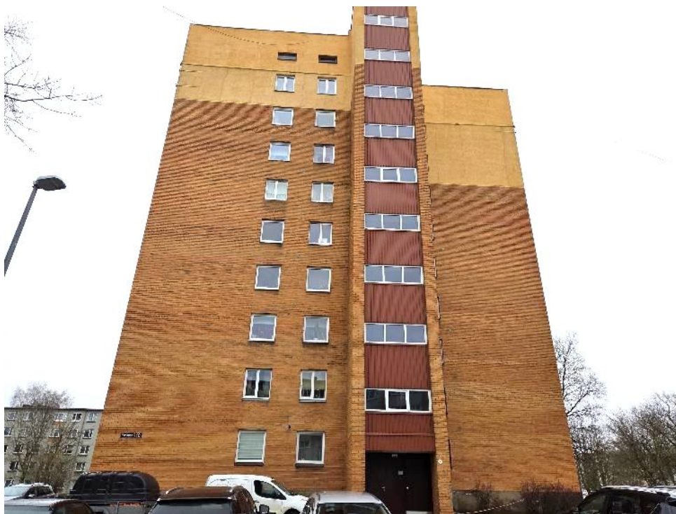
Foto 1. Vaade läänest, hoonest väljaulatuv osa on trepikoda, mille plekist sein ei ole soojustatud.
