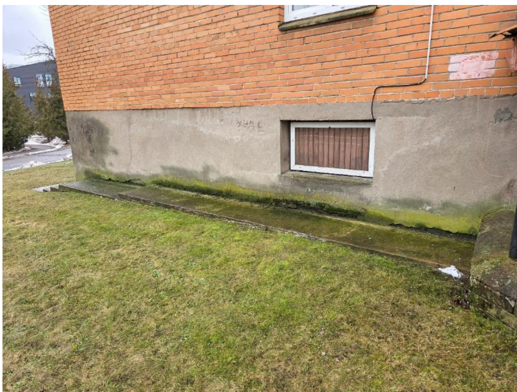
Foto 6. Sillutusribalt üleminek soklile hoone põhjaküljel, näha on niiskuskahjustusi.
