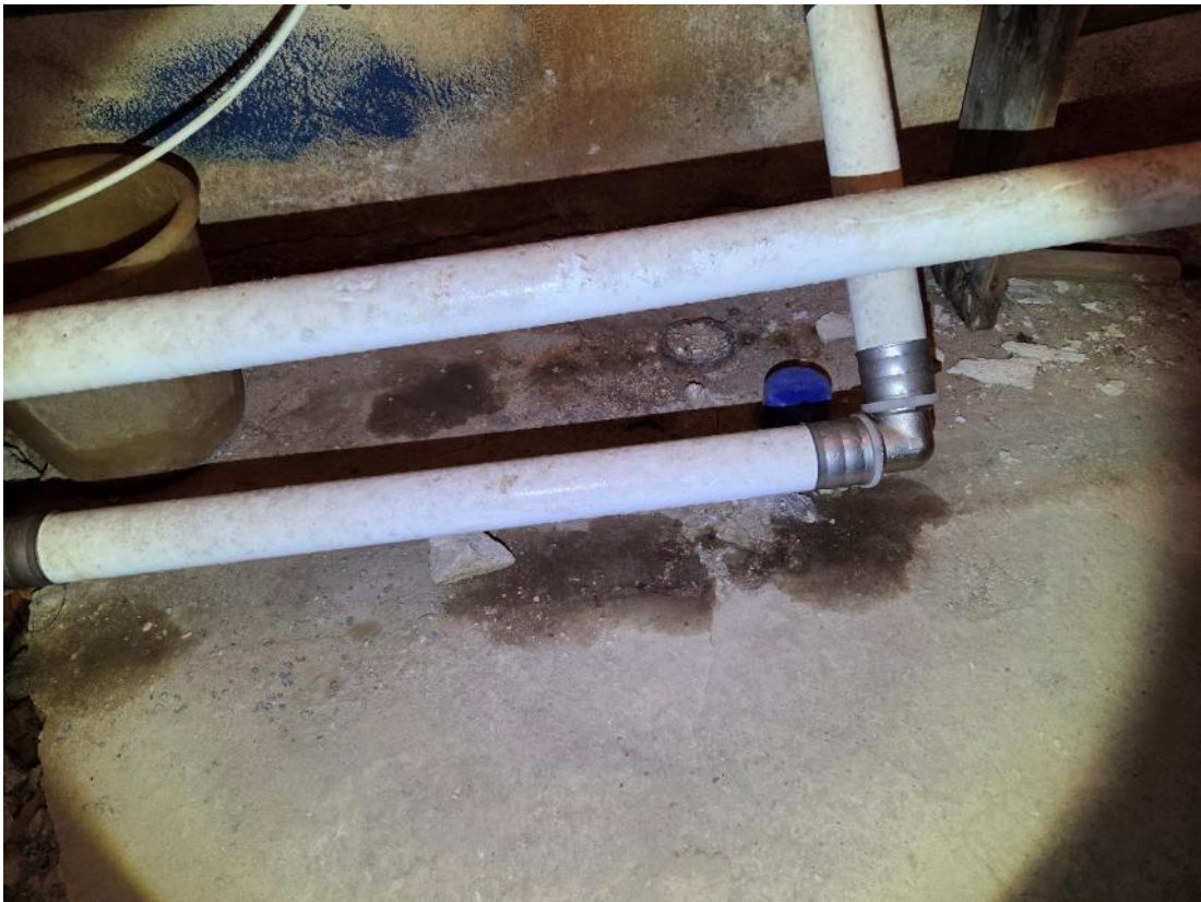
Foto 19. Torustik isoleerimata, näha on niiskeid kohti kondensaatveest.
