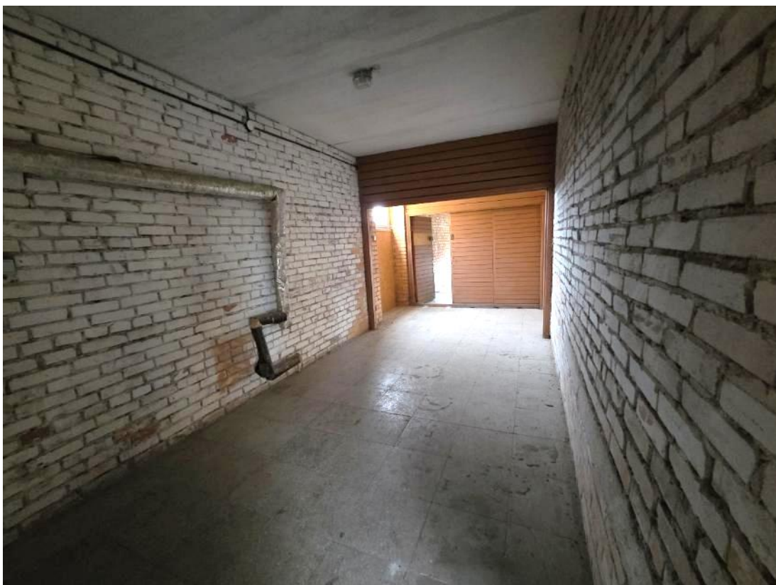
Foto 47. Seisukord on hea, niiskuskoldeid ei tuvastanud, vahelagi korrodeerumisjälgedeta.
