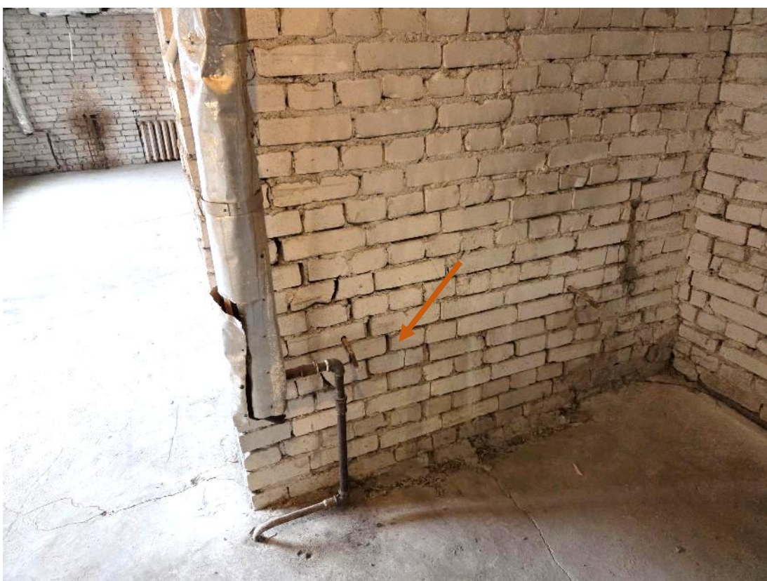
Foto 50. Lisada renoveerimise käigus parandussegu.
