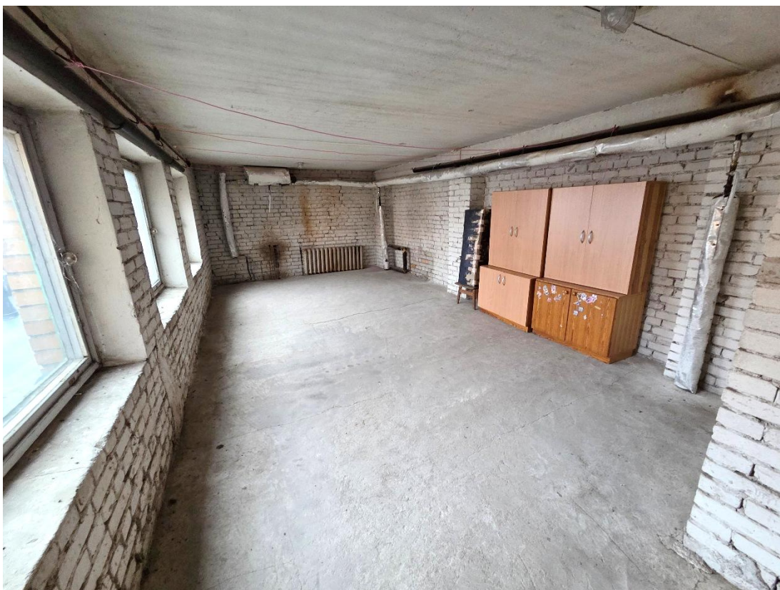
Foto 51. Seisukord on hea, niiskuskoldeid ei tuvastanud, vahelagi korrodeerumisjälgedeta.
