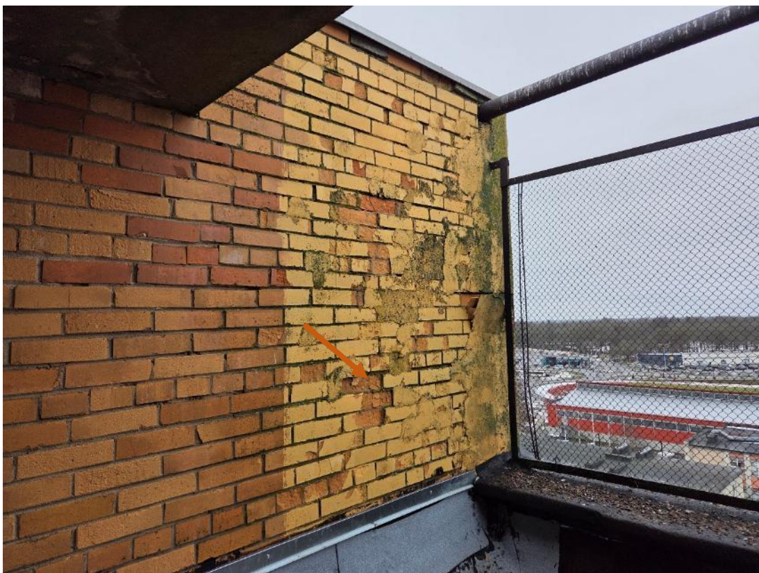
Foto 57. Ilmastik on tellist murendanud – lahtised osad eemaldada, üle krohvida.
