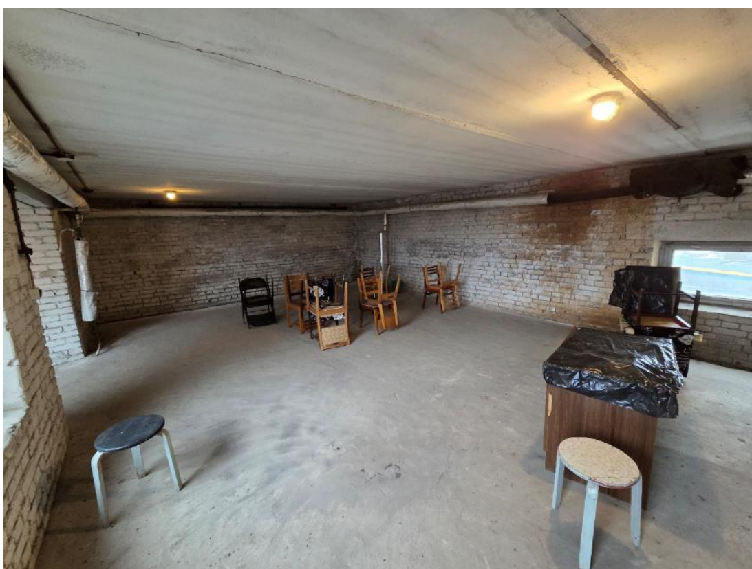
Foto 48. Seisukord on hea. niiskuskoldeid ei tuvastanud, vahelagi korrodeerumisjälgedeta.
