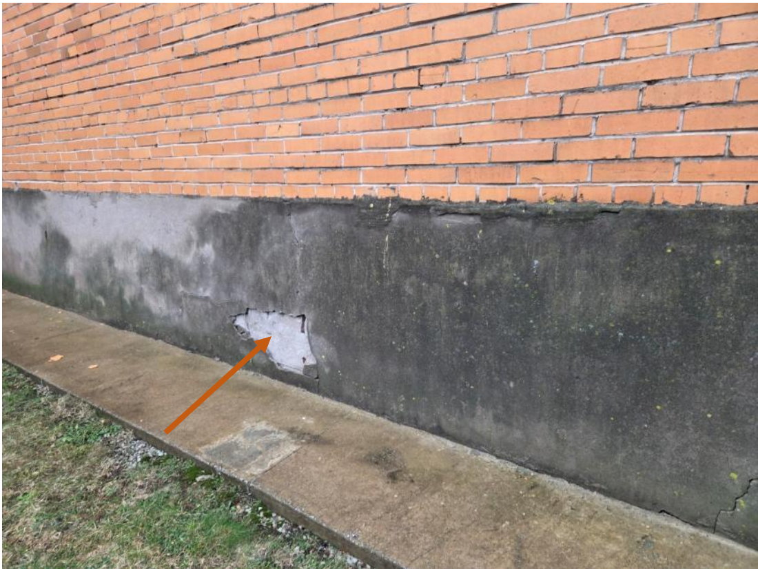
Foto 9. Soklilt on välisviimistlus ära kukkunud, eemaldada kogu soklilt lahtised osad, soojustada ning viimistleda.
