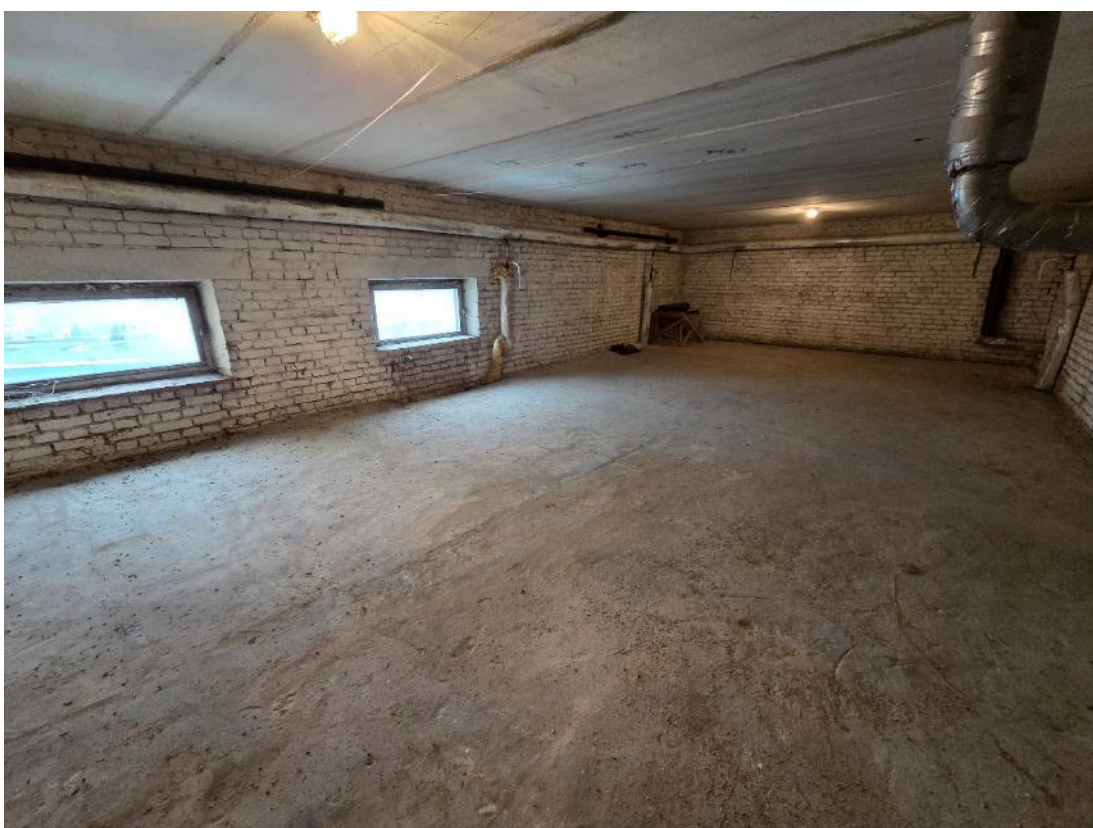
Foto 52. Seisukord on hea, niiskuskoldeid ei tuvastanud, vahelagi korrodeerumisjälgedeta.
