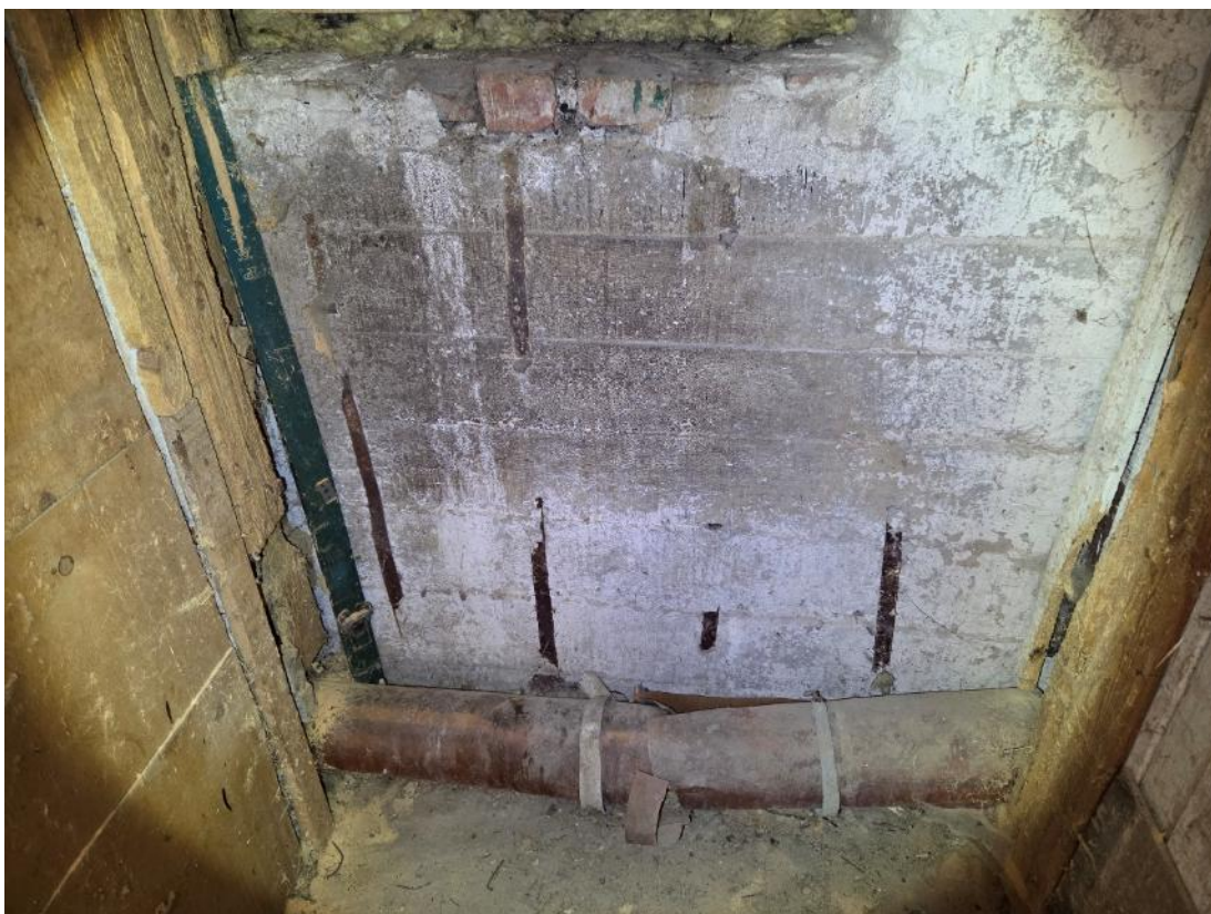
Foto 29. Raud paljandub, vaja puhastada, lisada kaitsekiht ja katta siseviimistluskihiga.
