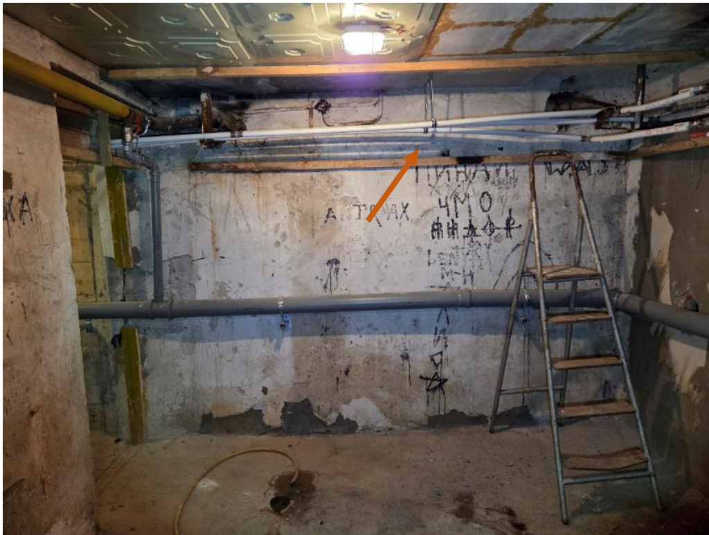
Foto 25. Torustiku kinnistusi napib, torustik isoleerimata.
