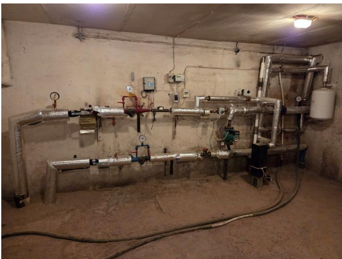
Foto 30 Soojussõlme on renoveeritud, torustik on isoleeritud.
