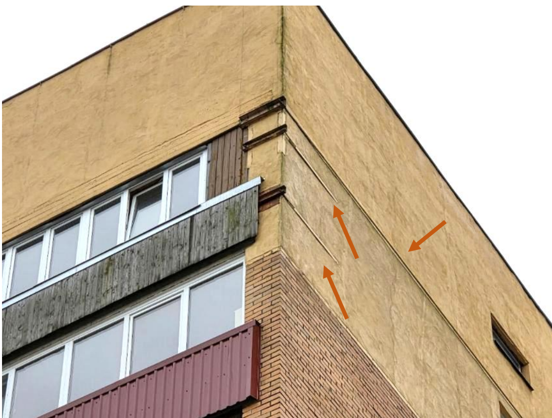
Foto 14. Ülemistele korrustele on paigaldatud tõmbid.
