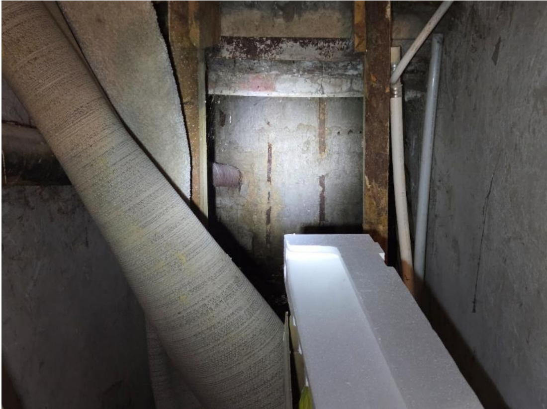
Foto 17. Vundamendi teraselemendid kaitsekihita, puhastada ning katta uue kaitsekihiga.
