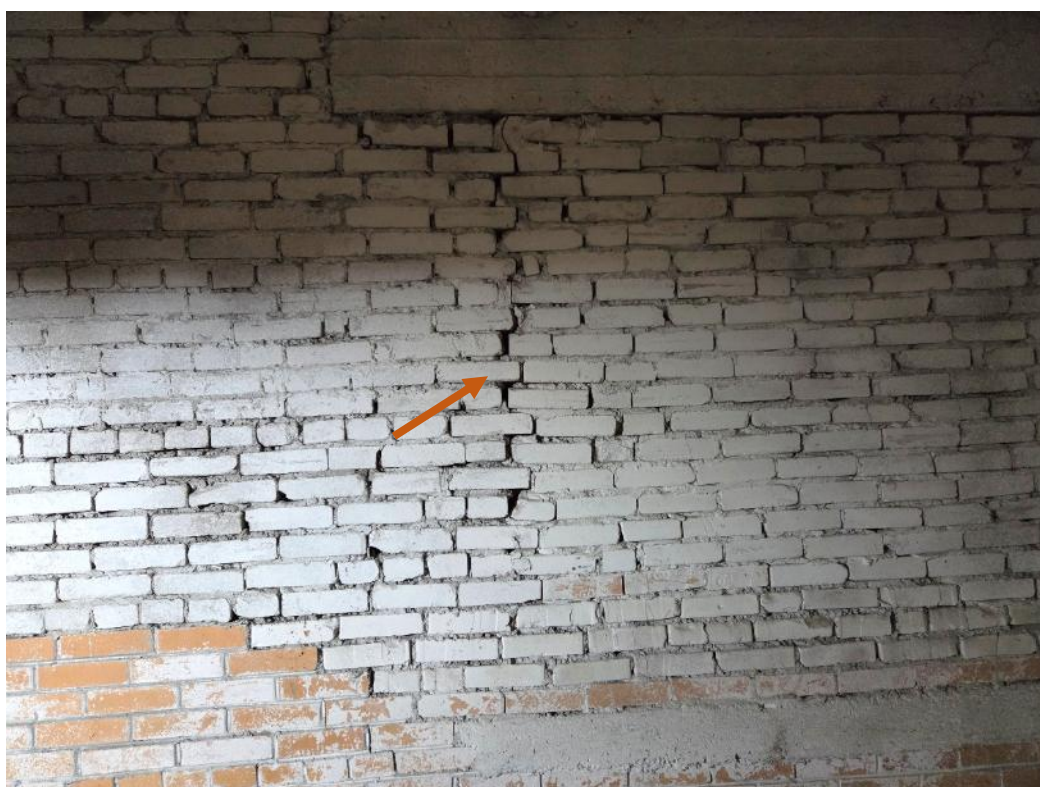
Foto 46. Pragu pööningul võtta kuni renoveerimiseni jälgimise alla – lisada parandussegu.
