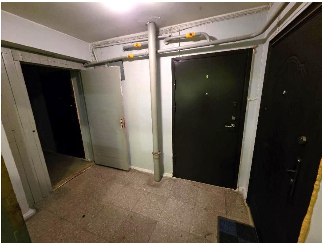
Foto 35. Korteritele paigaldada tuletõkkeuksed.
