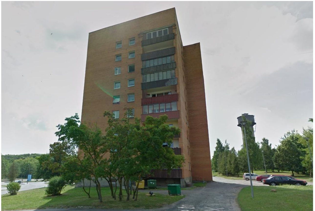
07.2011. Näha on, et mitmed lodžapiirded on veel välja vahetamata. Google Maps rakendus „Street View“.
