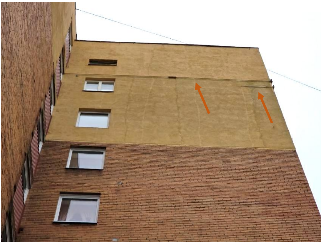
Foto 13. Ülemistele korrustele on paigaldatud tõmbid.
