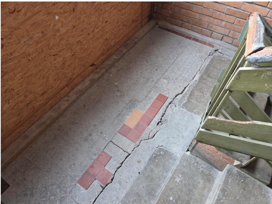
Foto 66. Trepikojas olev pragu võtta jälgimise alla, koostada trepikoja terviklik rekonstrueerimisprojekt.
