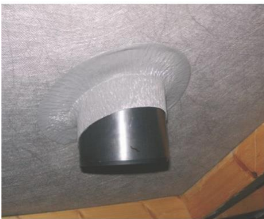
Joonis 5. Tuulutuskorstna tihendamine Easy Form tihendusteibiga, RUUKKI.
