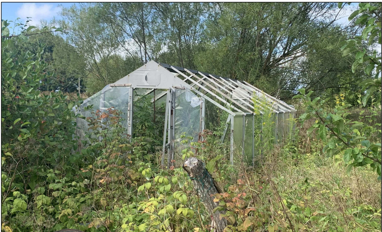
Raadiojaama tee 27 (kasvuhuone)
