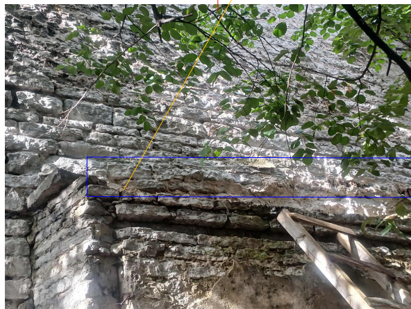
3 ülemist paekivi rida ca 0,5 m pikkust ala on juba ära lõhutud, lõhutud osas on tekkinud erinevaid auke kus vesi sisse pääseb
