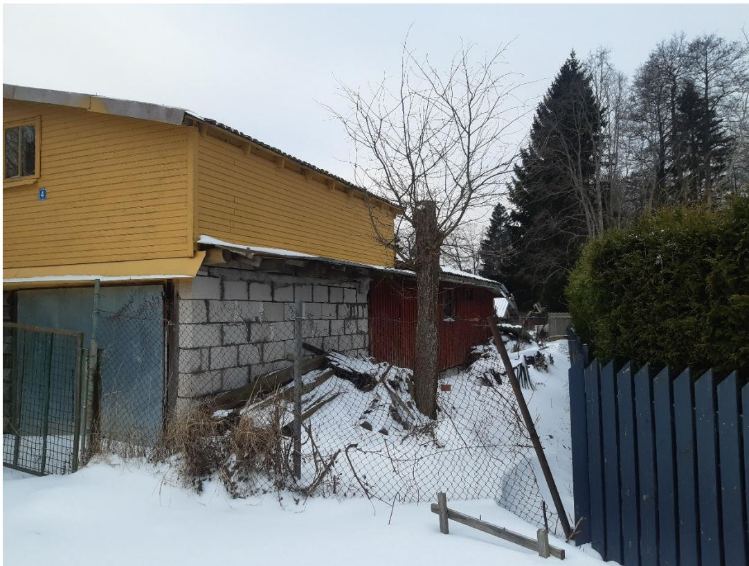
Foto 4: Vaade lammutatavale aiamajale põhjast.
