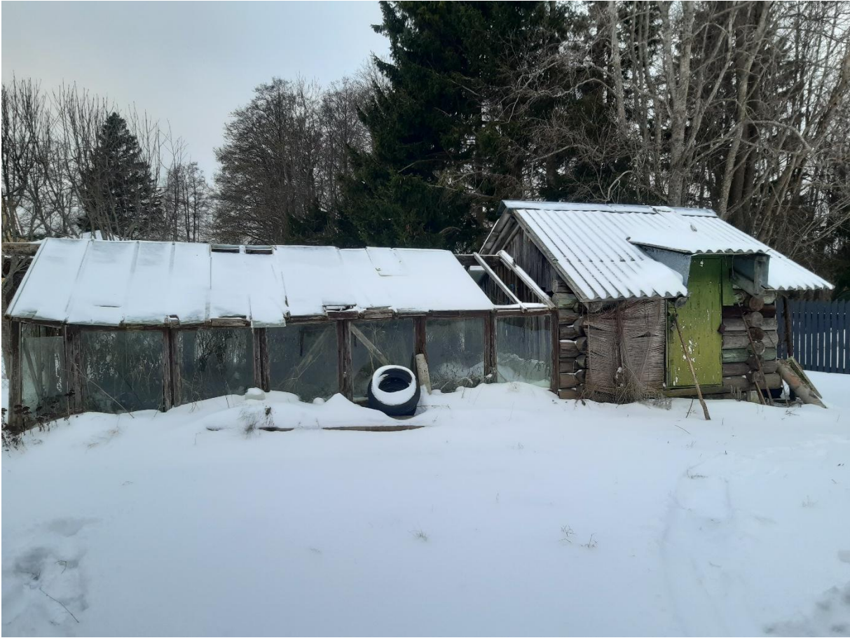
Foto 5: Vaade lammutatavale kasvuhoonele ja abihoonele.
