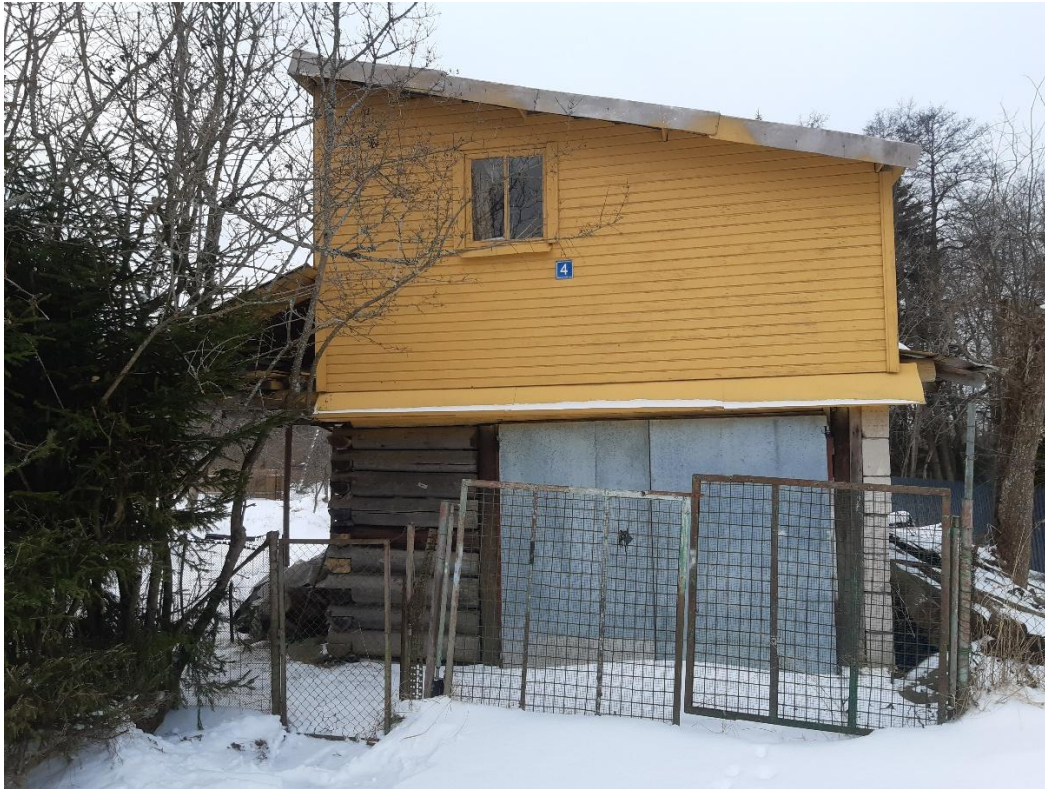
Foto 1: Vaade lammutatavale aiamajale idast.
