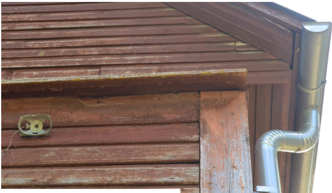
6. Viilu veelaua all on säilinud tõenäoliselt üks algne lai voodrilaud, samuti laudisega samas tasapinnas algupärane lai nurgalaud.
