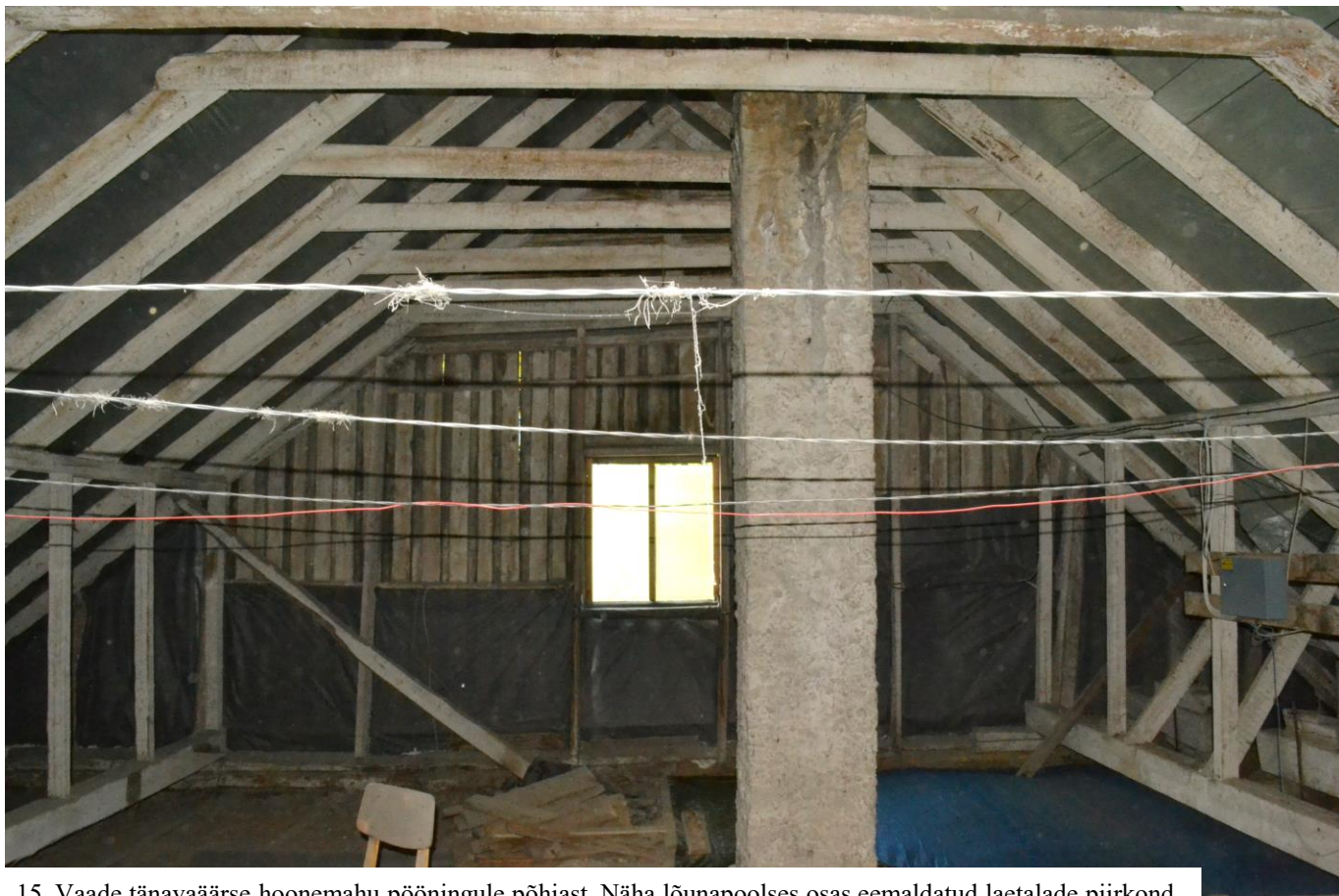
15. Vaade tänavaäärse hoonemahu pööningule põhjast. Näha lõunapoolses osas eemaldatud laetalade piirkond.
