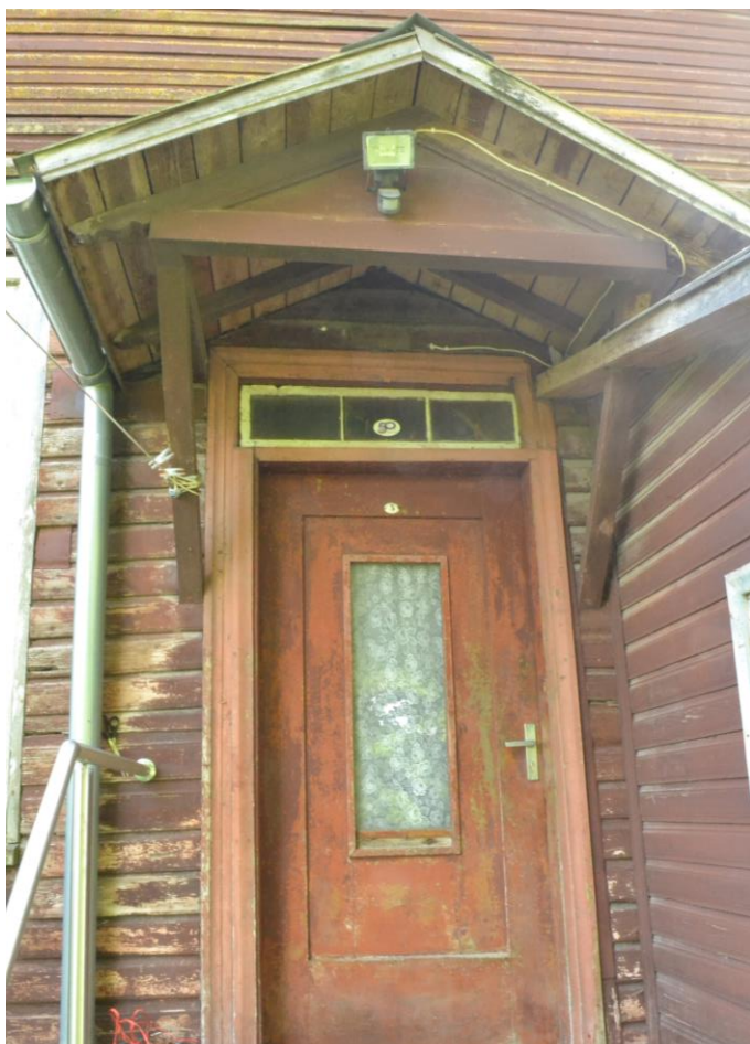
12. Hoovipoolse sissepääsu algupärased piirdelauad, valgmik ja varikatuse profileeritud otstega sarikad.
