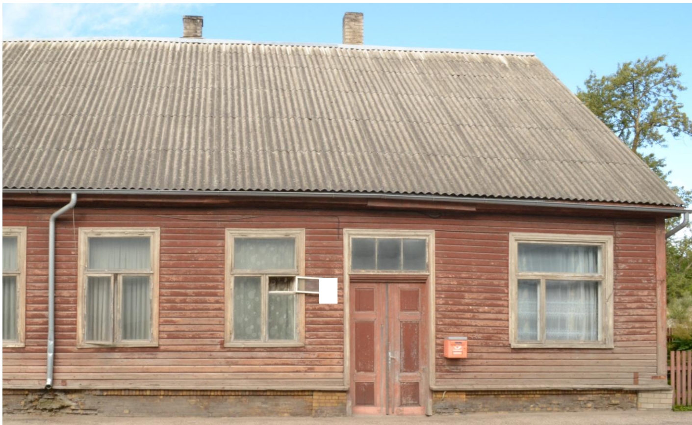
7. Tänavapoolne pikifassaad, mille sokkel on dekoratiivselt vooderdatud kollaste keraamiliste tellistega. Säilinud on algupärased ukse ja akende piirdeliistud, osad lengid, valgmikaken ja mõnest varasemast ümberehitusperioodist puidust kahepoolne tahveldatud peauks
