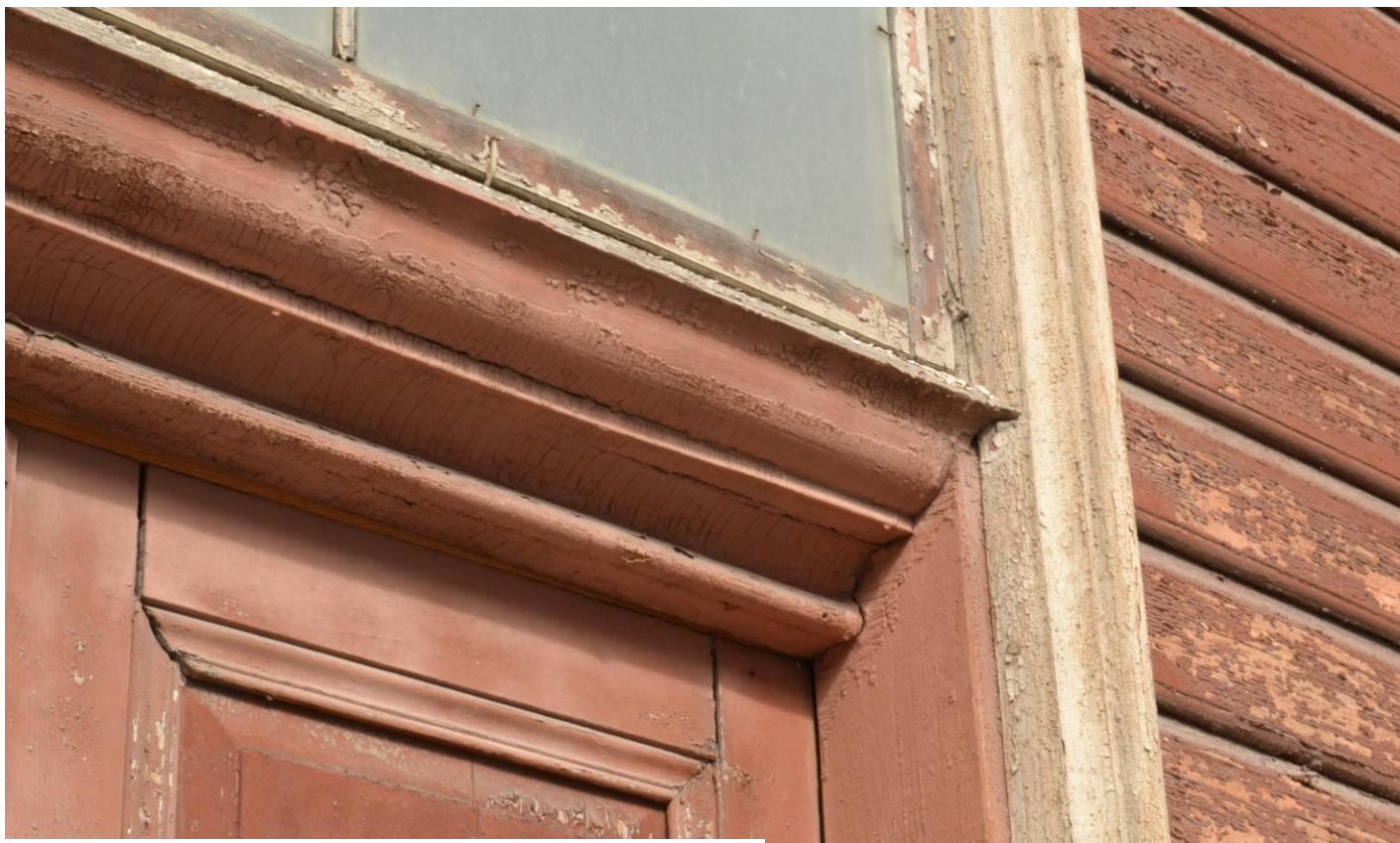
8. Peasissepääsu algupärane leng ja profileeritud horisontaalimpost.
