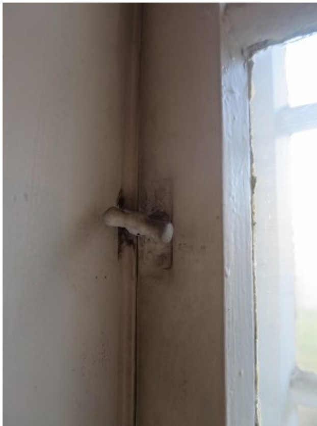
FOTOD 34, 35. Säilinud originaalaken ning -detailid, sulused ja hinged korteris 6/7.
