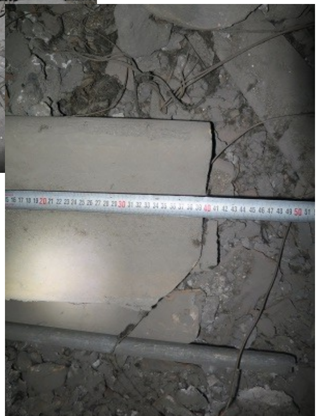
FOTOD 49, 50. Originaalkatusekatteks olnud põletatud savikivi. Võtta aluseks uue katusekatte valikul.
