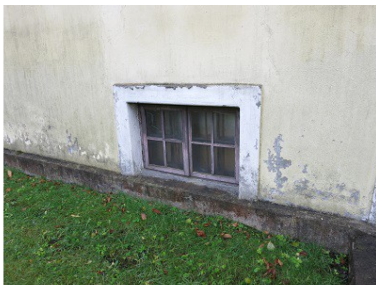
FOTO 20. Säilinud originaalaken keldrikorrusel.
