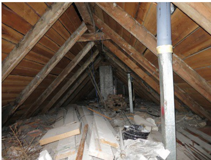
FOTO 06. Vaade hoone pööningule.
