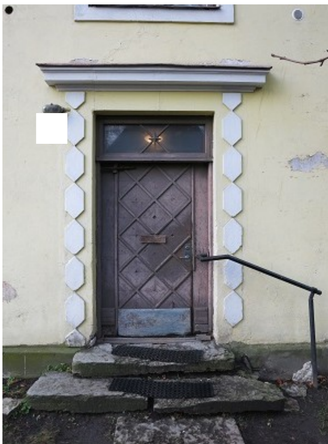
FOTO 17. Hoone peasissepääs ning seda ümbritsev krohv ornament. Paekiviplaatidest originaaltrepp.
