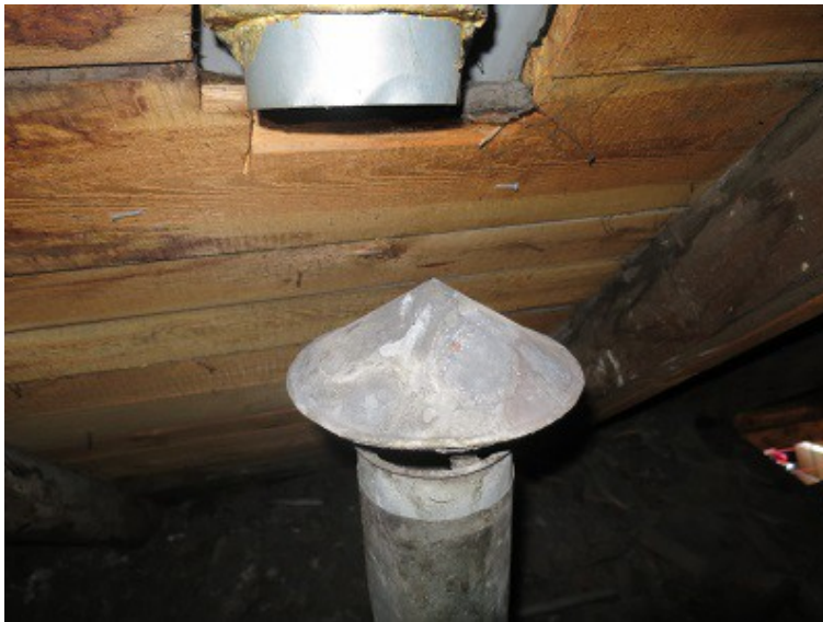
FOTO 48. Originaaldetail, kanalisatsiooni tuulutuse müts säilitada. Viia hoovi poolt läbi katuse väliskeskkonda.
