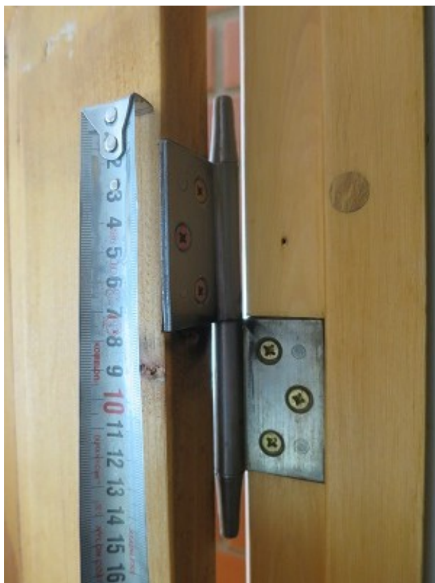
FOTOD 30, 31. Säilinud siseukse originaaldetailid korteris nr 1.
