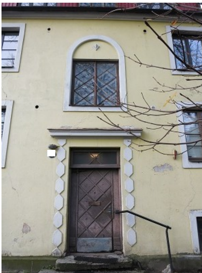
FOTO 18. Hoone peasissepääsu kohal paiknev originaalraamijaotusega aken ning seda ümbritsev krohviliist.
