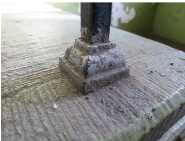
FOTOD 59, 60, 61. Trepikoja käsipuu ja kinnitused säilitada, originaaldetailid.
