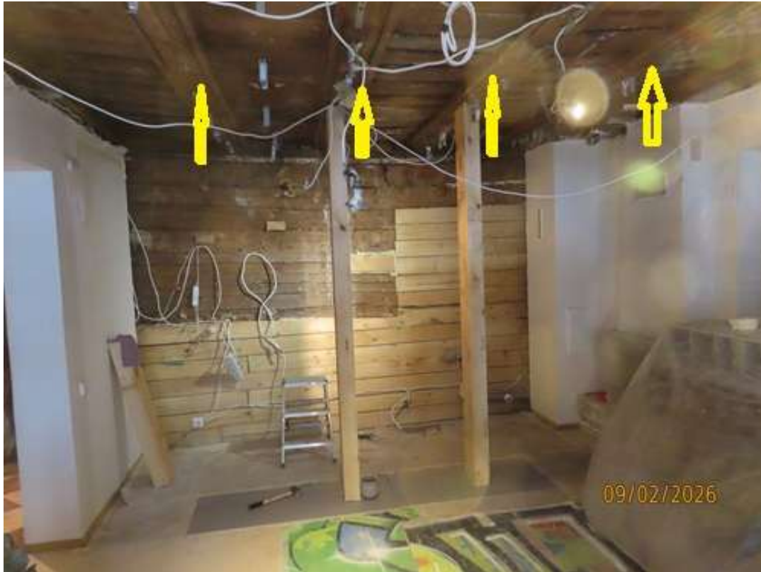
Foto 1. Näha on korterite 1 ja 2 vaheline palksein. Kollaste nooltega on vahelae talad, mis toetusid korterite vahelisele vaheseinale ja t'n poolsele vaheseinale. Punaste nooltega näidatud ajutised vahelaetalasid kandvad postid, mis suurusjärguliselt paiknevad lammutatud ehitusaegse vaheseina kohapeal.
