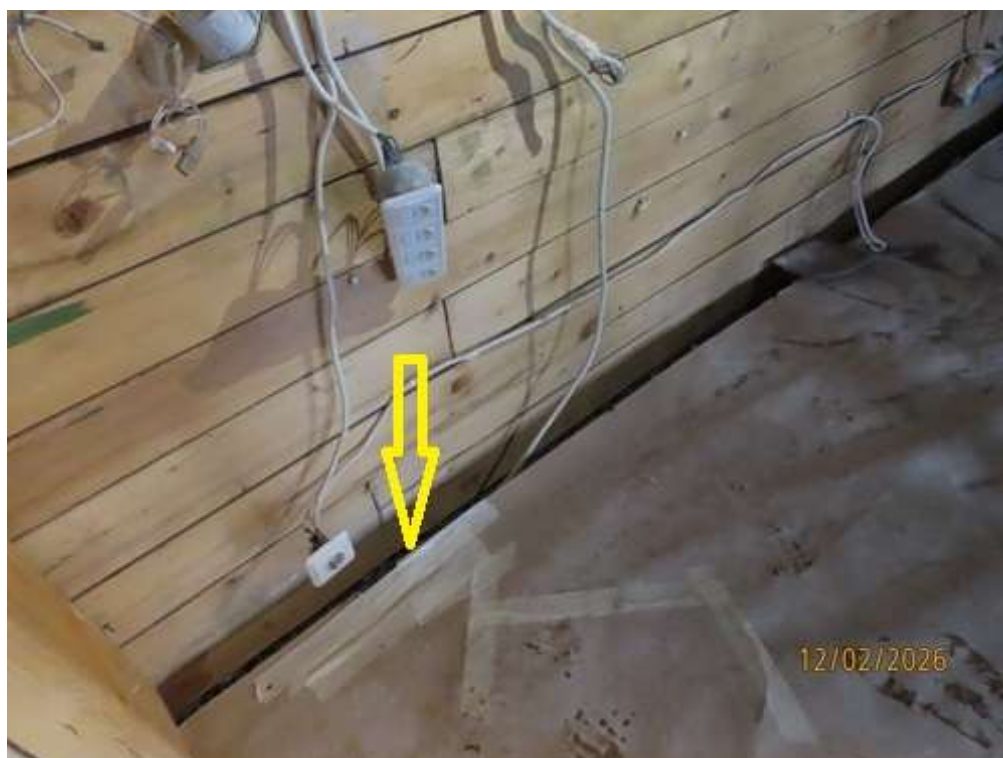
Foto 16. Noolega on näidatud korterite 1 ja 2 vahelise vaheseina ning põranda vahel olev vahe, kust oli võimalik pildistada ja katsuda korterite vahelise vaheseina alumist palki, mis oli pruun ja pehme.
