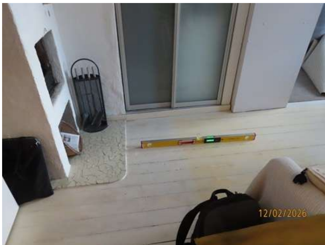
Foto 6. Kamina ees oli kalle piki vahelaetalasid 6 mm/m ja kalle suurenes ruumi keskel kuni 13 mm/m.
