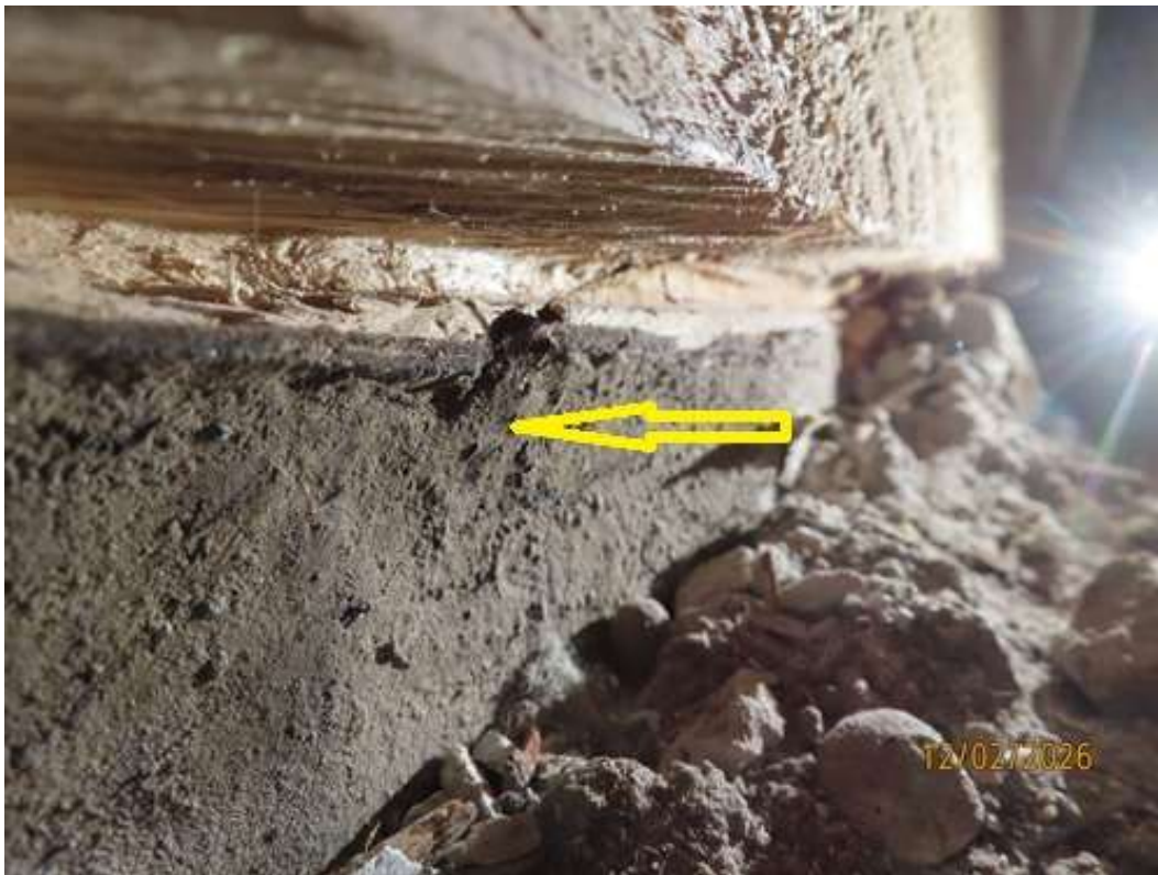
Foto 17. Noolega on näidatud korterite vahelise vaheseina alumine palk, mis oli pruun ja pehme.
