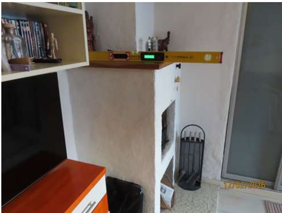
Foto 4. Kamina kalle piki vahelaetalasid oli 1 mm/m.
