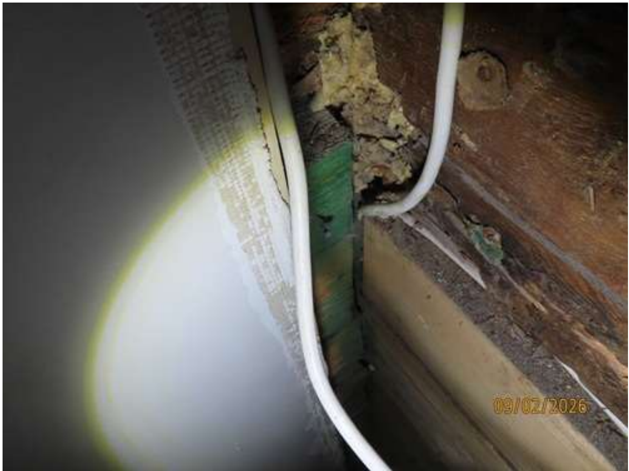
Foto 20. Korterite vaheseina ja korterite vahelise vaheseina palgiud olid sidumata.
