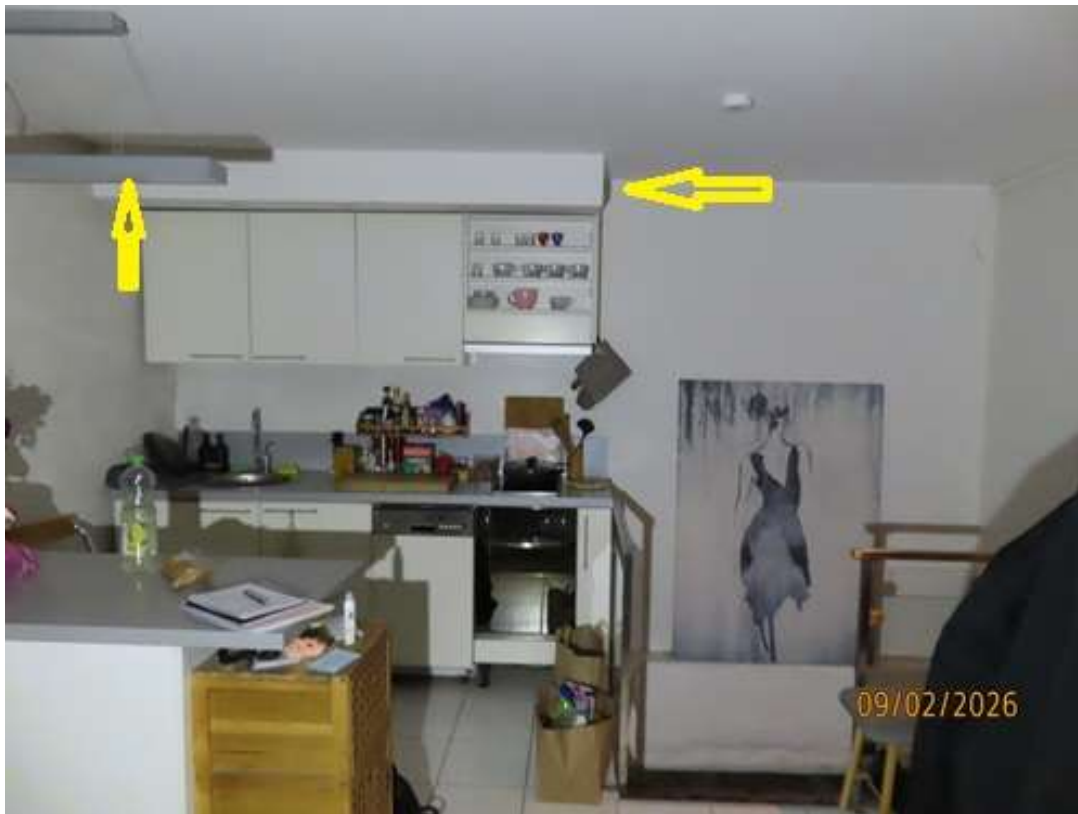
Foto 22. Otsevaates on näha korteri 1 ja 2 vaheline vahesein, mille kipsplaadist karniis on vajunud ja pragunenud.
