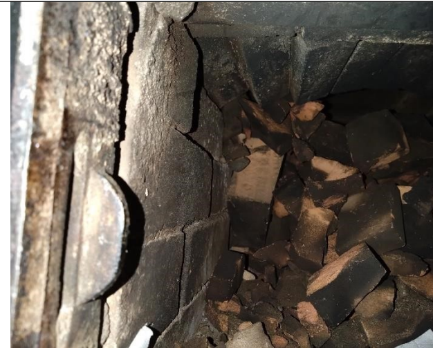
Foto 8: Nihkunud kolde sein, varisenud võlv ja lõõrid
