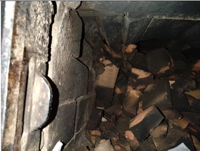
Foto 11: varisenud koldelagi ja lõõrid
