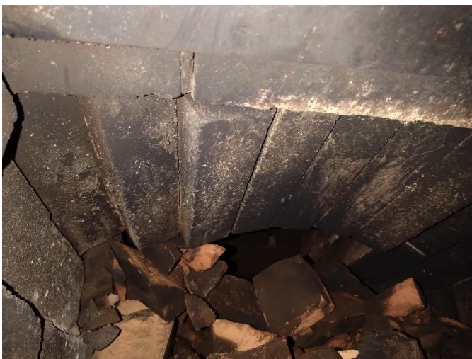
Foto 13: varisenud ja osaliselt alla vajunud koldelagi
