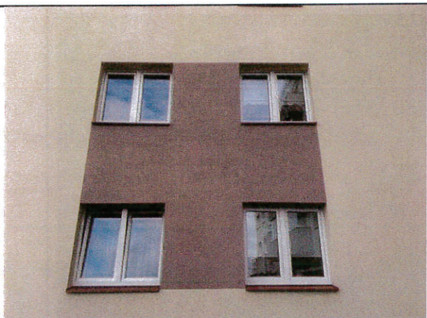
Hoone ühel kagu poolisel otsaseinal mõranenud akende vaheline piirkond
