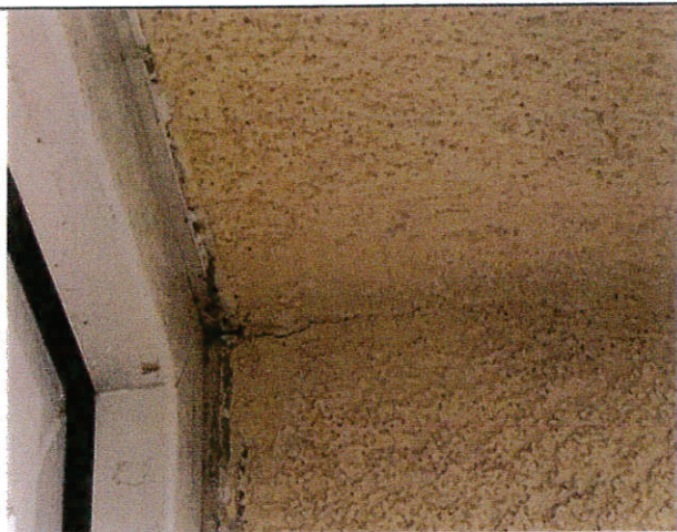
Mõrasid leidub nii avade sisenurkades kui fassaadipinnal avanurkades
