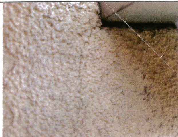
Mõrasid leidub nii avade sisenurkades kui fassaadipinnal avanurkades
