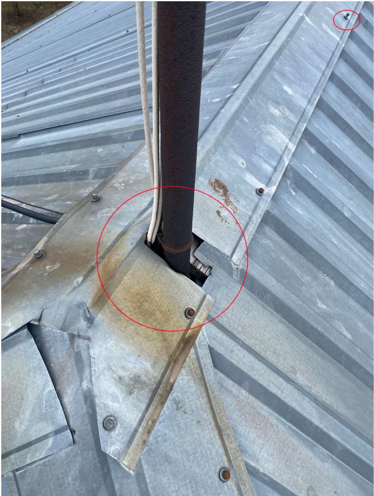
Foto nr 6 – Antennimasti läbiviik katuselt
