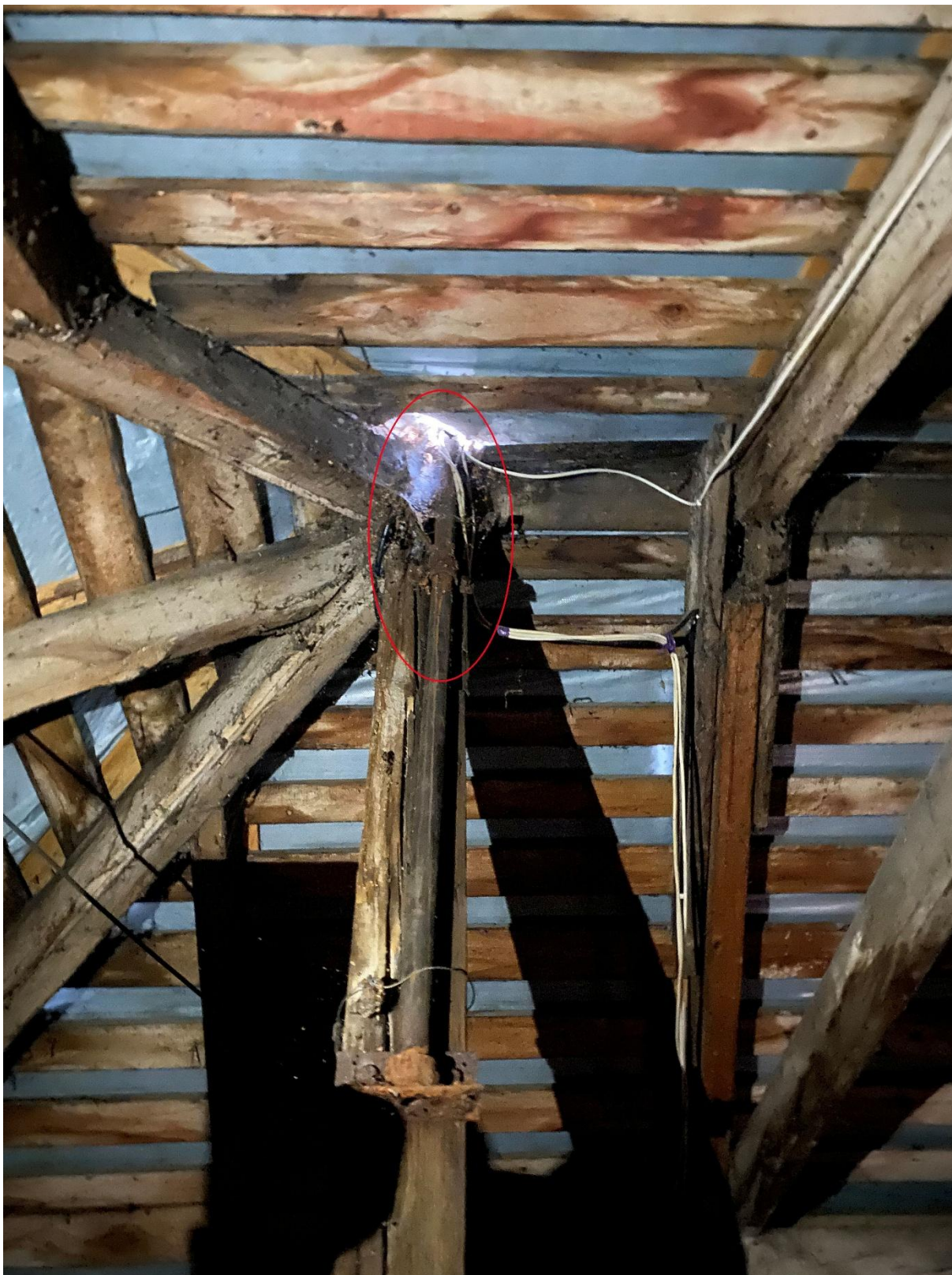
Foto nr 5 – Antennimasti läbiviik pööningult
