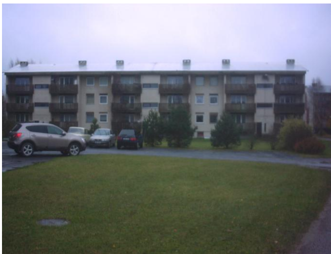
Foto 2. Elamu fassaad põhjast
