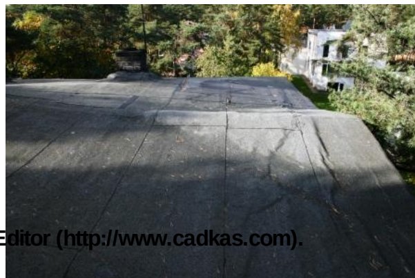
Vaade trepikoja kohal olevale abikatusele, mis ehitatakse ümber
