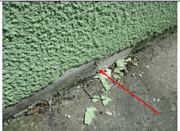
Fotod nr. 5-6. Paneeli ja fassaadi soojustuse liitekohad on hermetiseerimata, võimaldades veel tungida konstruktsioonidesse ja soojustusse. See on juhtunud korteris nr. 40 (vt. foto 13).
