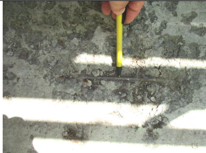
Fotod nr. 15-16. Näited avatud betooniarmatuurist. Ajaga see korrodeerub ning hakkab nõrgestama betooni ja selle kandevõimet.
