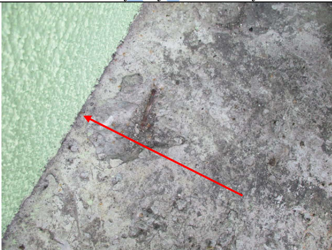
Fotod nr. 5-6. Paneeli ja fassaadi soojustuse liitekohad on hermetiseerimata, võimaldades veel tungida konstruktsioonidesse ja soojustusse. See on juhtunud korteris nr. 40 (vt. foto 13).
