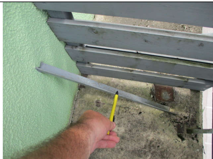
Fotod nr. 9-8. Rõdupaneeli tugevdamiseks (ja võimaliku varingu vältimiseks) on sellele remondi käigus paigaldatud vinkelrauast lisatoed e tõmmitsad.
