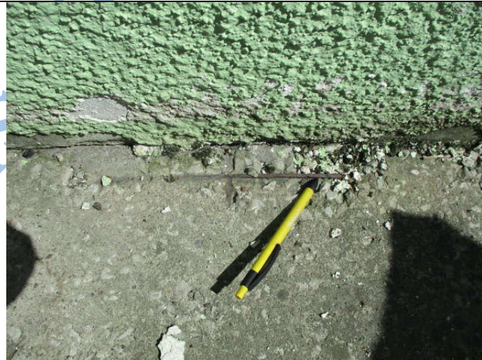
Fotod nr. 15-16. Näited avatud betooniarmatuurist. Ajaga see korrodeerub ning hakkab nõrgestama betooni ja selle kandevõimet.
