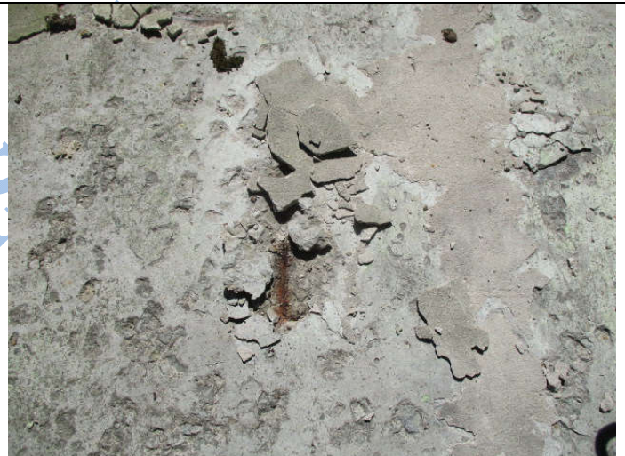
Fotod nr. 5-6. Paneeli ja fassaadi soojustuse liitekohad on hermetiseerimata, võimaldades veel tungida konstruktsioonidesse ja soojustusse. See on juhtunud korteris nr. 40 (vt. foto 13).
