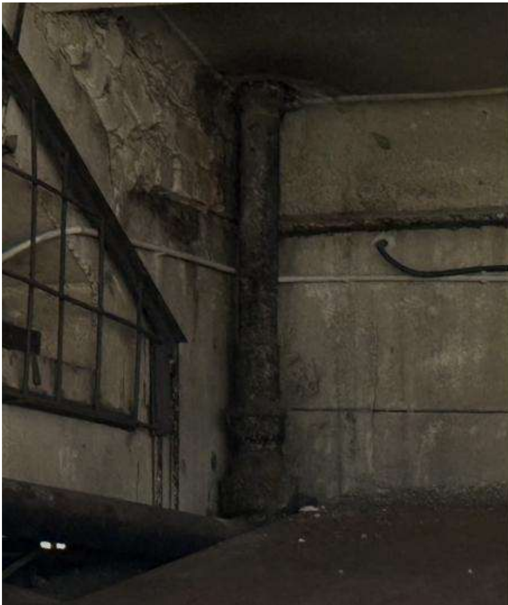
Foto nr 7: Fotol on kujutatud sadeveekaevust 2 alguse saav hoonesisene sadeveekanaliseerimise torustik, mis kuulub rekonstrueerimisele.
