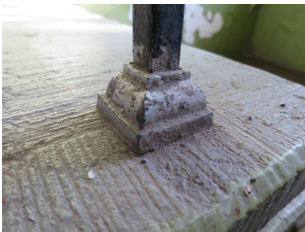
FOTOD 59, 60, 61. Trepikoja käsipuu ja kinnitused säilitada, originaaldetailid.
