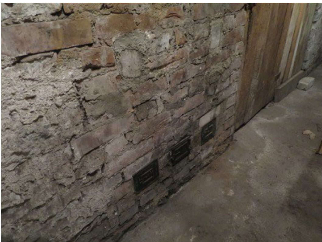
FOTO 25. Säilinud originaaldetailid keldrikorruusel. Puhastusluugid.
