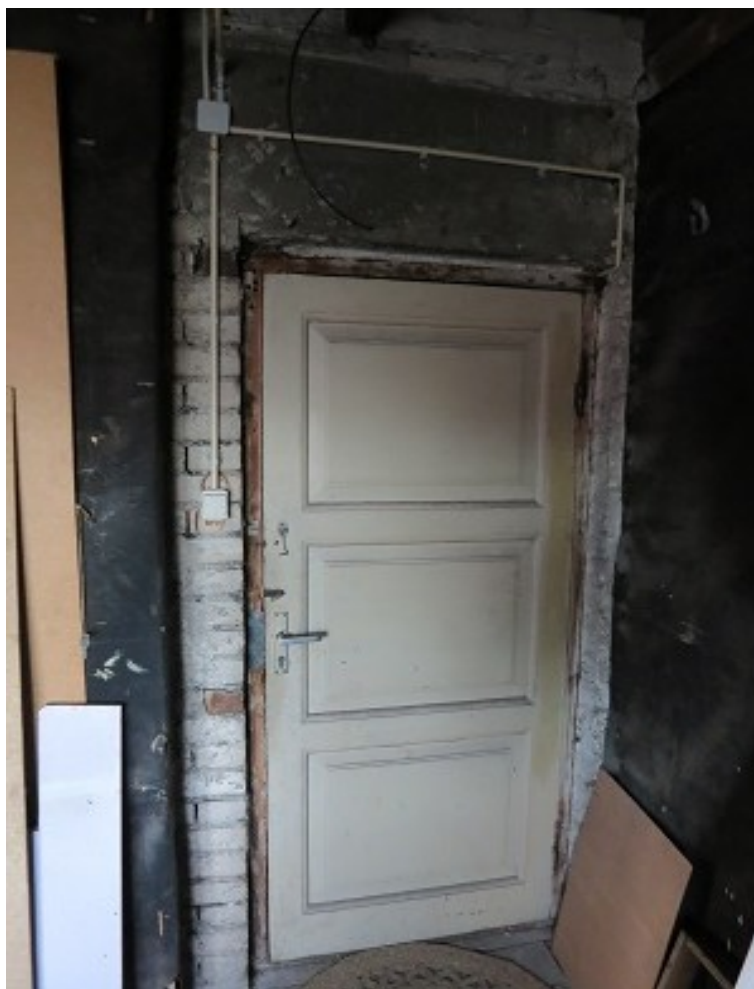
FOTO 46. Säilinud originaaluks kolmanda korruse väljaehitamata korterisse pääsuks.
