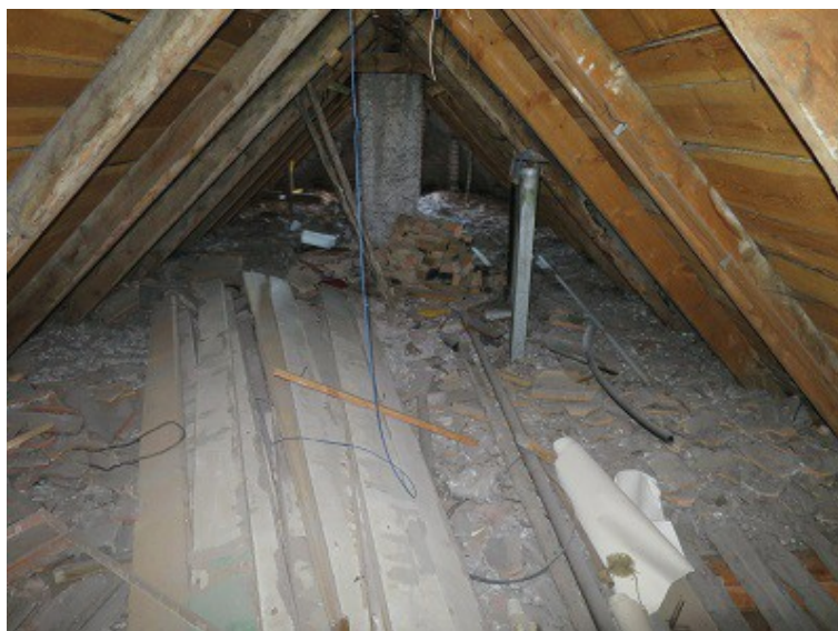
FOTO 47. Originaaldetail, kanalisatsiooni tuulutuse müts säilitada. Viia hoovi poolt läbi katuse väliskeskkonda.
