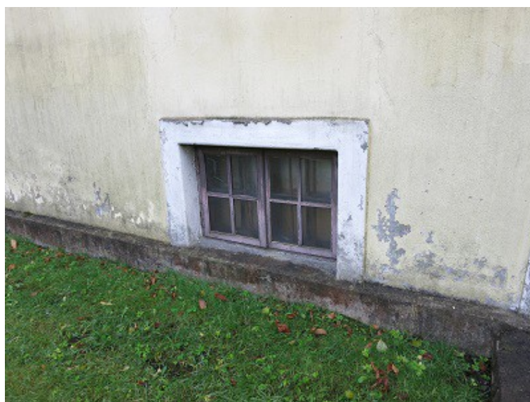
FOTO 20. Säilinud originaalaken keldrikorrusel.
