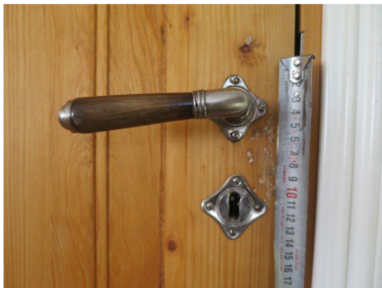
FOTO 29. Säilinud siseukse originaaldetailid korteris nr 1.
