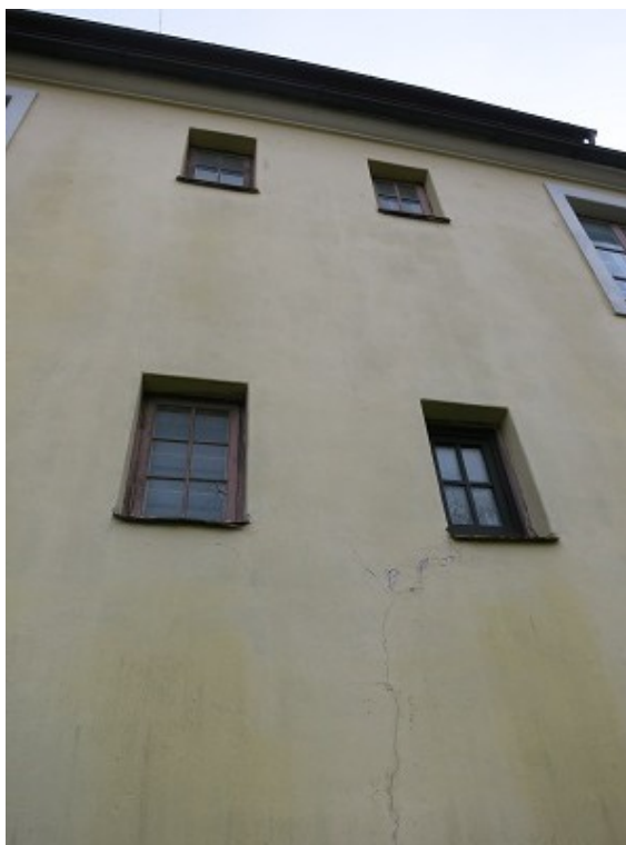
FOTO 23. Säilinud väikesed originaalaknad (alumise rea parempoolne on vahetatud originaaljaotust mittejärgiva akna vastu).
