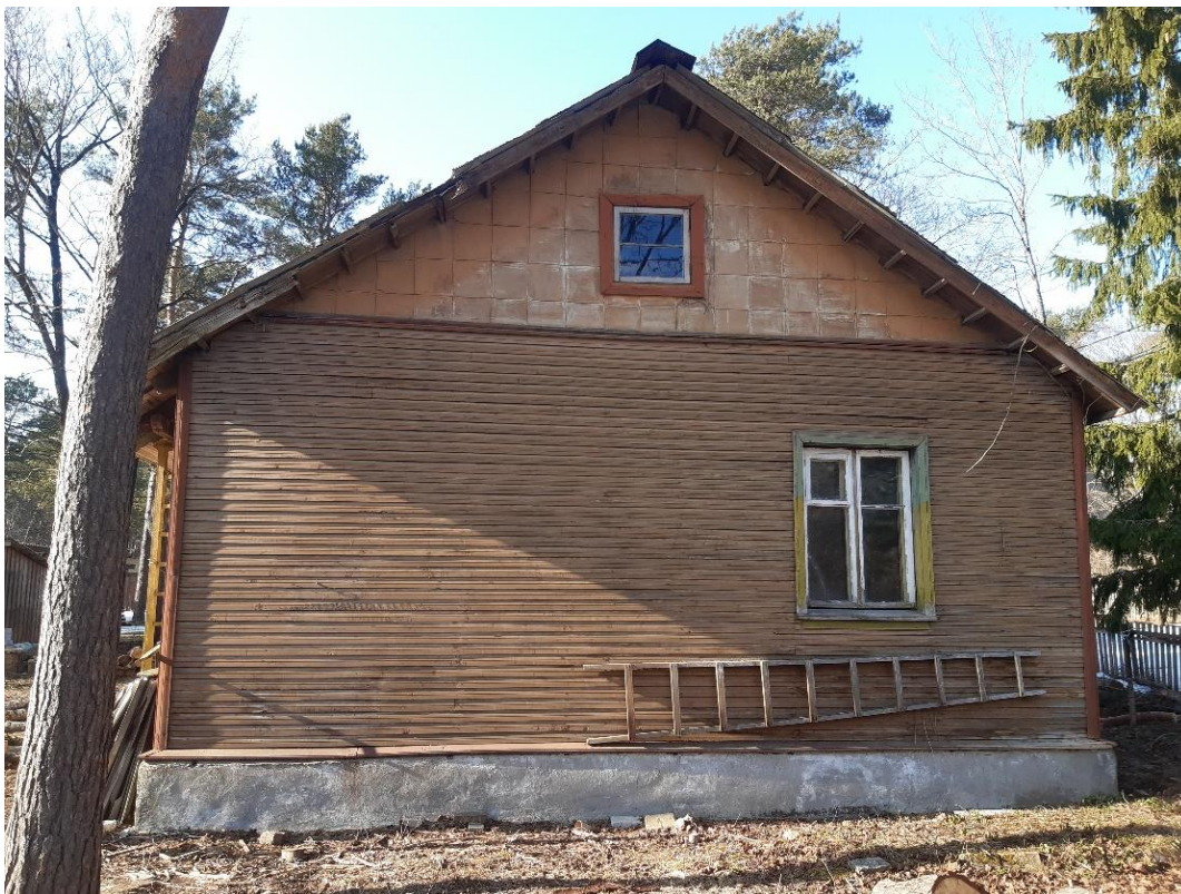
Foto 2: Vaade lammutatavale elamule kagust.
