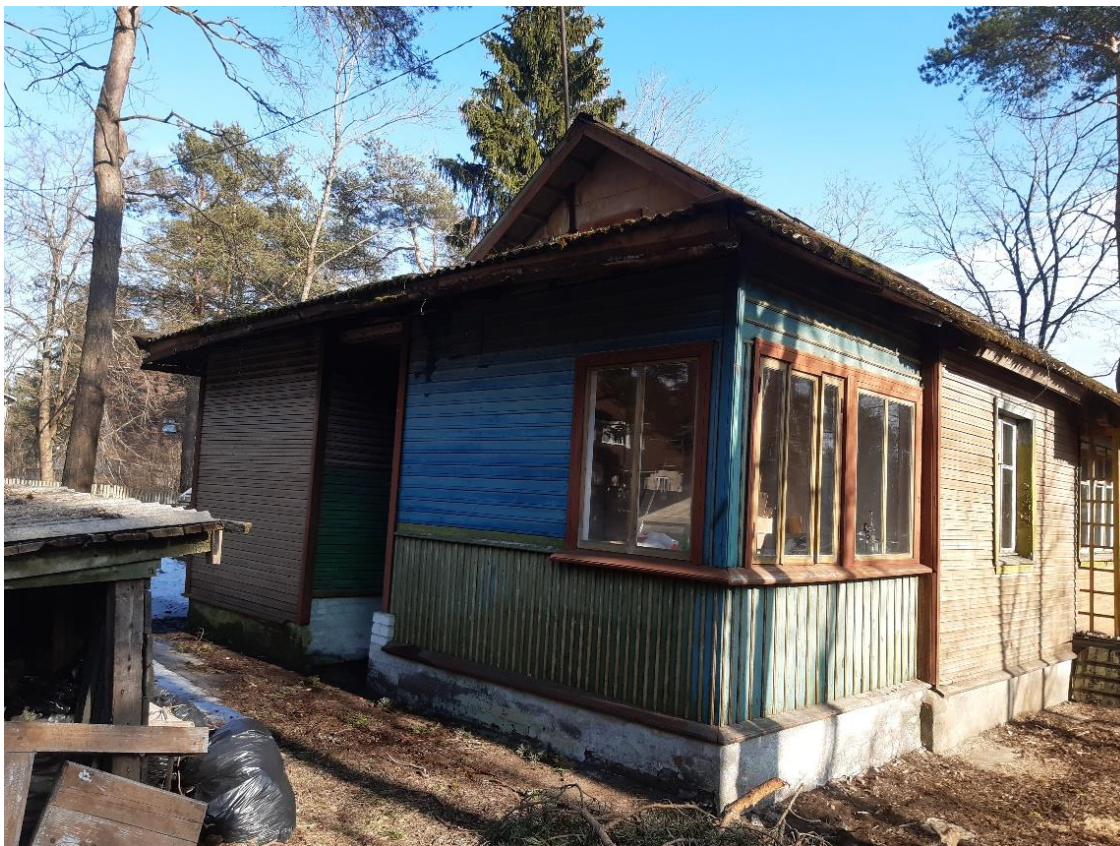
Foto 3: Vaade lammutatavale elamule loodest.
