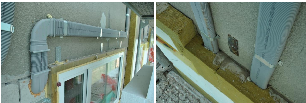
Foto 4. Fassaadialune ventilatsioonisüsteem
