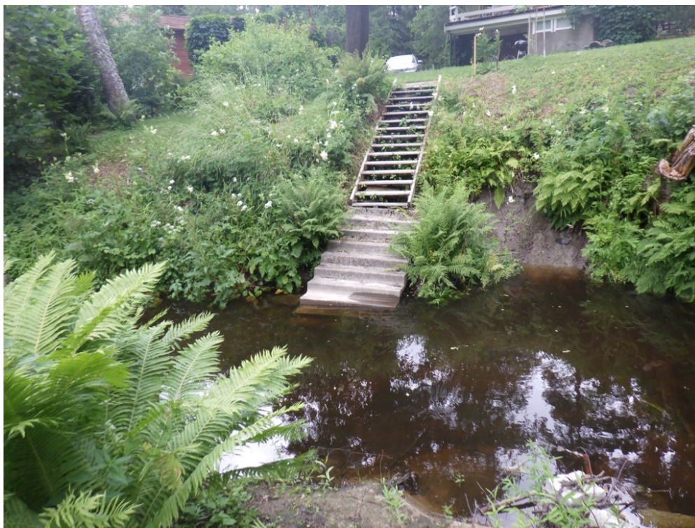
Foto 5. Vastaskaldal (kinnistul) olev trepp
