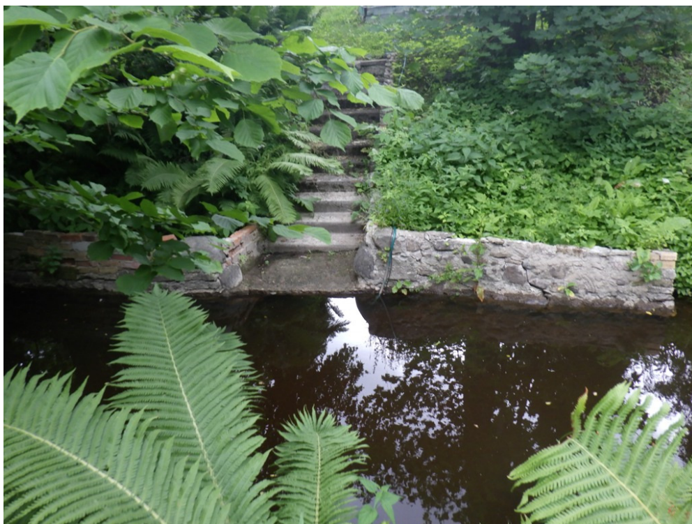
Foto 6. Vastaskaldal (kinnistul) olev trepp
