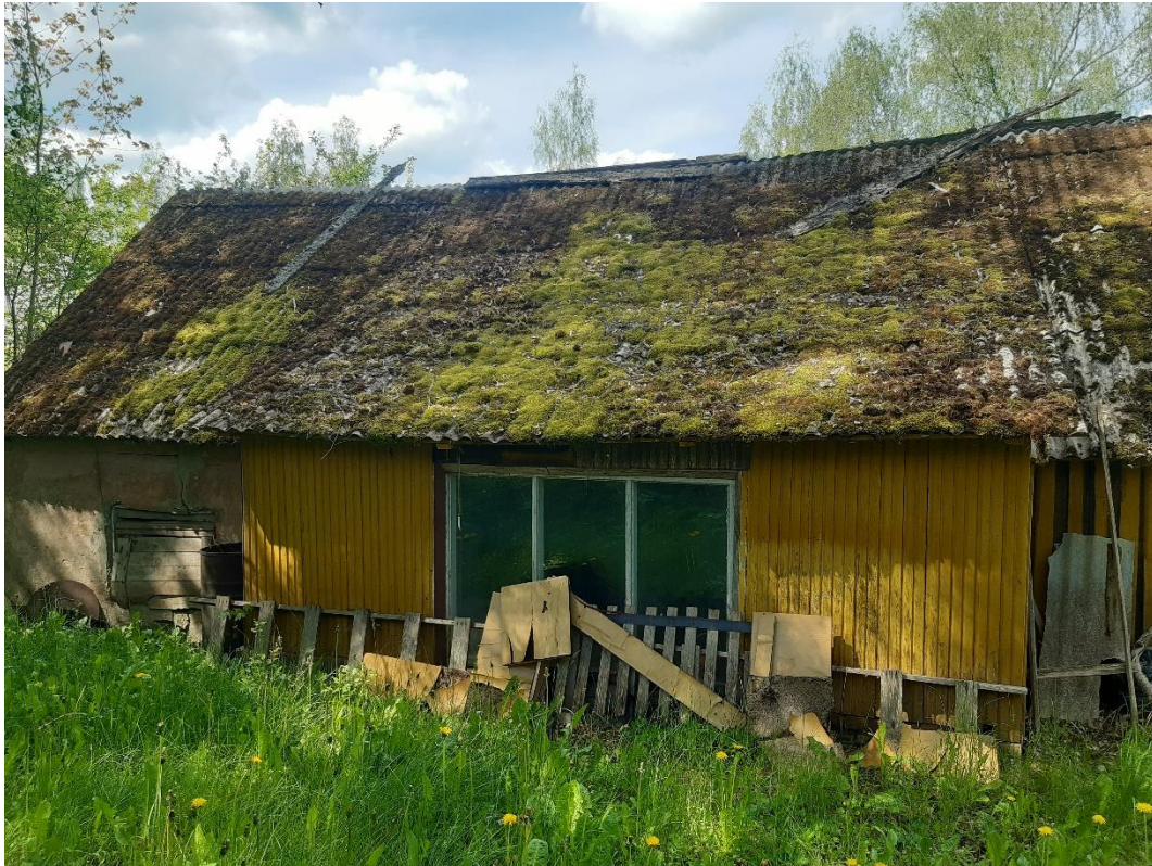
Foto 6: Vaade lammutatavale kuur 2-le idast.
