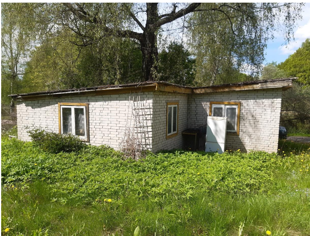
Foto 3: Vaade lammutatavale kuur 1-le kirdest.
