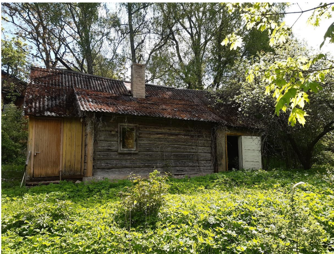
Foto 5: Vaade lammutatavale kuur 2-le läänest.
