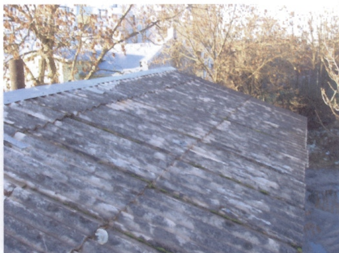
Foto 20 Katussekatteks olev eterniitplaat on täielikult amortiseerunud.
