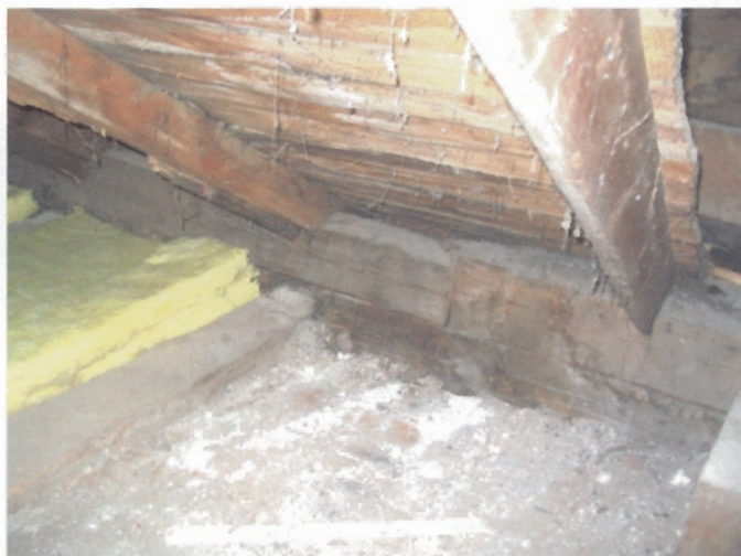
Foto 25 Nivendikonstruktsiooni lähivaade.
