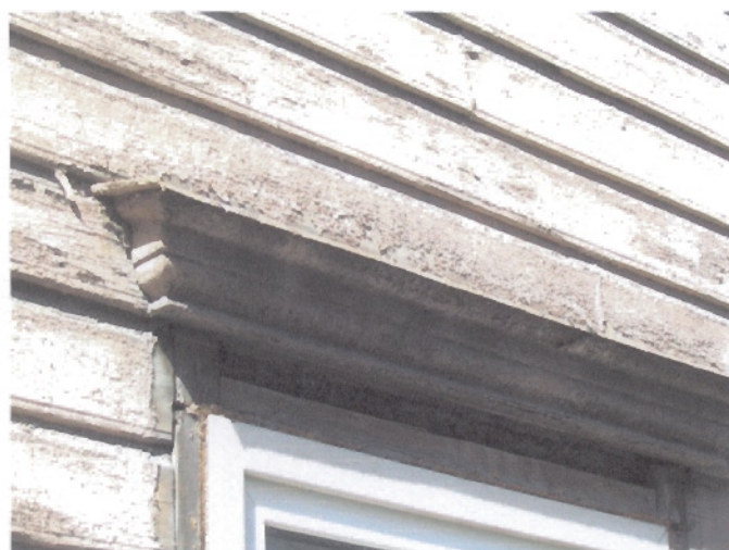
Foto 11 I korruse aknapealse karniisi vaade
