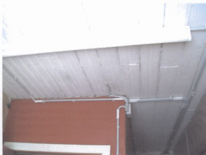
Foto 28 II korruse trpikoja lae vaade. Säilinud on algne profileeritud laudadest laelaudis.
