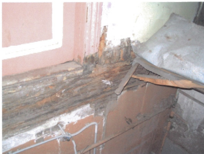
Foto 32 Sama. Vaade II korruselt.
