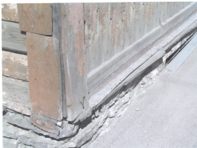
Foto 16 Sama lähivaade. Paekivil on suured külmakahjustused.
