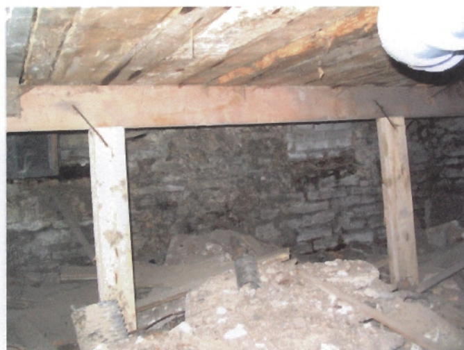
Foto 36 Keldri üldvaade. Kaaslaudisel ja vahelae taladel on liigniiskusest tekkinud puiduseene Coniophora Puteana (majamädik) kahjustused.
