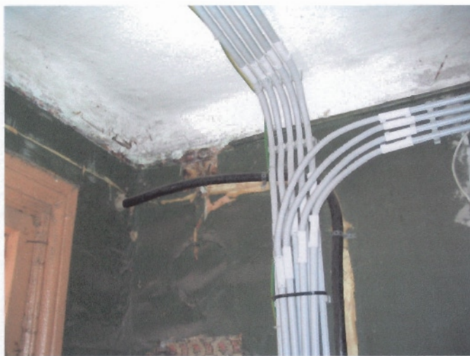
Foto 28 I korruse trepikoja lae vaade. Säilinud on algne lubikrohv ja väike peegelvõlv.
