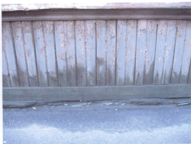
Foto 14 Sokli lähivaade Luise tänavalt. Veelaud, alumised palgikorrad ja kattelaudis on tugevalt seenkahjustatud.
