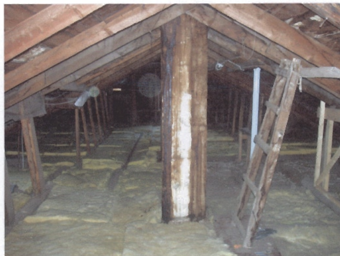
Foto 22 Pööningu üldvaade. Korstnajakalad on tugevalt pigitunud ja tuleohtlikud.
