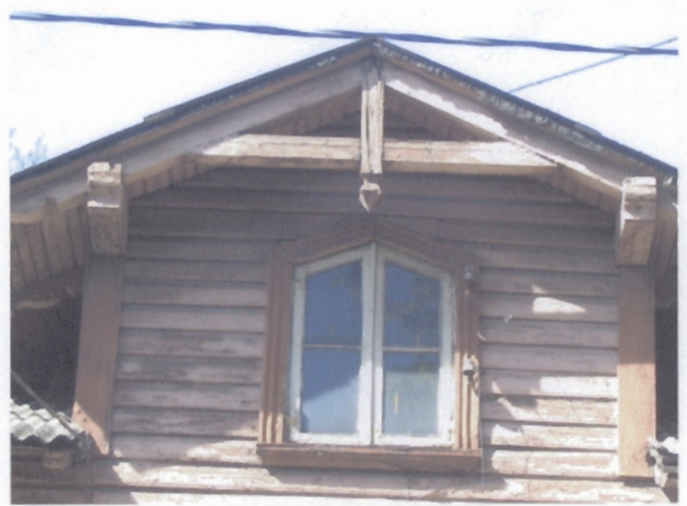
Foto 4 Sama. Viiluseina rikkaliku saelõike ornamentikaga konstruktsiooni vaade.
