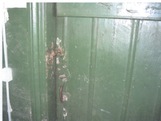
Foto 35 Algne pööningu uks. Pöönadega uksele on säilinud klapplukk.
