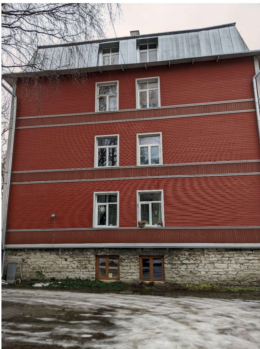
Foto 2 Olemasolev olukord. Vaade loode fassaadile
