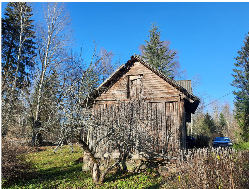
Foto 2: Vaade olemasolevale olukorrale lõunast
