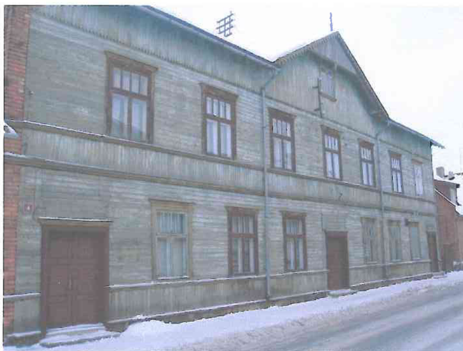
1. Vaade hoone fassaadile edelast
