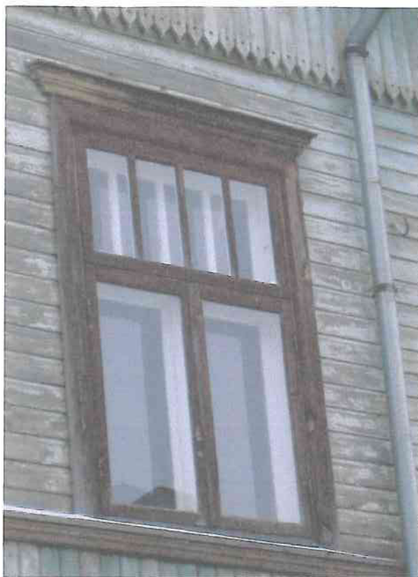
7. Aken tänava fassaadil teisel korrusel
