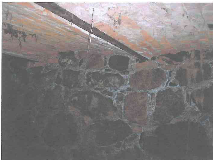
17. Keldri terastaladel punastest tellistest võlvlagi
