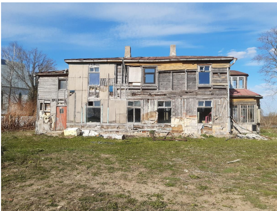
Foto 3: Vaade lammutatavale apteek-elamule edelast.
