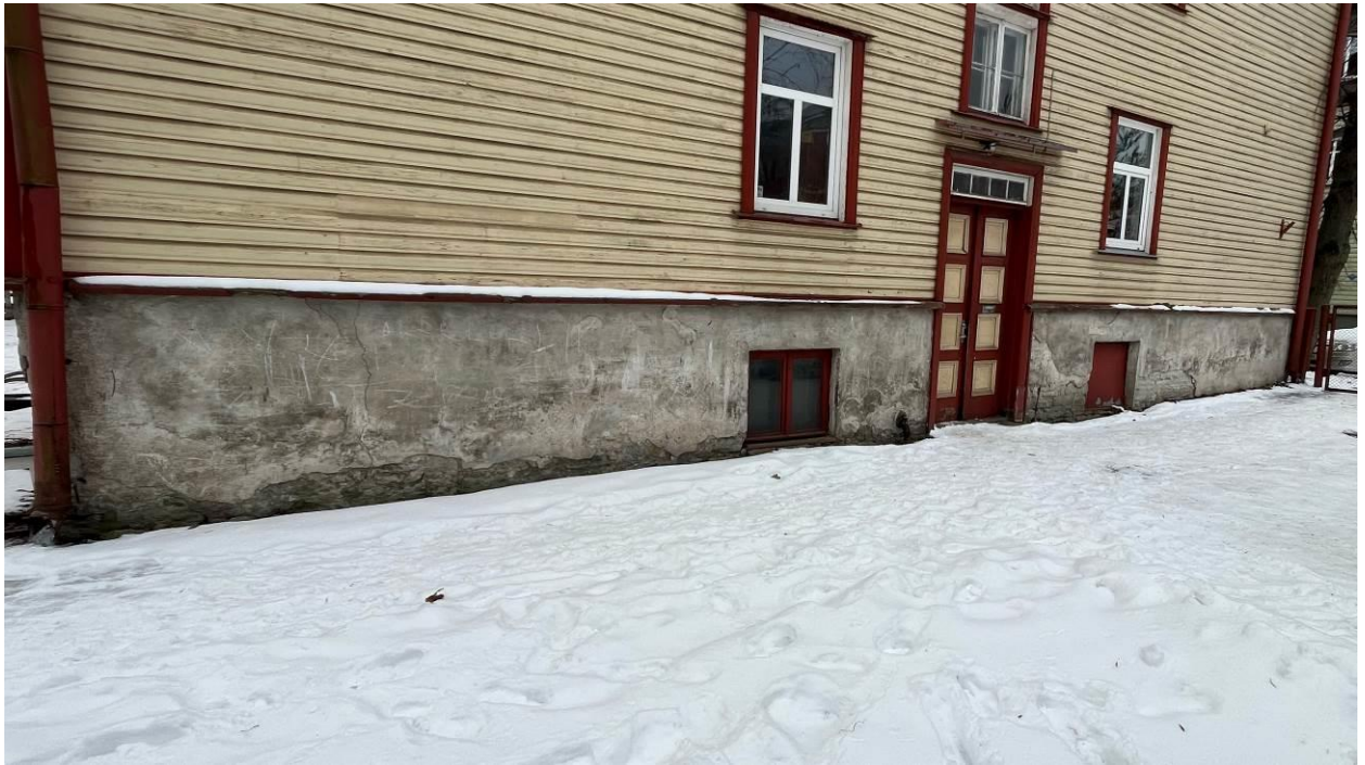
Rekonstrueeritav hoone, sokli vaade idast
