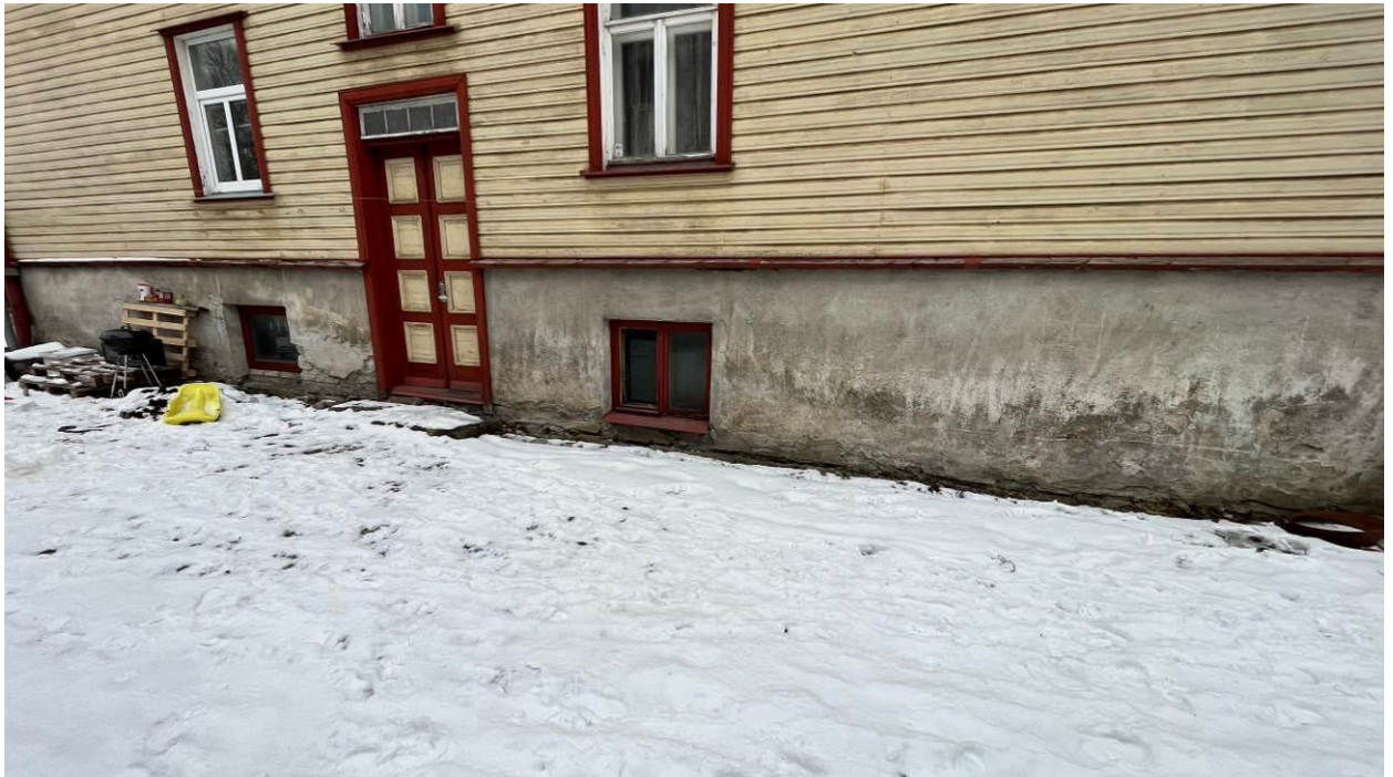
Rekonstrueeritav hoone, sokli vaade läänest
