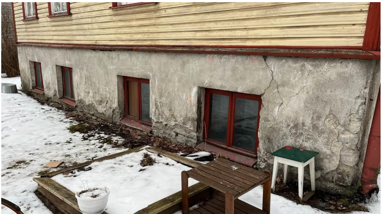
Rekonstrueeritav hoone, sokli vaade lõunast
