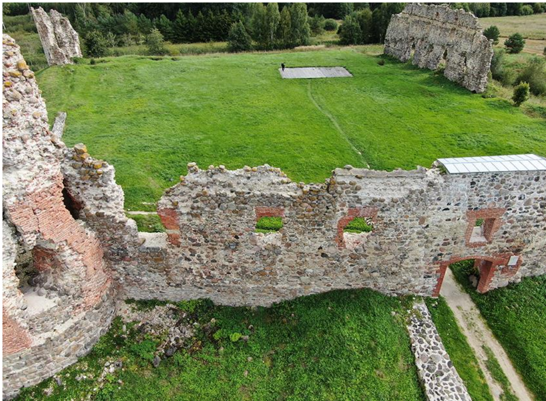
Foto 2. Tõõala väljastpoolt linnusemüüre. Müüride munakivikihid tagasi laduda, müüripind tasandada, valada betoonvöö ning müürid katustada.
