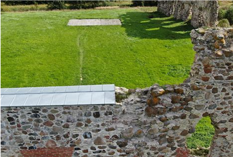
Foto 5. Aastal 2014 katustatud ja konserveeritud müürid väljastpoolt. Võimalusel konserveerida ka katuseta samal tasapinnal olev müürijupp.
