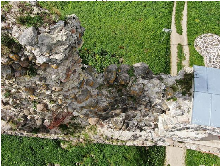
Foto 6. 2014 aastal katustamata jäänud müürijupp. Lahtised kivid kujutavad ohtu külastajatele väravaosas.
