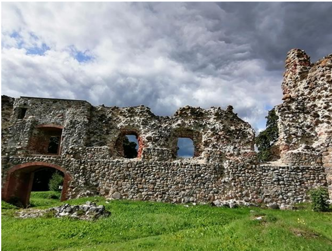
Foto 3. Tõõala siseõue poolt. Tugevalt kahjustunud müüripinnad. Varisenud müürikihid tagasi laduda, konserveerida avad, tagasi laduda müürid, tasandada, laduda betoonvöö ning seejärel katustada.
