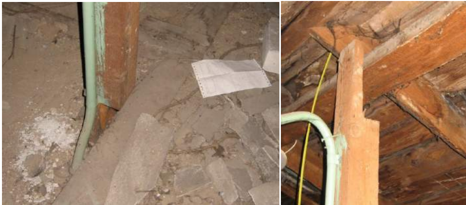
Foto 4 ja 5. – Harjapärliini posti alumine ja ülemine sõlm
