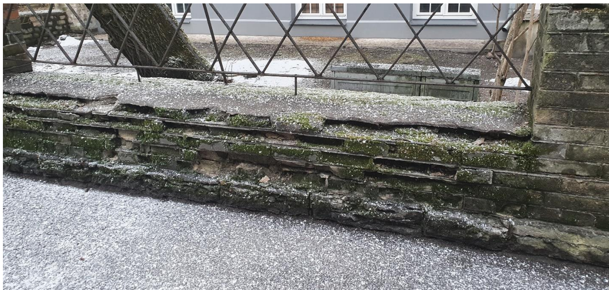
Foto 3 - Paekivi vundament, originaalne tellis lagunened
