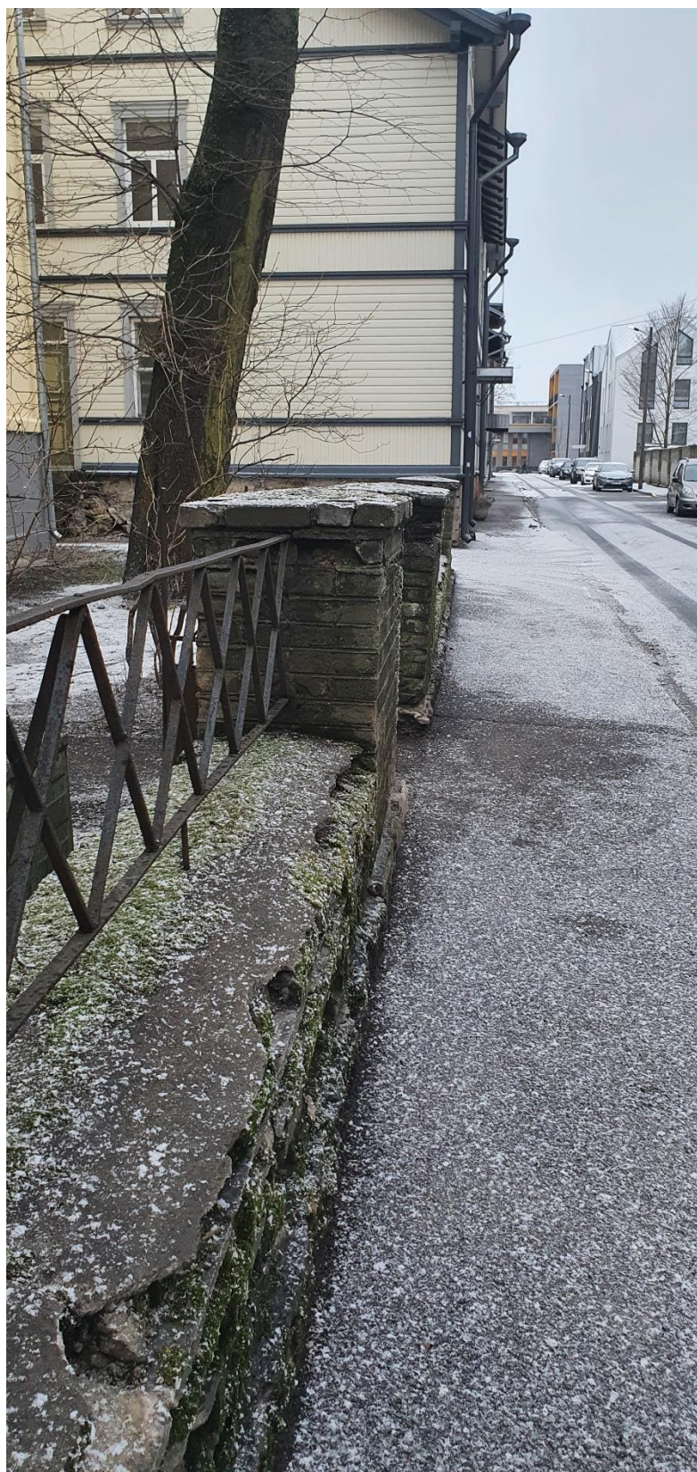
Foto 7 - Tänavalt vaadates jalgväravast parempoolne aia osa on tänavpoole välja vajunud.
