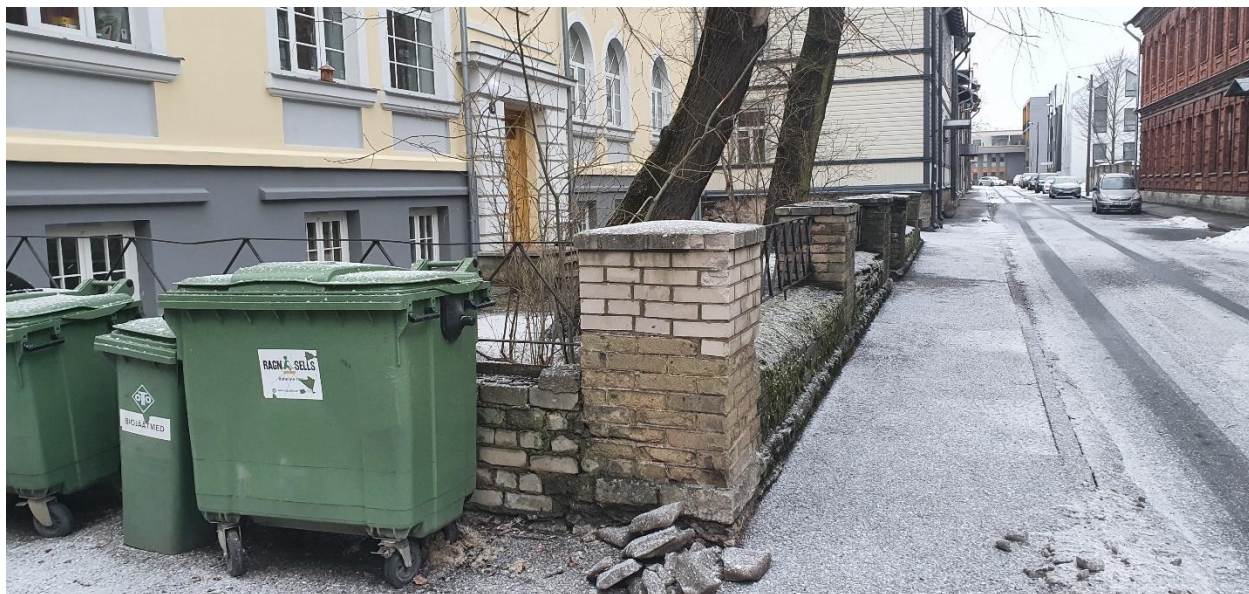
Foto 8 - Külje osal (pügikasti taga) puudub paekivist vundament ja on ehitatud hiljem.
