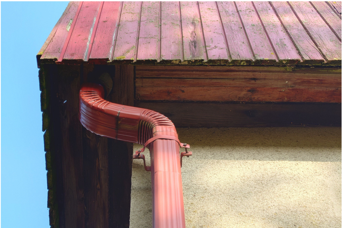
12. Hoone edelanurga vihmaveetoru ja räastakast
