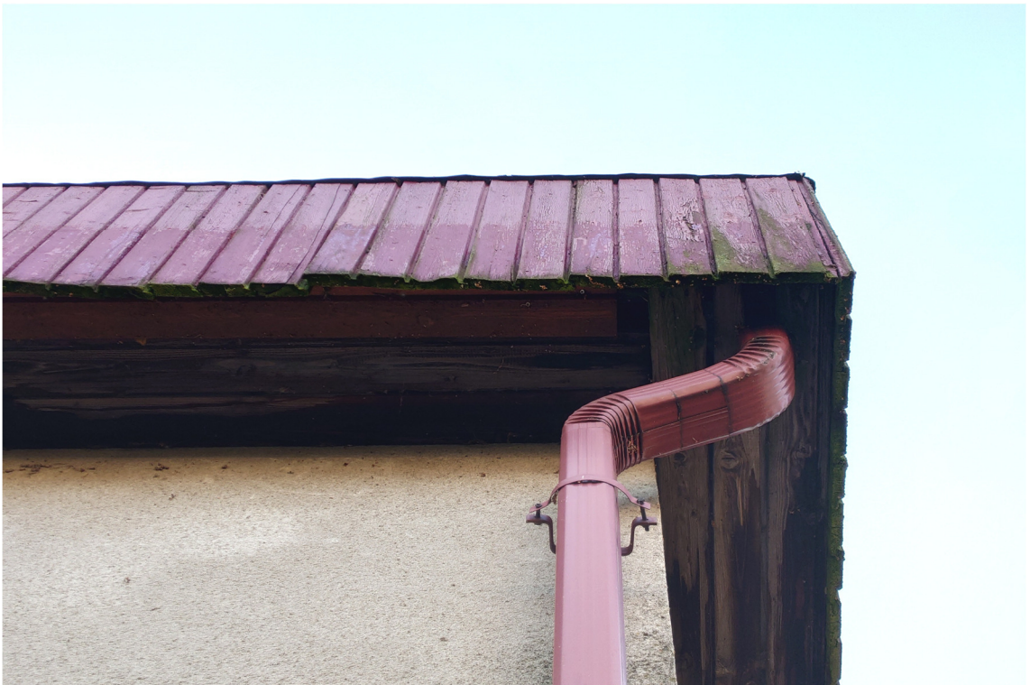
10. Hoone loodenurga vihmaveetoru ja räastakast
