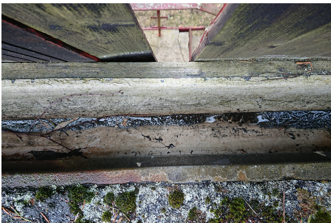
16. Räästakasti tagune vihmaveerenn lõunaküljes
