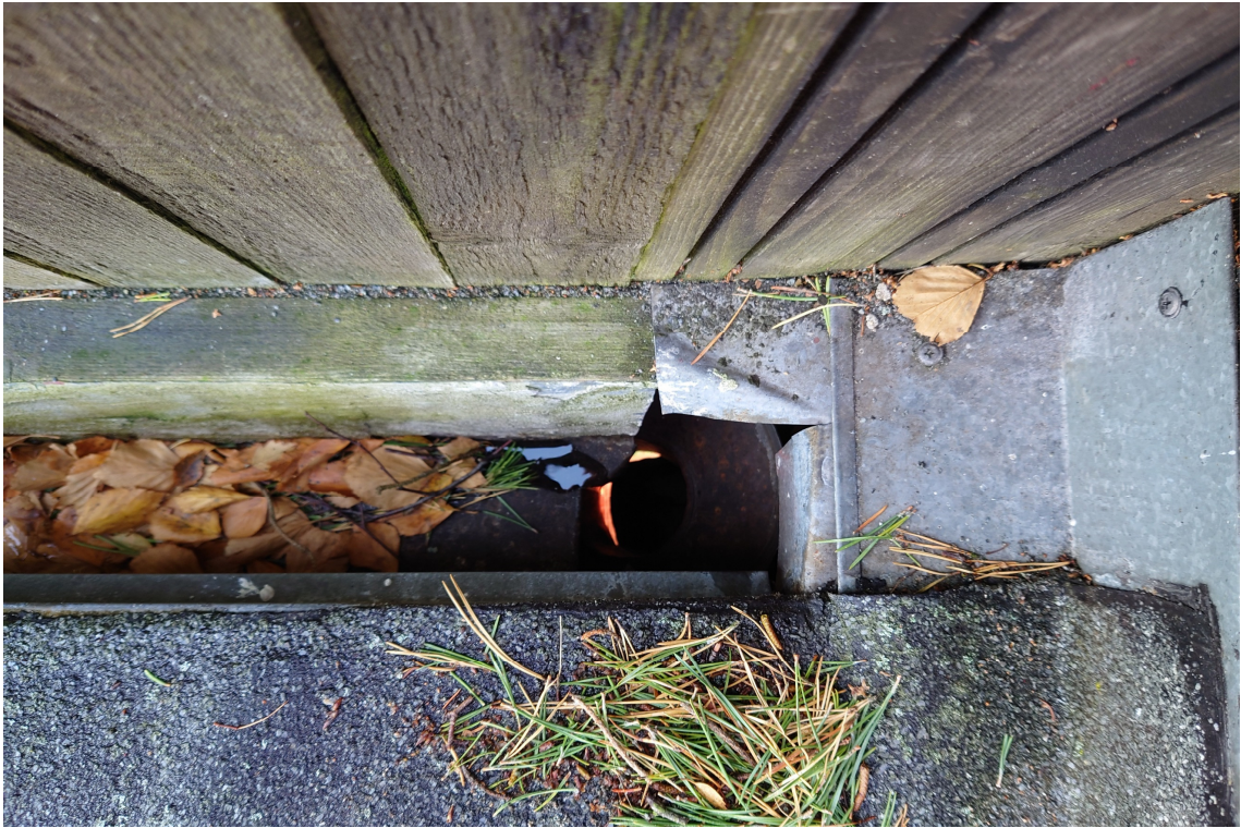
17. Räästakasti tagune vihmaveerenn + lehter lõunaküljes
