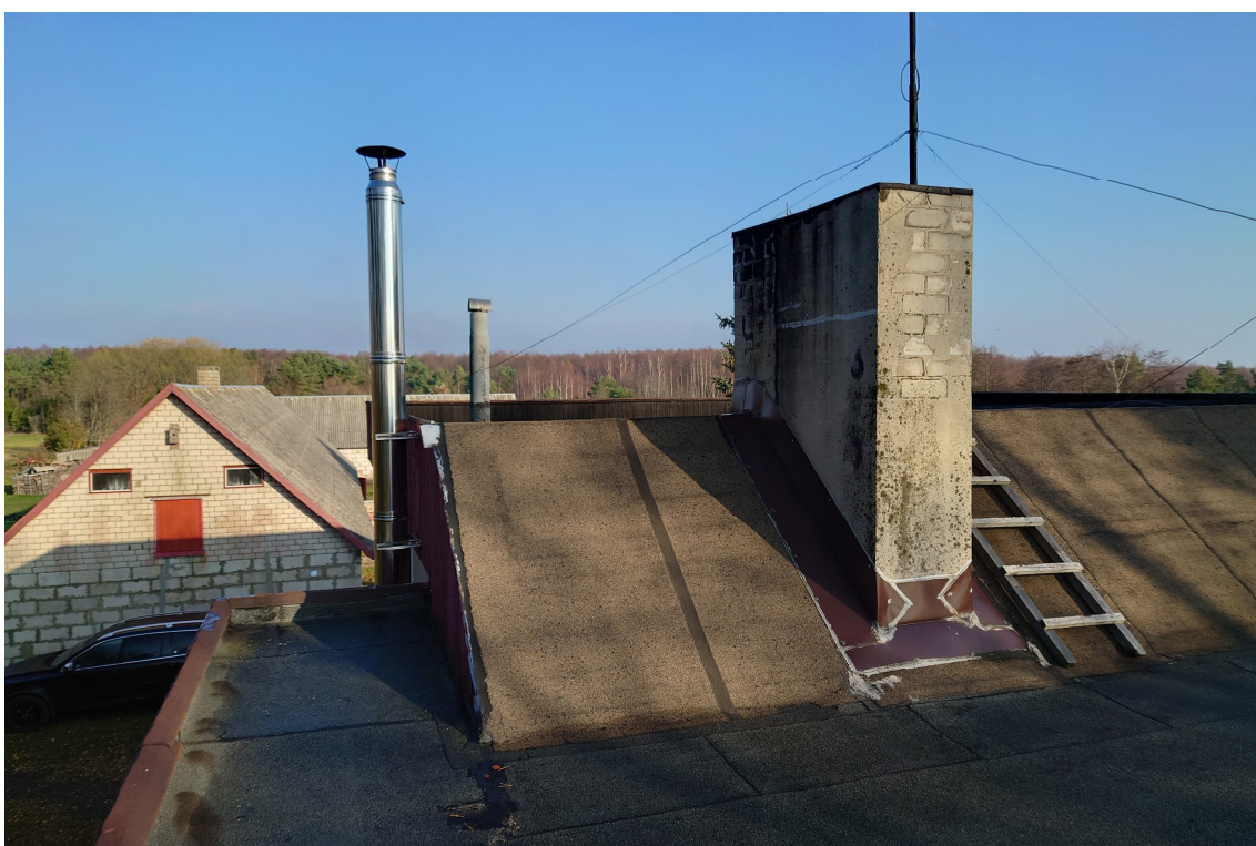
15. Vaade katusetasandite liitumisele läänes + korstnad
