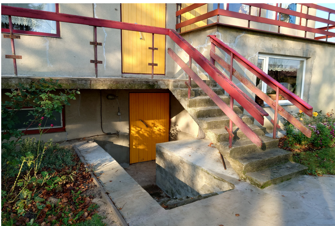
7. Vaade idas keldrisse käigu süvendile
