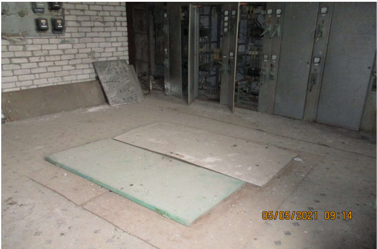
Foto 10. Ruumi V kunagine elektrijaotla osa koos põrandaavausega
