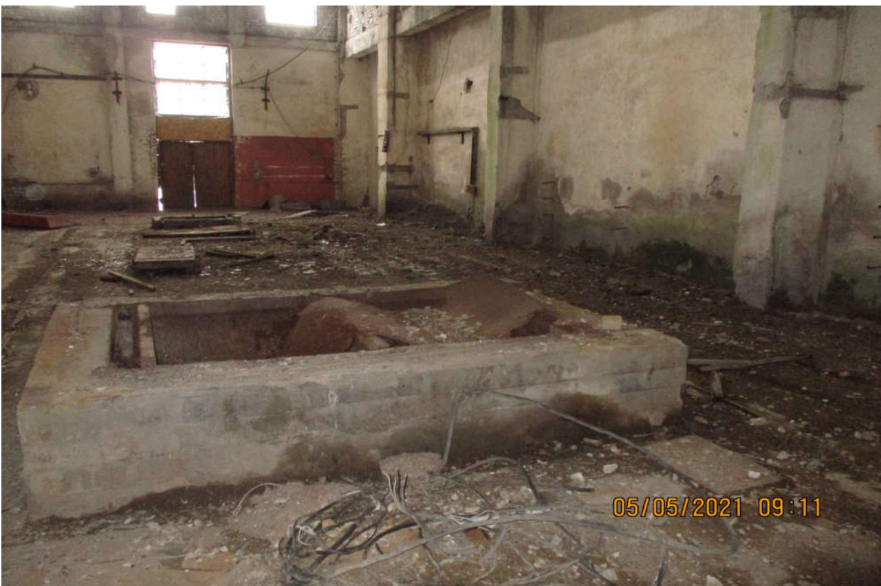
Foto 4. Ruumi IV põrand (vaade itta) koos avaustega
