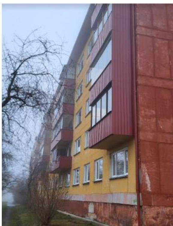
Foto 27 ühekordsed rõdud kaetud otstest plekiga täies ulatuses alt-üles.
