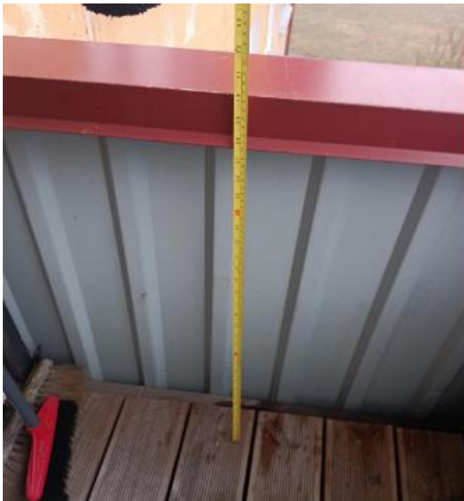
Foto 5. krt 6 Välispiirde kõrgus pole normidele vastav tänu põrandale paigaldatud puitresti tõttu.
