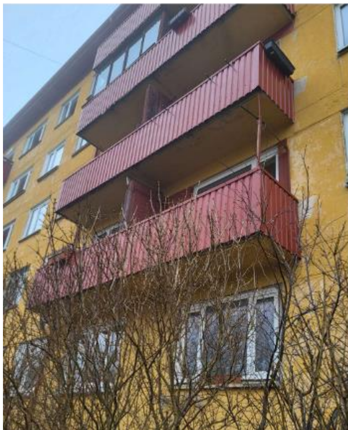
Foto 28. Kahekordsed rõdud, kus põrandal 2 paneeli ning paneelide vahel vuuk ning vahesein
