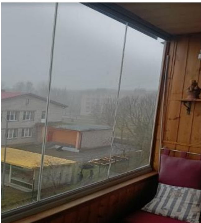
Foto 10. krt 24 Kinni ehitatud rõdu, raamideta klaasid.
