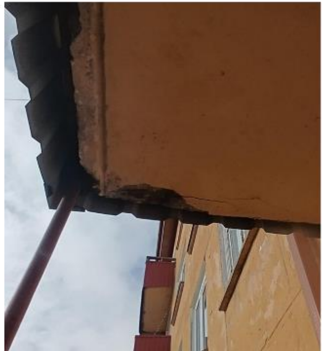
Foto 23. krt 44 Laest pudenenud betooni, armatuur nähtaval, praod.
