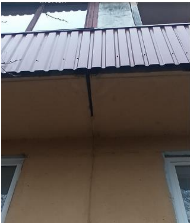
Foto 26. Lagunenud rõdupõranda paneelide vahelised vuugid on lagunenud.
