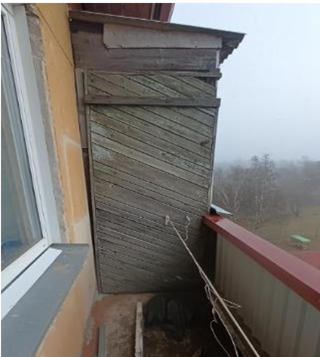
Foto 22. krt. 38 Ilma varikatuseta rõdu, vahesein naaberrõduga tehtud puidust.
