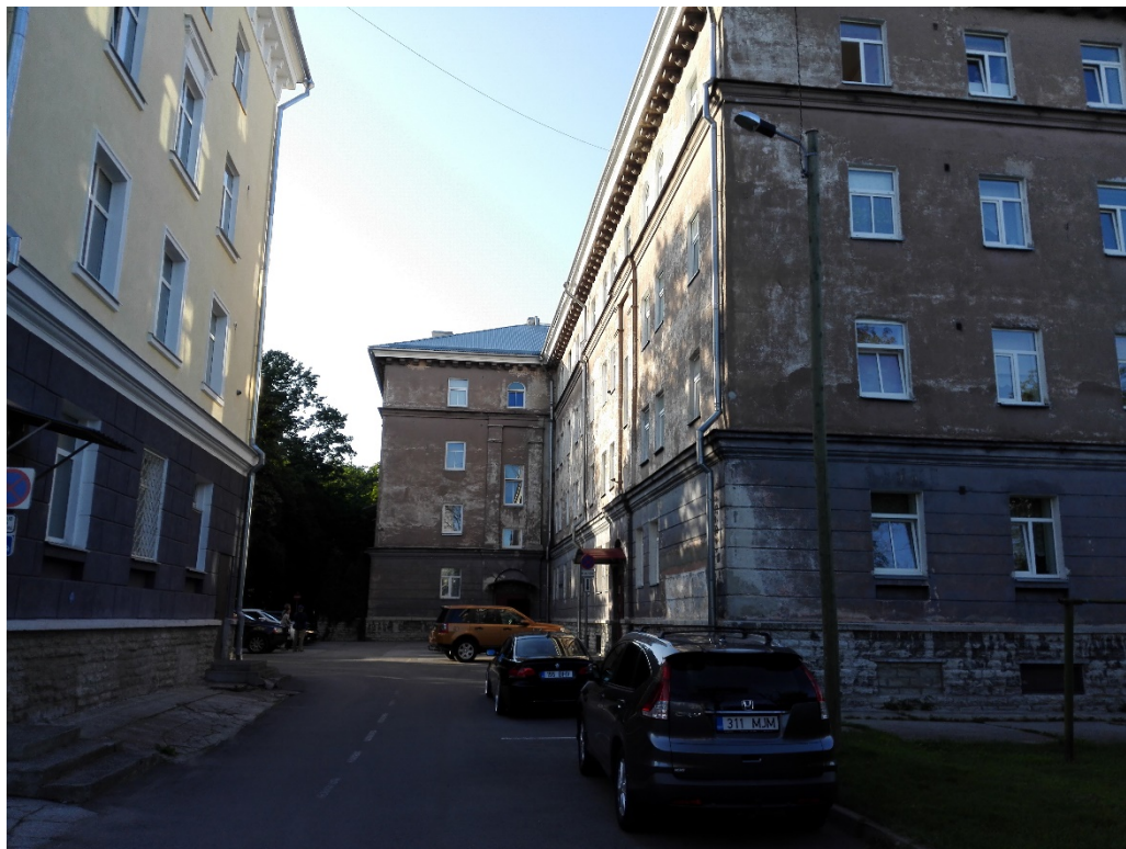
Foto olemasolevast olukorrast: vaade kagust
