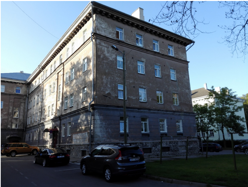
Foto olemasolevast olukorrast: vaade kagust
