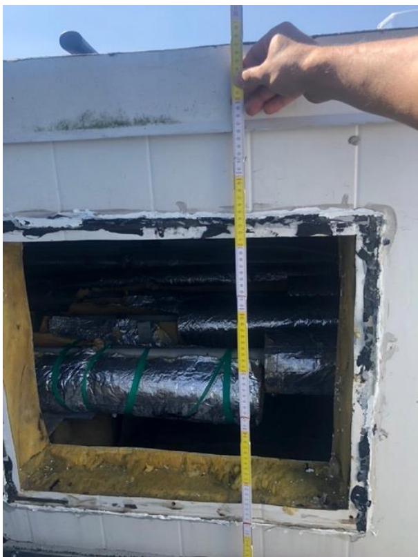
Foto nr 3 – vaade plekist luugiga kaetavale avale šahti seinas. Tehtud lahendus ei ole praktiline, kuna luugi igakordsel avamisel tuleb kruvid eemaldada ning sulgemisel mehhaaniliselt jälle kinnitada ja tihendada mastiksiga, et oleks tagatud luugi ilmastikukindlus. Samuti puudub tegelikkuses vaadeldava luugi asukoha tõttu tehnosüsteemide täieliku teenindamise võimalikus. Foto on tehtud varasemalt objektiga tutvumisel, 19.08.2020.
