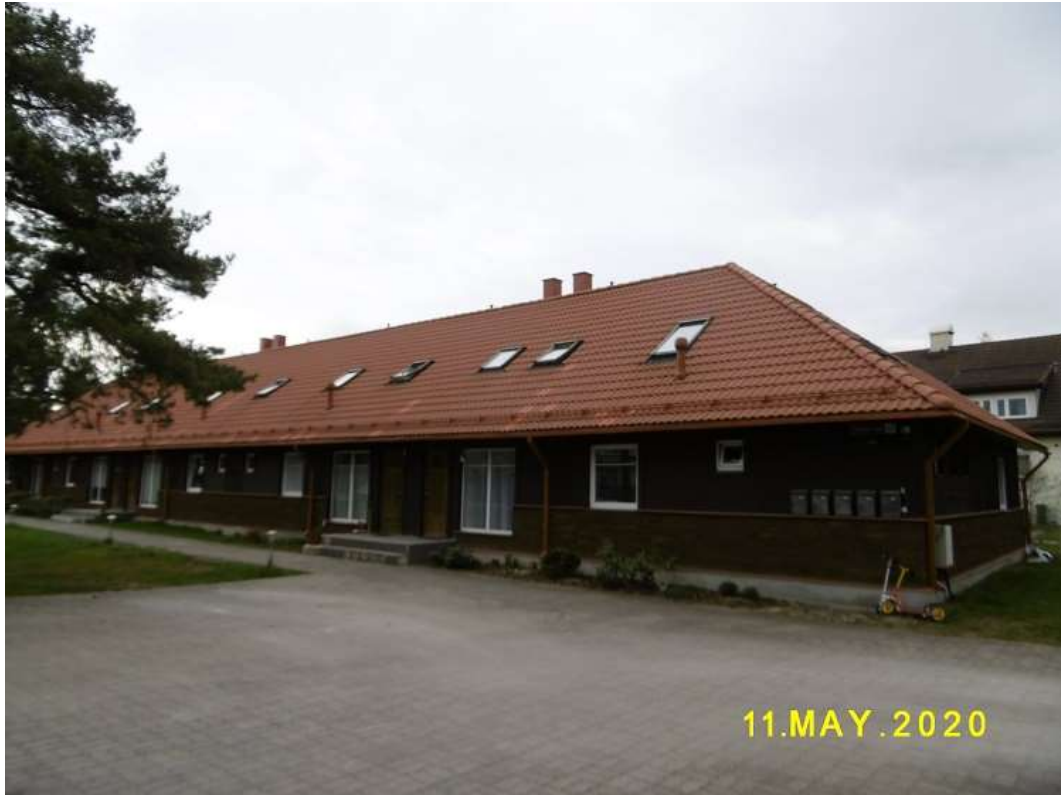
Foto 1. Kahekorruselise korterelamu sokkel on soojustatud ja kaetud õhekrohviga, fassaad on kaetud osaliselt tellistega ja osaliselt värvitud puitlaudisega.
