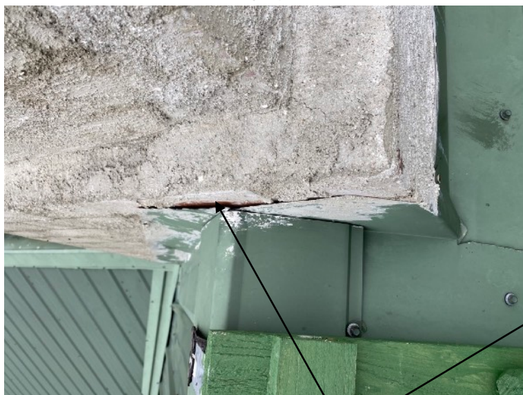
Fotod 11 ja 12. Fotol 11 on vaade vanema hooneosa korstna liiteplekile, fotol 12 on vaade juurdeehituse korstna liiteplekile - mõlemal juhul on näha tühimikud liitepleki ja korstna vahel.
