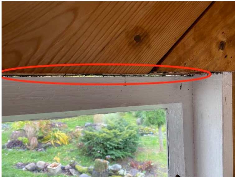
Foto 27 paremal. Vaade fotol 25 nähtavale aknaplokile siseruumist. Punasega tähistatud alas paistab selgesti valgus läbi aknalengi ja seina liite.
