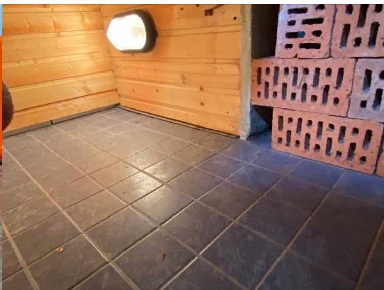
Fotod 43 ja 44. Fotol 43 vaade leiliruumi ja pesuruumi vahelisele uksele. Fotol 44 vaade leiliruumi põrandale. Mõlemas kohas puudub põranda hüdroisolatsiooni ülespööre vertikaalpinnale 100 mm nagu see on nõutav RIL107 kohaselt.
