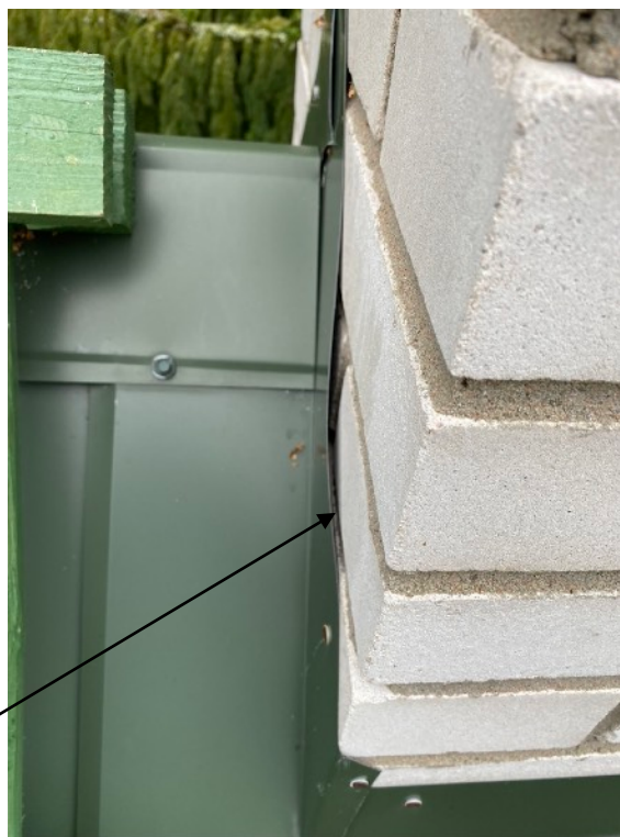
Fotod 11 ja 12. Fotol 11 on vaade vanema hooneosa korstna liiteplekile, fotol 12 on vaade juurdeehituse korstna liiteplekile - mõlemal juhul on näha tühimikud liitepleki ja korstna vahel.
