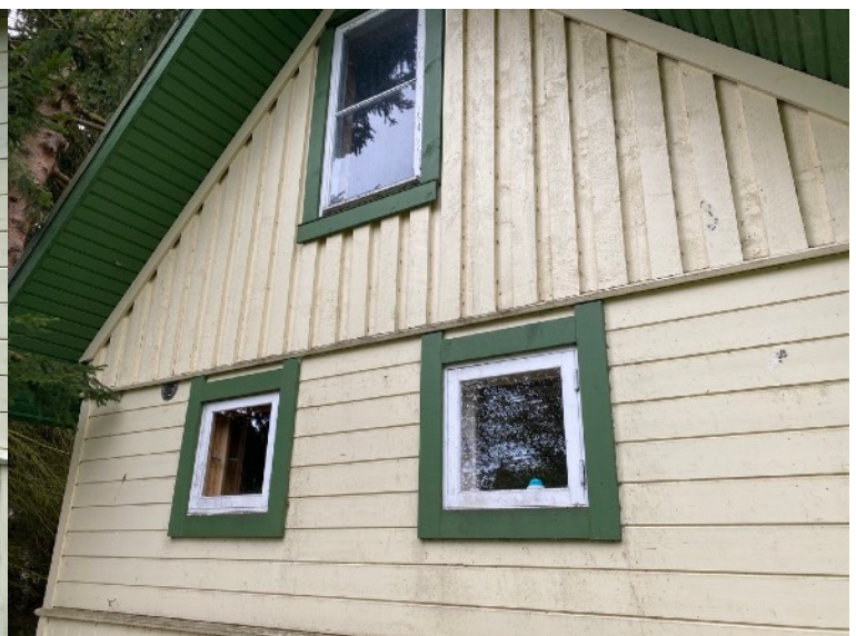
Fotod 28 ja 29 all. Fotol 28 on vaade vanema hooneosa otsaseinale, akendel puuduvad veeplekid. Foto 29 on vaade juurdehituse otsaseinale, akendel puuduvad veeplekid.
