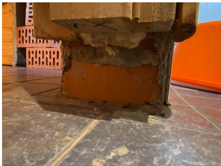
Fotod 43 ja 44. Fotol 43 vaade leiliruumi ja pesuruumi vahelisele uksele. Fotol 44 vaade leiliruumi põrandale. Mõlemas kohas puudub põranda hüdroisolatsiooni ülespööre vertikaalpinnale 100 mm nagu see on nõutav RIL107 kohaselt.
