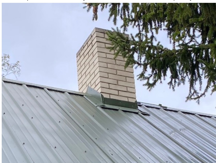
Fotod 13 ja 14. Fotol 13 vasakul on vaade juurdeehituse korstnale, liitepleki vertikaalne kõrgus ca 100 mm. Fotol 14 paremal on vaade vanemale hooneosale. Korstna liitepleki ülespöörde kõrgus samuti ca 100 mm, lisaks on näha pleki kattumine mastiksigiga, mis viitab läbijooksu ajutisele sulgemisele.
