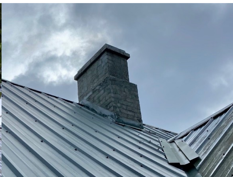
Fotod 13 ja 14. Fotol 13 vasakul on vaade juurdeehituse korstnale, liitepleki vertikaalne kõrgus ca 100 mm. Fotol 14 paremal on vaade vanemale hooneosale. Korstna liitepleki ülespöörde kõrgus samuti ca 100 mm, lisaks on näha pleki kattumine mastiksigiga, mis viitab läbijooksu ajutisele sulgemisele.
