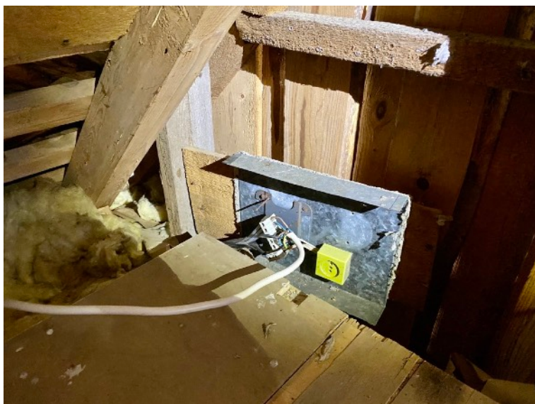
Foto 47. Vaade peakaabli sisendile pööningul. Ühendus ei ole tolmu ja niiskuskindel.
