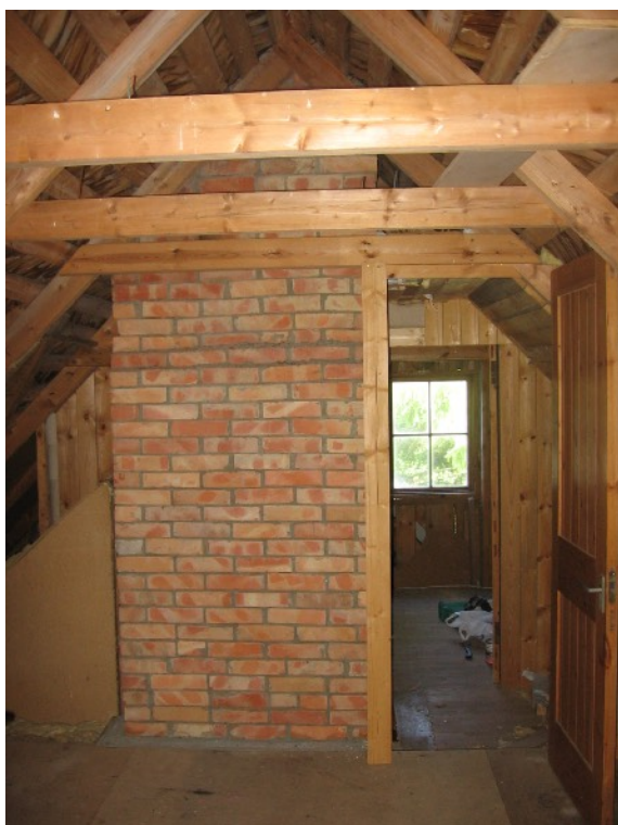
Foto 46. Vaade puidust siseustele külmal pööningul.
