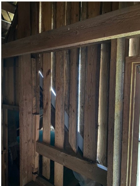
Foto 22 on vaade vanema ja juurdeehituse vahel olevale seinaosale. Laudise vahelt kumab läbi valgus.
