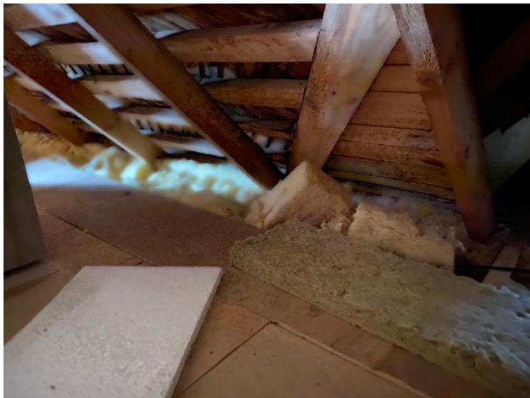
Foto 36. Katmata pööningu põranda soojustus vanemas hoone osas.
