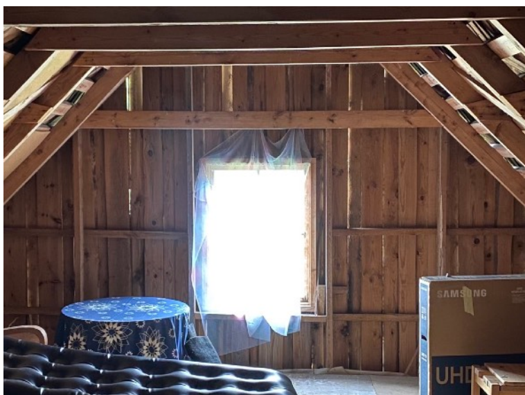
Fotod 20 ja 21. Fotol 20 on vanema hooneosa viilu ots. Laudise vahelt kumab läbi valgus. Fotol 21 on veranda kohal oleva viilu ots. Laudise vahelt kumab läbi valgus.
