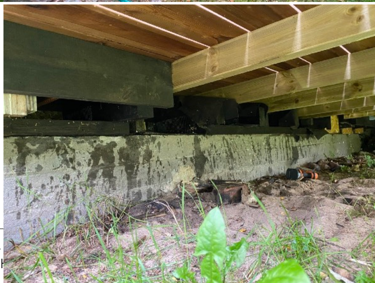
Fotol 37 üleval vasakul on vaade juurdeehituse tänava poolsele soklile. Soklis tuulutusava puudub.
