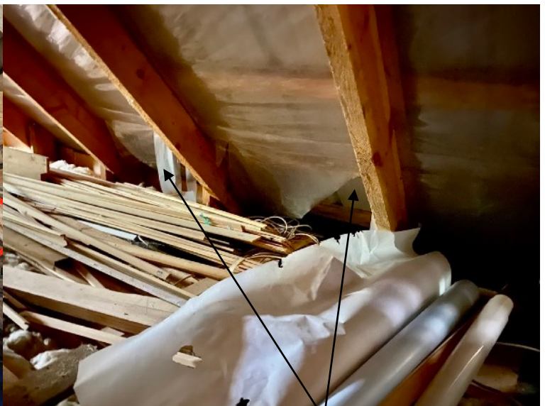
Fotod 18 ja 19. Fotol 18 on punasega tähistatud varasemate pennide asukohad. Fotol 19 on näha katkine katuse aluskate.
