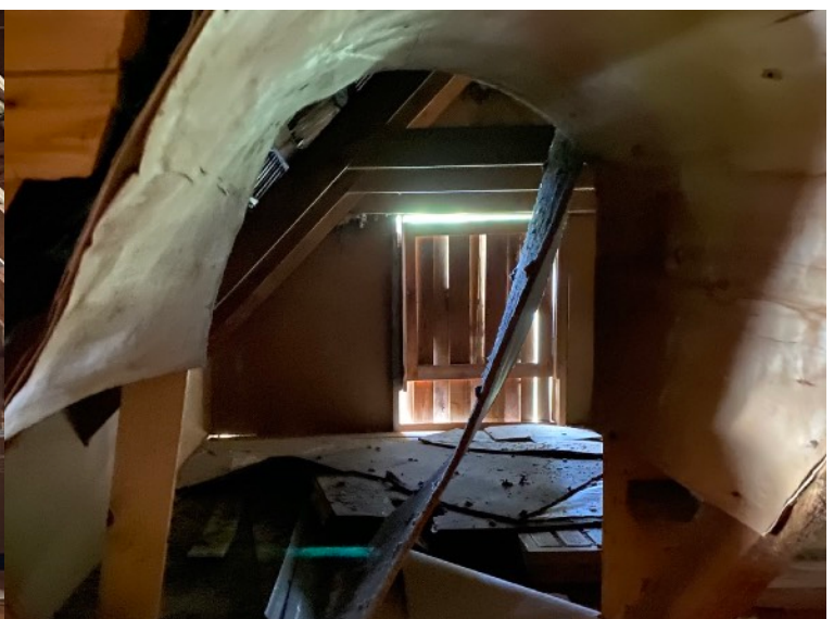
Fotod 20 ja 21. Fotol 20 on vanema hooneosa viilu ots. Laudise vahelt kumab läbi valgus. Fotol 21 on veranda kohal oleva viilu ots. Laudise vahelt kumab läbi valgus.
