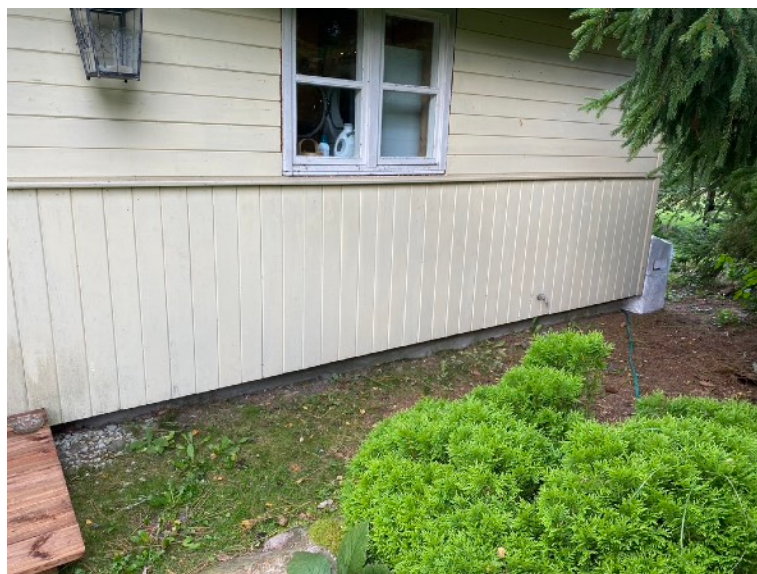
Fotol 37 üleval vasakul on vaade juurdeehituse tänava poolsele soklile. Soklis tuulutusava puudub.
