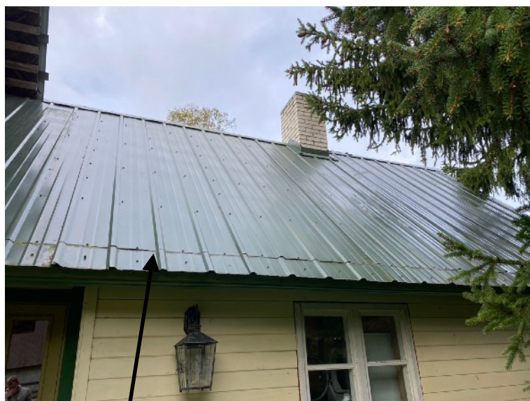
Foto 1. Vaade juurdeehituse tänava poolsele küljele. Katuse plekk on jätkatud mõnekümne sentimeetri kauguselt räästast.
