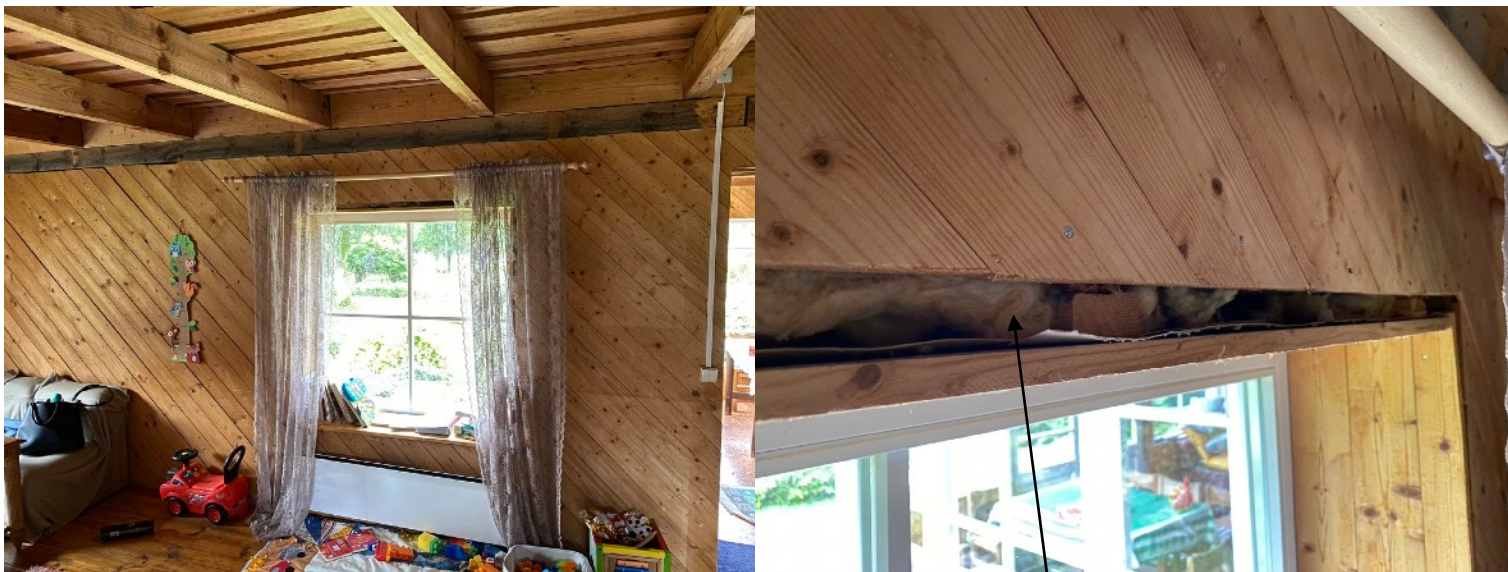
Fotod 34 ja 35. Vaade tihendamata aknaliitele. Fotod 35 on näha siseõhuga kontaktis olev mineraalvill.
