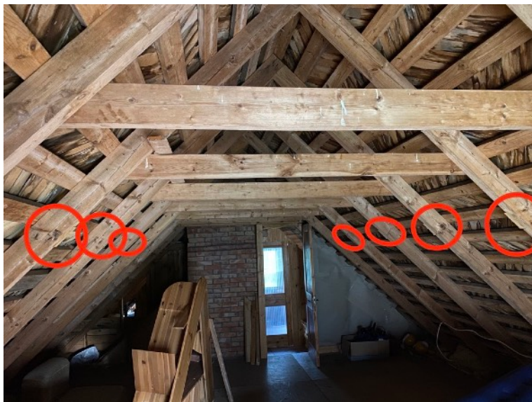
Fotod 18 ja 19. Fotol 18 on punasega tähistatud varasemate pennide asukohad. Fotol 19 on näha katkine katuse aluskate.
