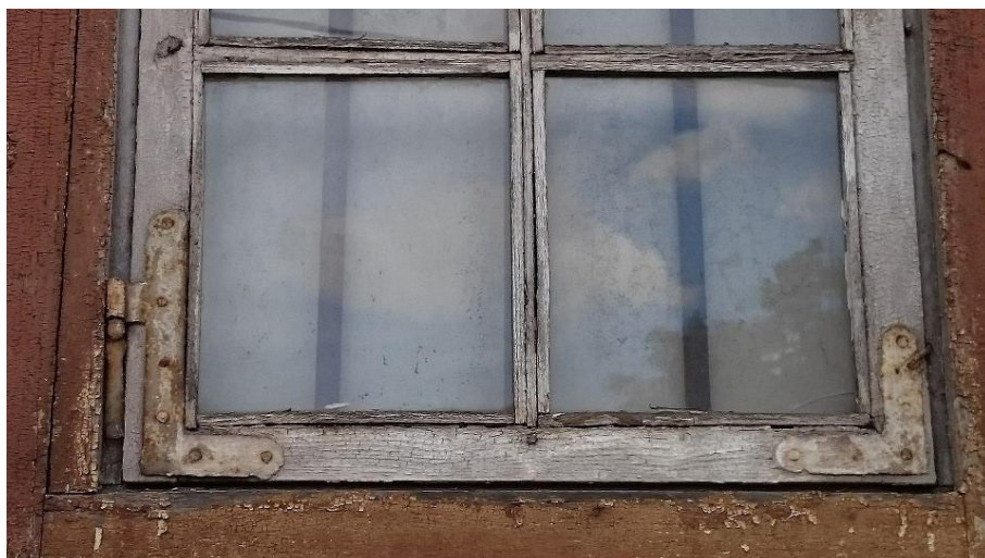
Foto nr 21. Sama akna klaasid on kinnitatud liistudega.
