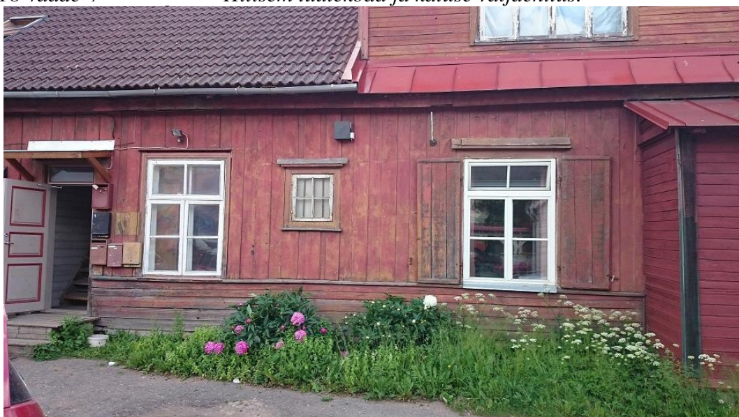
Foto nr 19. Vaade idast. Keskmise väike aken on algne, säilinud koos sepismanustega. Aknaalune osa ja sokkel on kaetud kitsa rõhtlaudisega.
