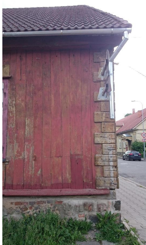
Foto nr 16 Nurgarustika lagunenud, vihmaveerenni alumine osa puudub
