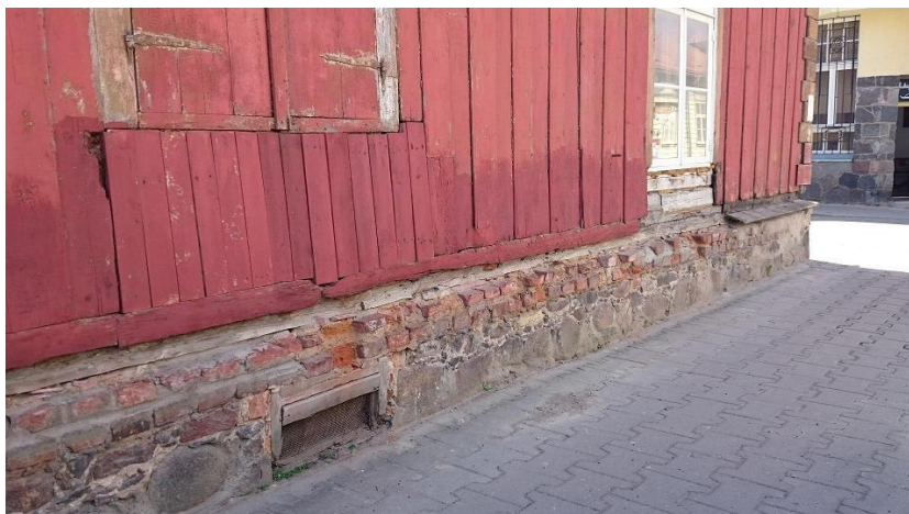
Foto nr 12. Põhjapool soklilaud puudu, paremal pool säilinud ca 2 m pikkuselt.
