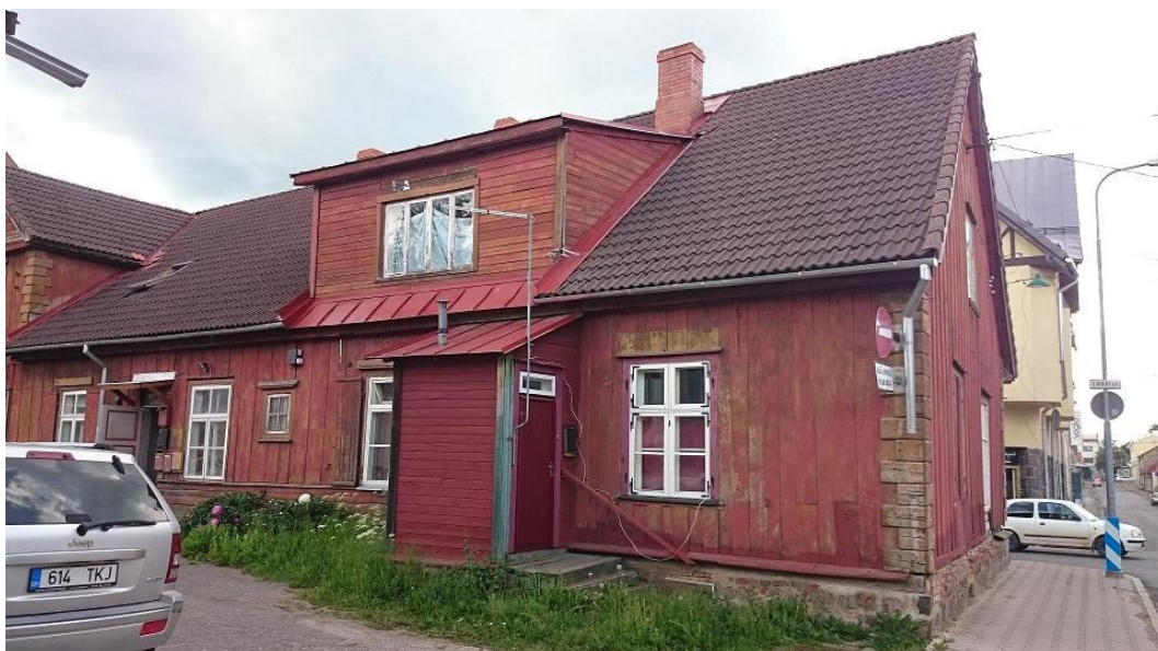
Foto nr 18 Vaade Hilisem tuulekoda ja katuse väljaehitus.
