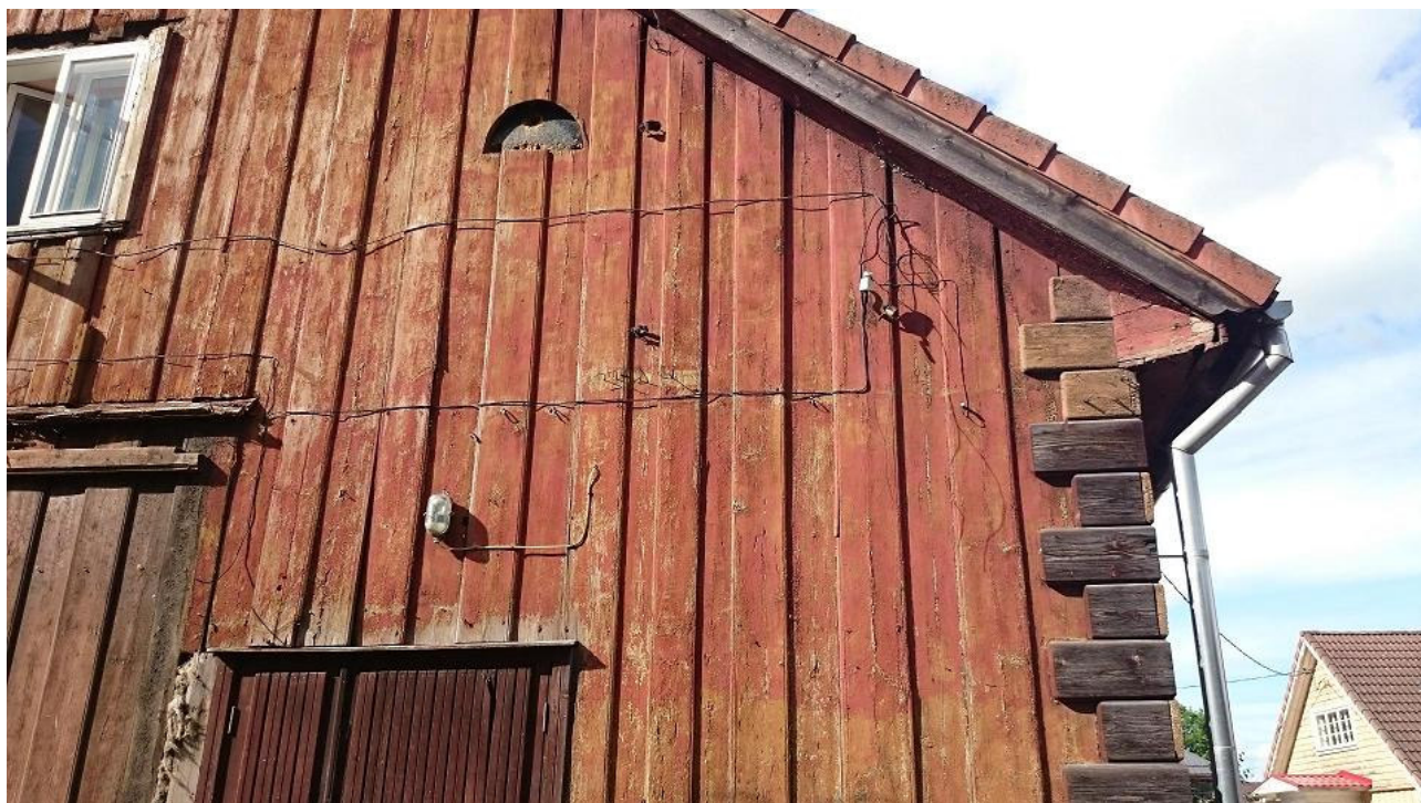
Foto nr 29 Vaade lõunast. Sein lähivaates. Otsaviilu ehislõikelise otsaga lauad vajavad viimistlemist.
