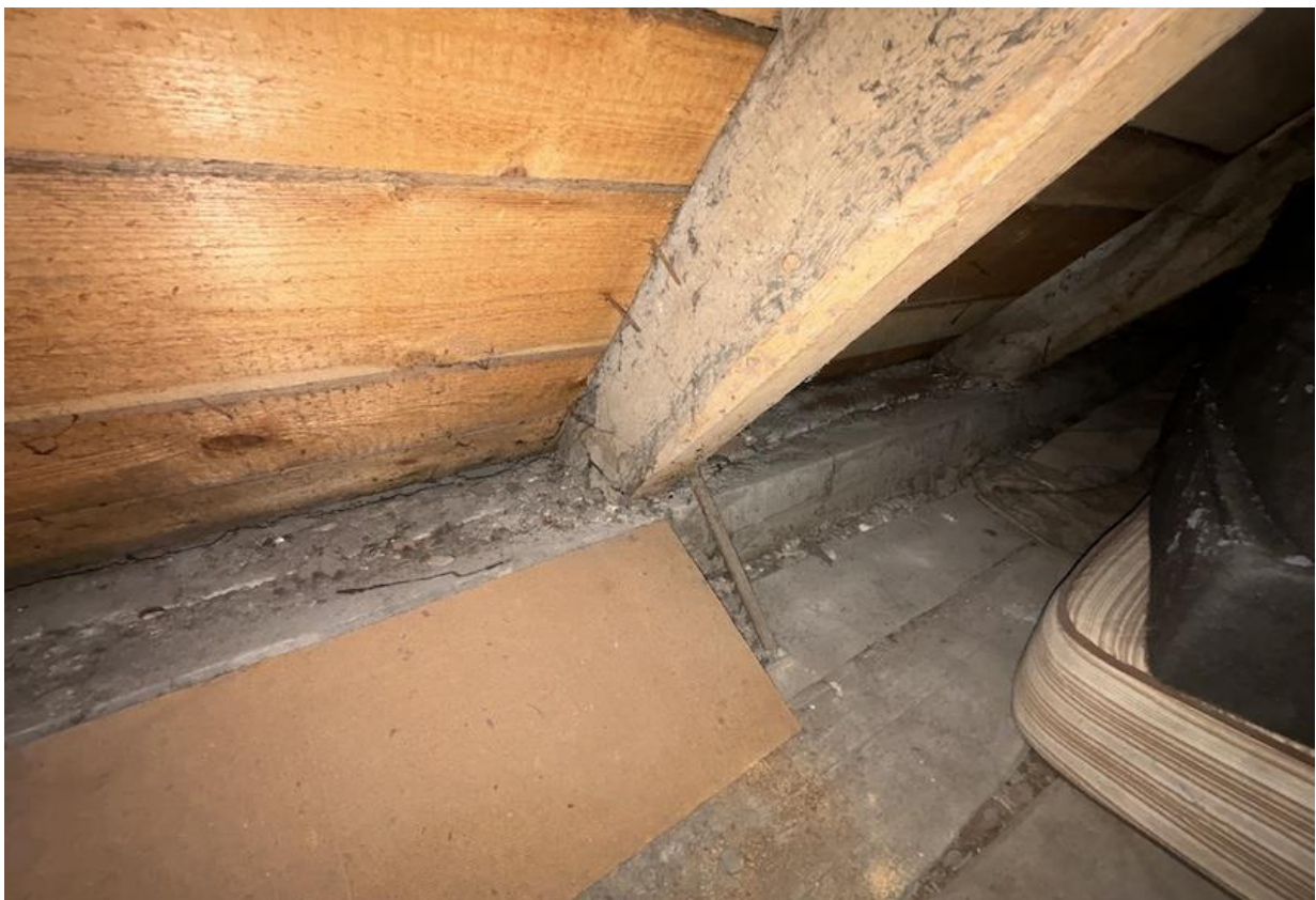
Fotod 40-41. Sarikate räästa poolsed otsad ning müürlatt on kuivad ja ilma nähtavate kahjustusteta.
