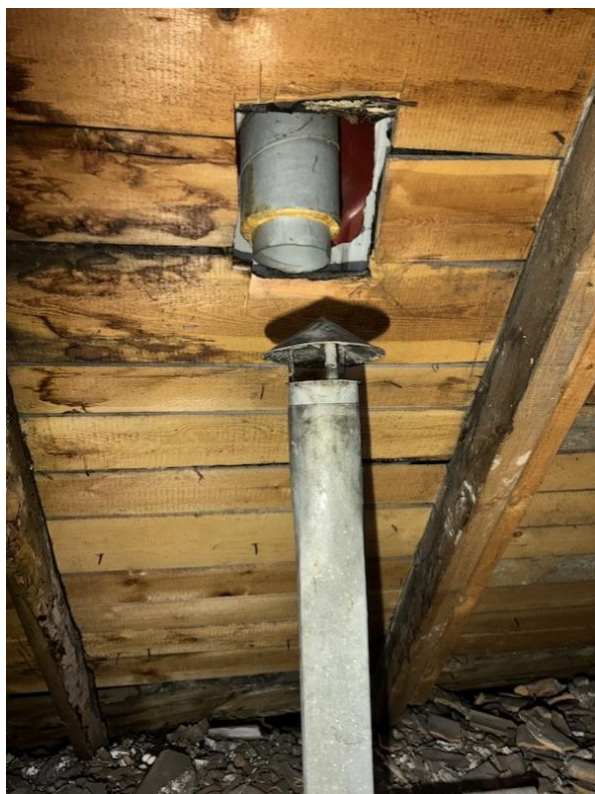
Fotod 22-23. Kanalisatsiooni tuulutuskorstnad on katusest läbi viimata või tehtud seda käepäraste mitesobivate materjalidega.
