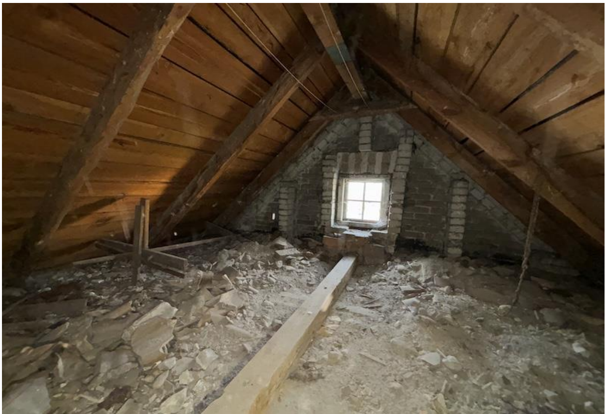
Foto 44. Pööningu põrand on kaetud ehitusprahiga.
