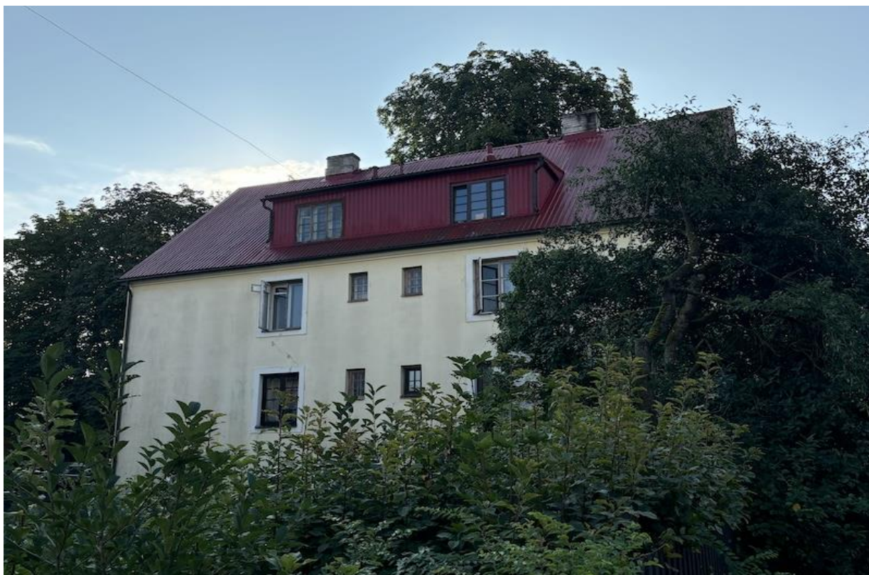
Foto 3-4. Vaade hoone katusele edelast ja loodest.
