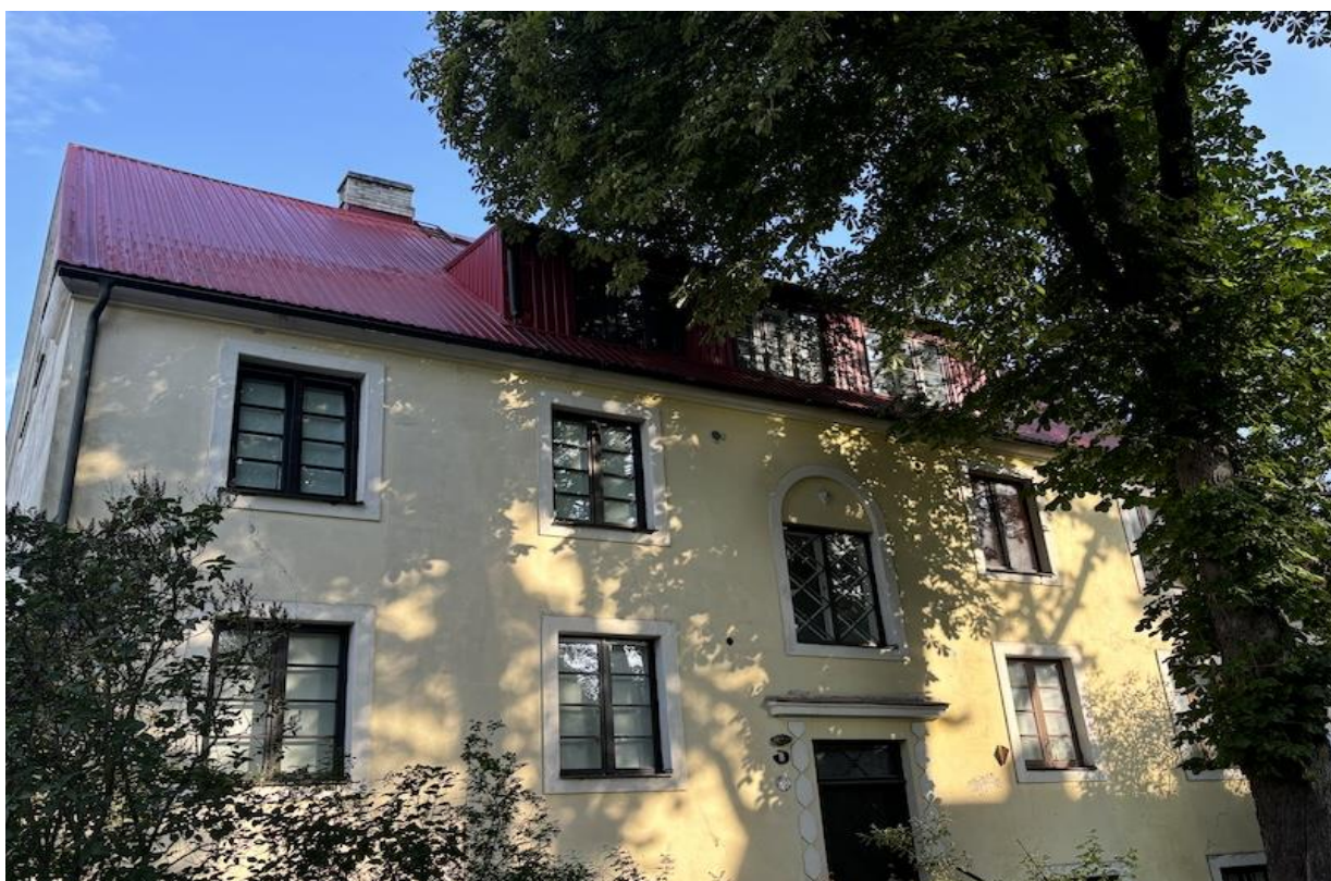
Fotod 1-2. Vaade hoone katusele kagust ja lõunast.
