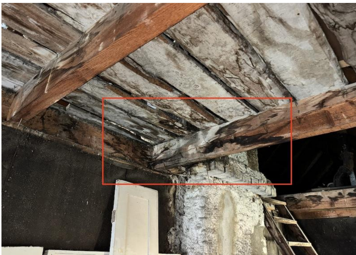
Fotod 32-33. Suuremad niiskuskahjud avalduvad korstnate ümber ja vintskappide külgliseinte osas.
