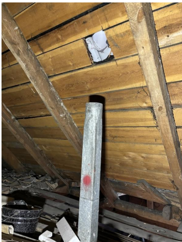
Fotod 22-23. Kanalisatsiooni tuulutuskorstnad on katusest läbi viimata või tehtud seda käepäraste mitesobivate materjalidega.
