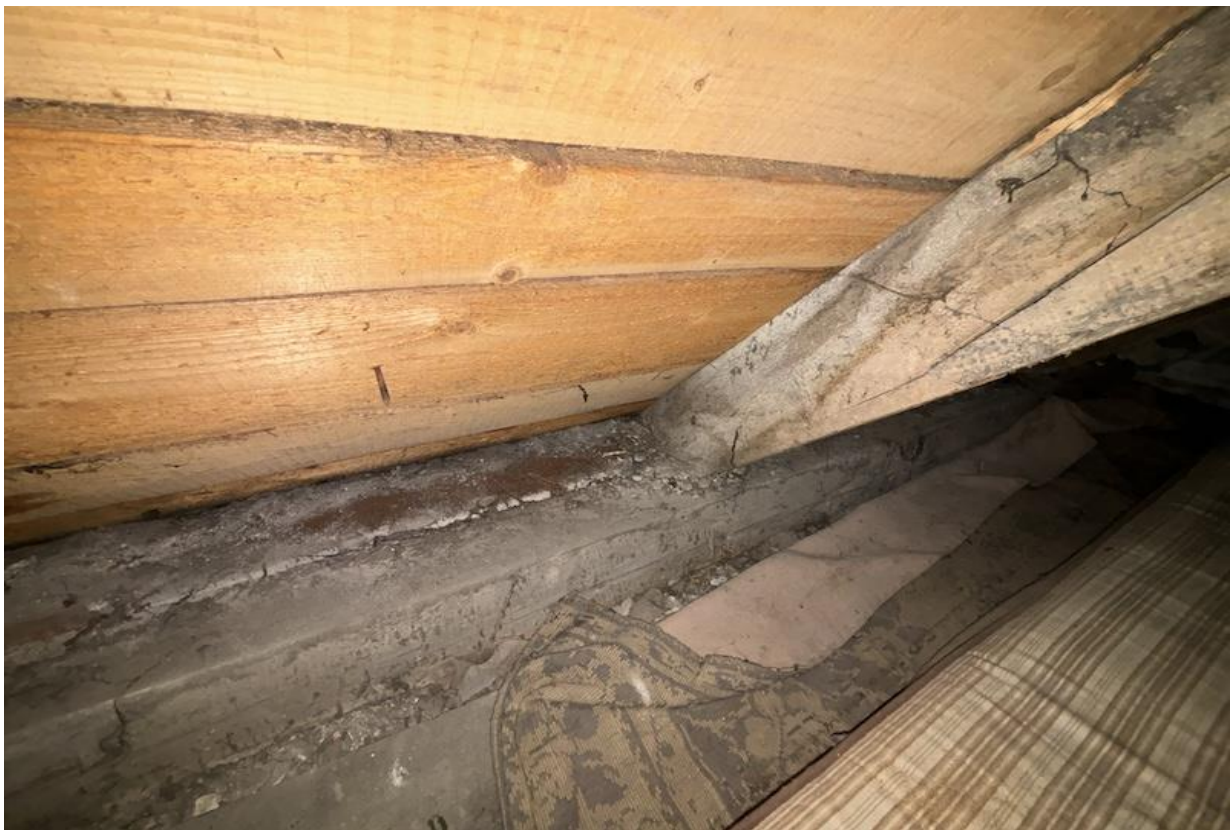
Foto 42. Sarikate räästa poolsed otsad ning müürlatt on kuivad ja ilma nähtavate kahjustusteta.
