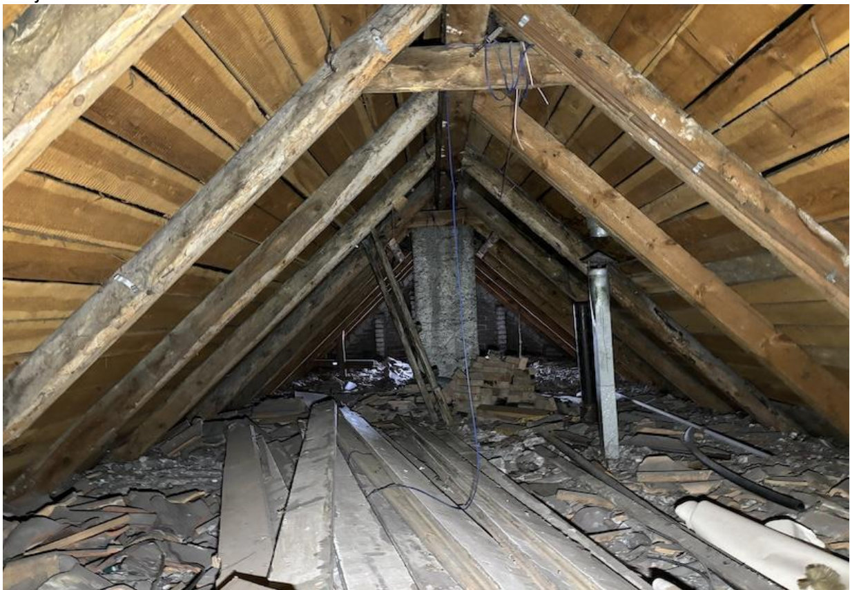
Foto 43. Pööningu nõrand on kaetud ehitusprahiga.
