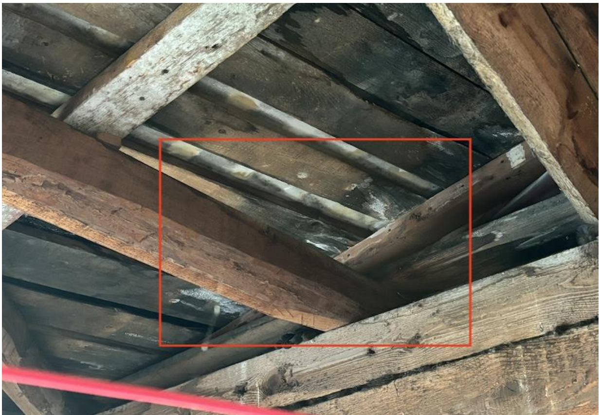
Fotod 34-35. Suuremad niiskuskahjud avalduvad korstnate ümber ja vintskappide külgseinte osas.
