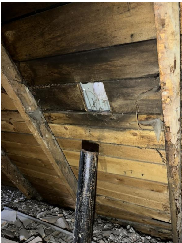
Fotod 24-25. Kanalisatsiooni tuulutuskorstnad on katusest läbi viimata või tehtud seda käepäraste mittesobivate materjalidega.
