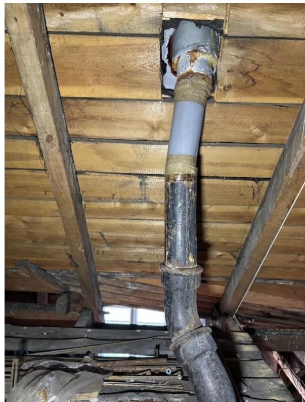
Fotod 24-25. Kanalisatsiooni tuulutuskorstnad on katusest läbi viimata või tehtud seda käepäraste mittesobivate materjalidega.
