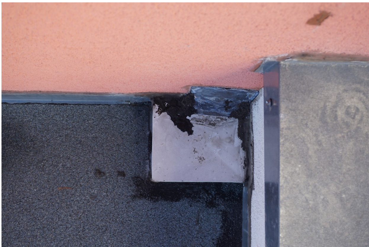
4.3.3 – Предполагаемое аварийное место протечки.
