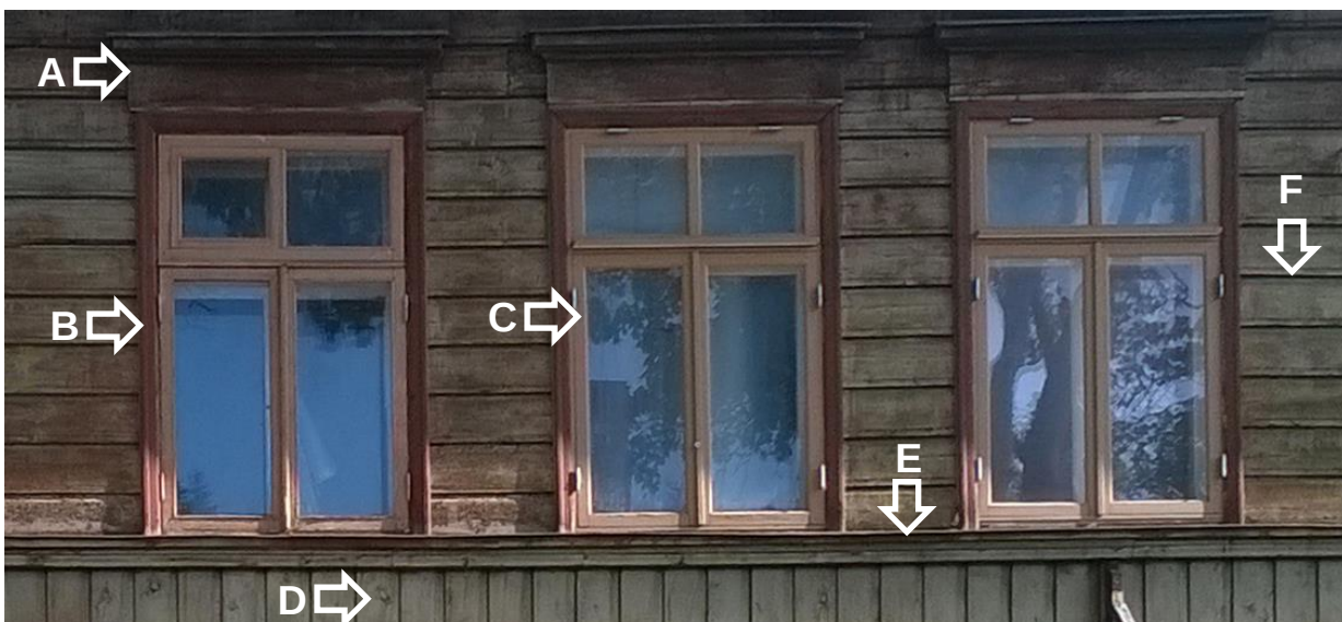
Foto 22 Fragment tänavapoolsest fassaadist (vt foto 10) – hoone poolse otsa 2. korrus: fassaadi detailid, millest võtta eeskujud:
