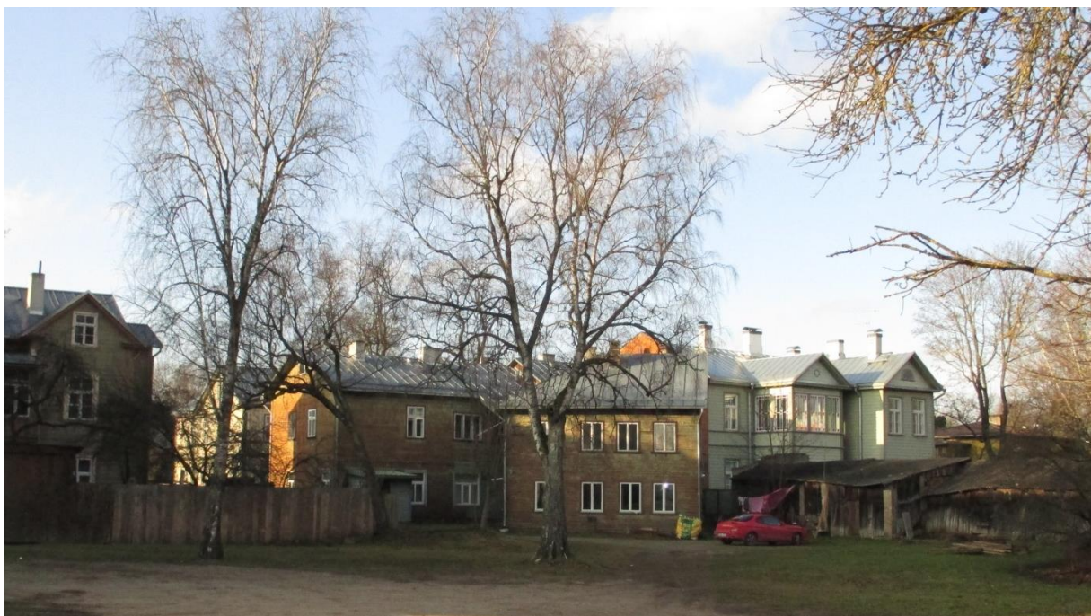
Foto 38 hoone õuepoolse tiiva katuse kaldenurk pole ././ tänavalt nähtav
