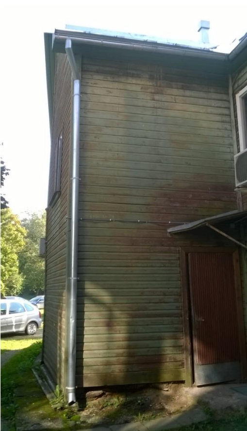
Foto 15 siseõu, tiibhoone otsasein on kergelt kummis
