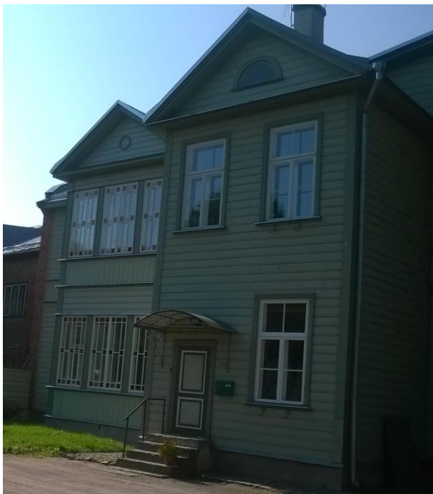
Foto 29 Näide: Varikatus ja välisuks õue- poolisel küljel
