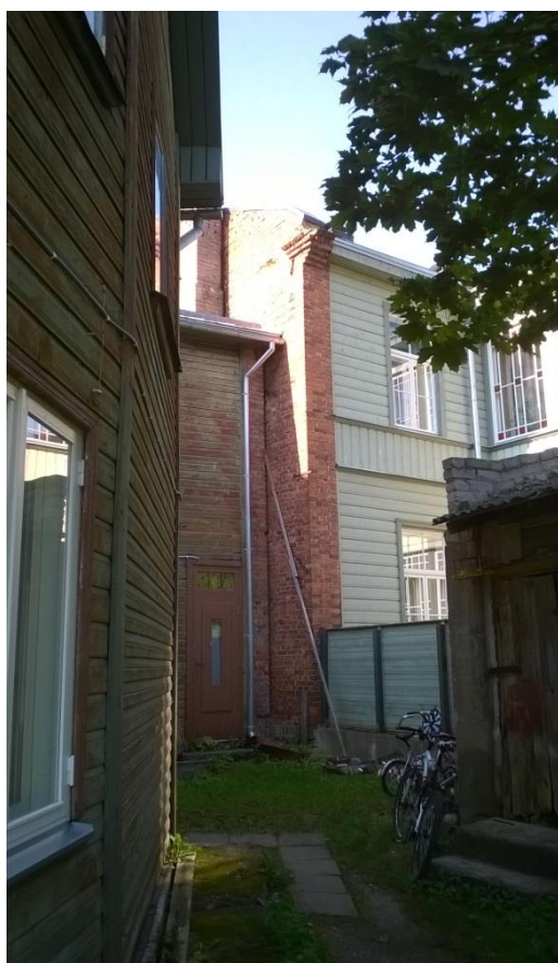
Foto 14 siseõu, tulemüür kinnistu piiril – vaade õue poolt
