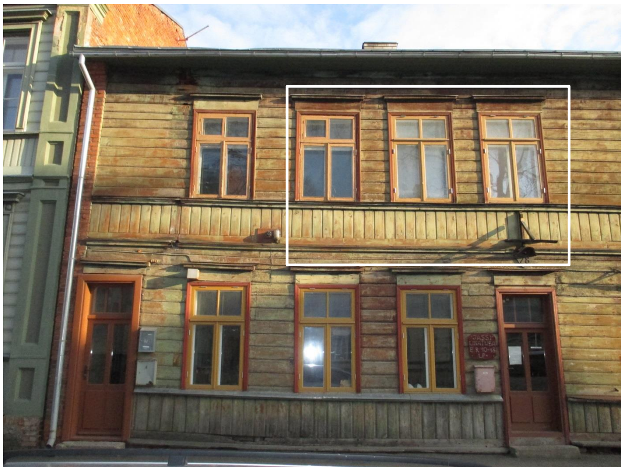
Foto 10 tänavapoolne olemasolev puitfassaad, tähistatud 2.korruse fasaadifragment vt foto 22: fassaadidetailid, mille eeskujul restaureerida hoone tänavapoolne välissein ning tn 30 poolne otsasein
