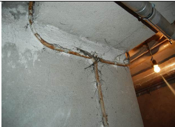
Foto nr. 18. Elektrisüsteem on amortiseerunud.
