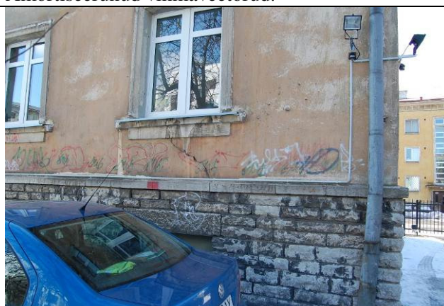
Foto nr. 6. Fassaadil on praod, mis on vaja remontida. Amortiseerunud vihmaveetorud.
