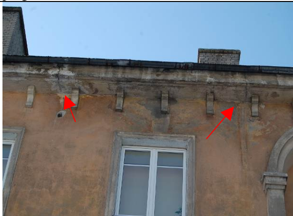
Fotod nr. 3. Räästa sõlm. Amortiseerunud rennid. On näha pragusid.
