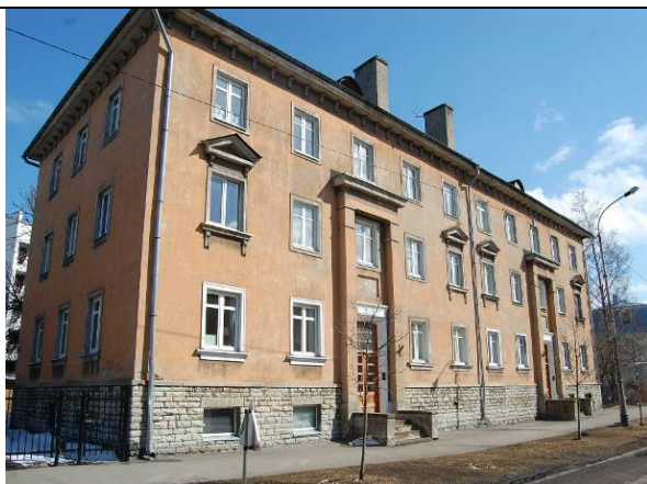
Fotod nr. 3. Räästa sõlm. Amortiseerunud rennid. On näha pragusid.
