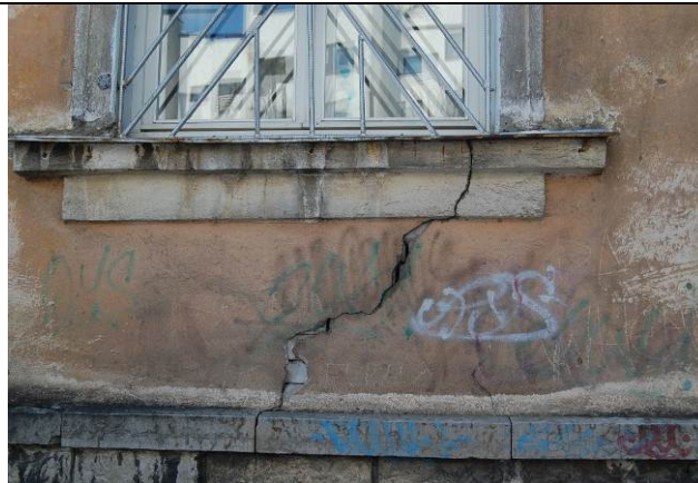
Foto nr. 6. Fassaadil on praod, mis on vaja remontida. Amortiseerunud vihmaveetorud.
