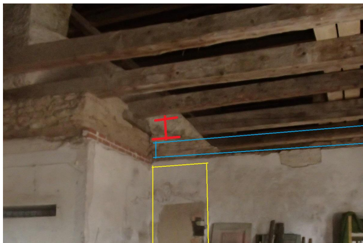
Foto 3. Vaade saali kitsama osa lõunapoolsele seinale teise ruumi poolt. Kollasega markeeritud endine ahju askoht, kuhu taastatakse hiljem kahhelahi, sinisega rajatav betoonvöö vaheseina kooshoidmiseks ja terastala toetamiseks, punasega orienteeruv terastala asukoht.
