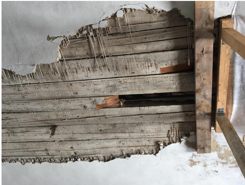
Foto 1. Vaade suure saali laele kohas, kus lahtine krohv on eemaldatud.
