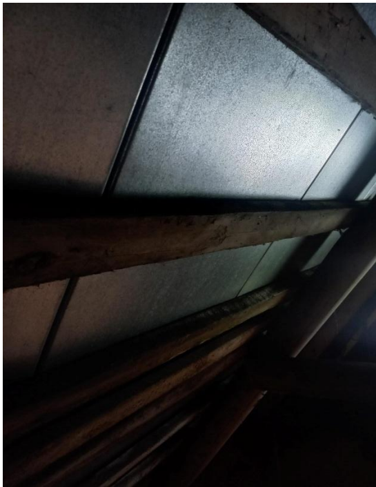
Foto 7 ja 8 - Ebakvaliteetne ja puuduliku teostusega katuse aluskonstruktsioon
