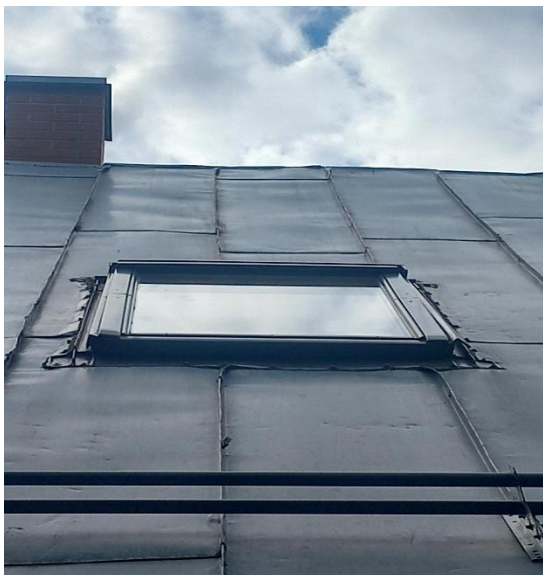
Foto 9 ja 10 - Valesti paigaldatud ja tihendamata välimised avatäited.
