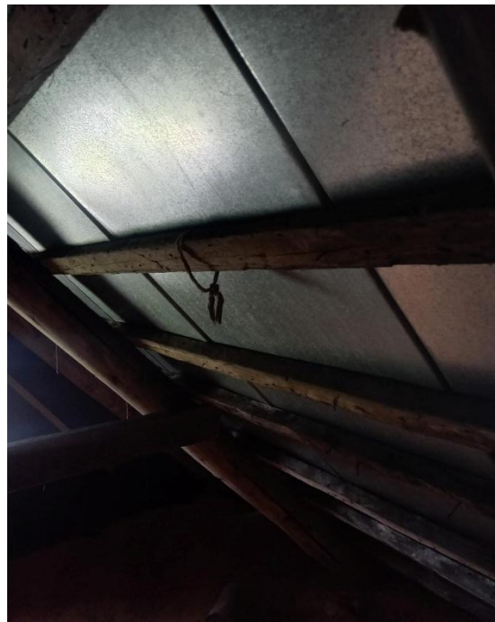
Foto 7 ja 8 - Ebakvaliteetne ja puuduliku teostusega katuse aluskonstruktsioon
