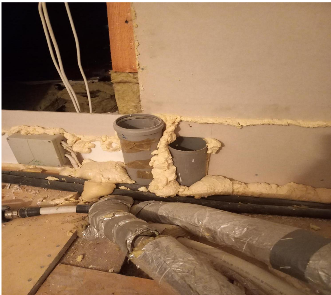
Foto 11 – Valesti rajatud ja lõpuni välja ehitamata väljatõmbe- ja tuulutuskorstnad
