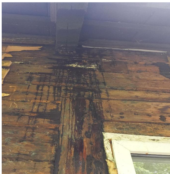
Foto 1 ja 2 – Niiskuskahjustused välisseinte kandekonstruktsioonides.
