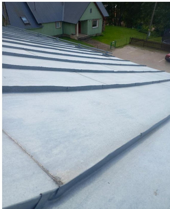
Foto 5 ja 6 Ebakvaliteetne ja puuduliku teostusega katusekate ( valtsplekk )
