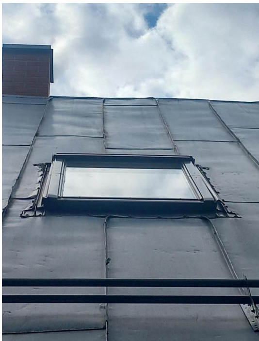
Foto 5 ja 6 Ebakvaliteetne ja puuduliku teostusega katusekate ( valtsplekk )
