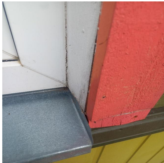
Foto 9 ja 10 - Valesti paigaldatud ja tihendamata välimised avatäited.
