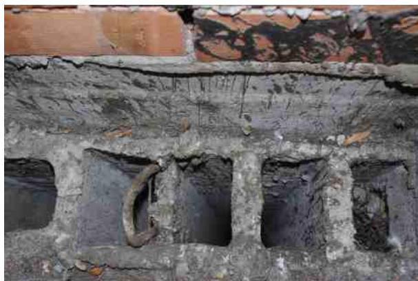
Ventilatsioonilõõrid vajavad puhastamist
